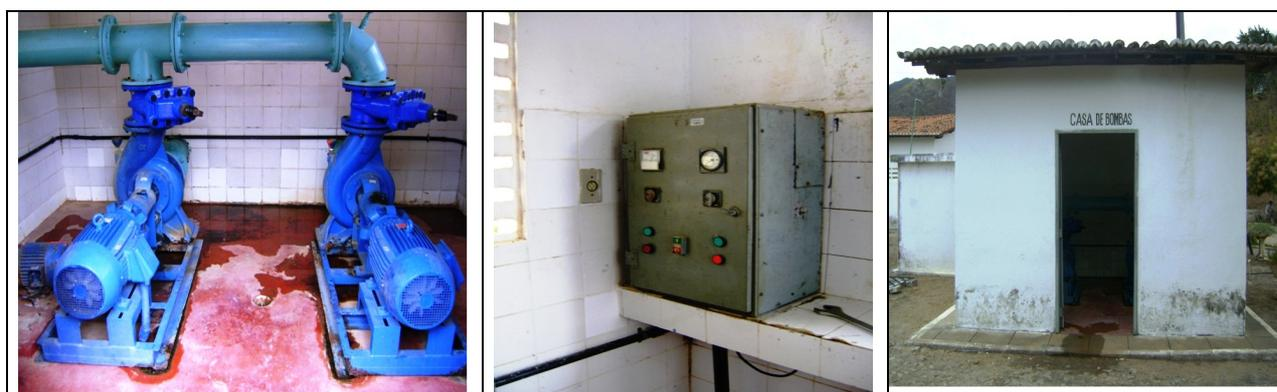
Fotos 26, 27 e 28 – EELF-01 – conjuntos motores-bomba, quadro de comando e casa de abrigo
