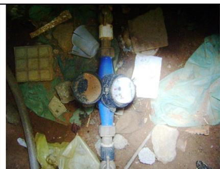
**Foto 42** – Medidor proporcional com lixo na sua caixa de proteção
