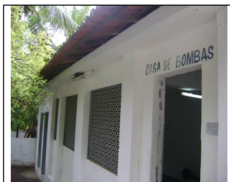
Foto 54 – EEAT-01: sem identificação.
