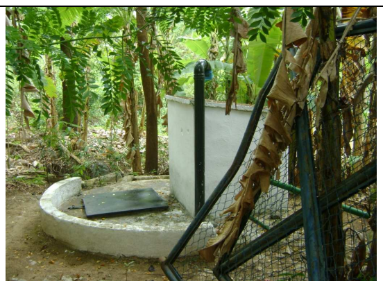
Foto 72 – PR: tubulação de ventilação.
