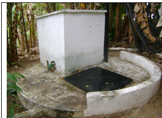
Foto 71 – PR: vista geral do poço de reunião.
