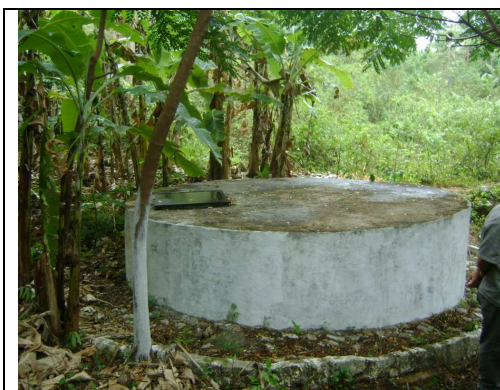
Foto 9 – Vista geral da fonte F-03: sem identificação e tampa de inspeção da nascente.
