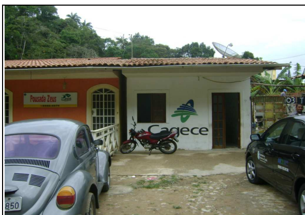
Foto 49 – Vista externa do escritório/loja de atendimento/almoxarifado.
