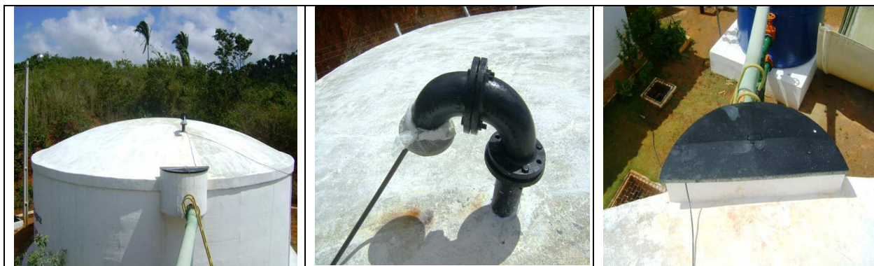
Fotos 25, 26 e 27 – Vistas superiores do RAP-01
