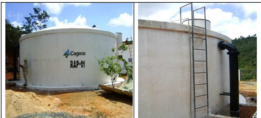
Fotos 23 e 24 – Vistas laterais do RAP-01
