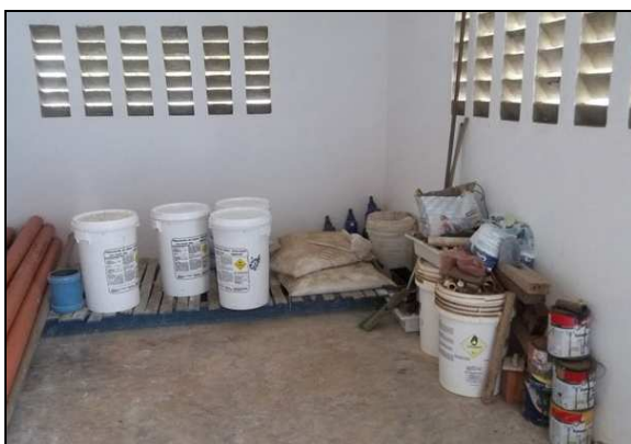
Fotos 14 – Armazenamento adequado de materiais e produtos químicos.
