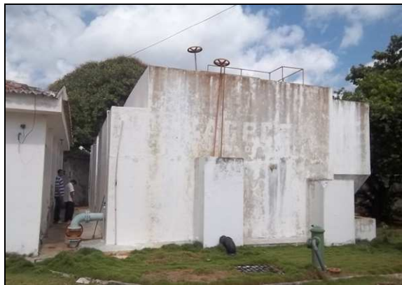
Foto 7 – Vista dos filtros.
