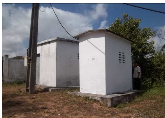
Foto 25 – Prédio de abrigo da EECS-01.
