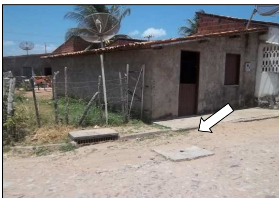
Foto 46 – Registro de descarga localizado na Rua Francisco Batista de Azevedo, Centro.
