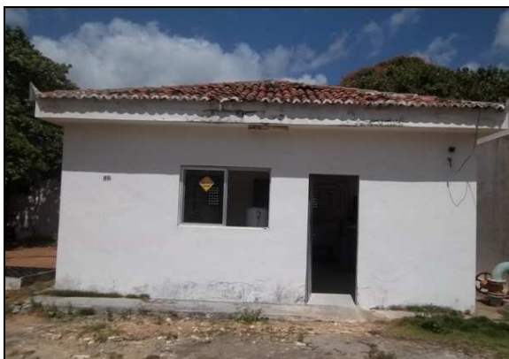
Foto 10 – Vista da casa de química.
