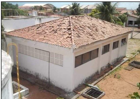
Foto 28 – Prédio de abrigo da EEAT-01.
