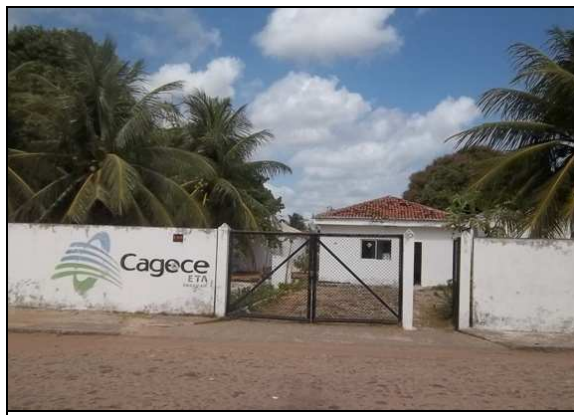
Foto 3 – Entrada da ETA.
