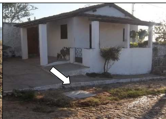
Foto 38 – Registro de descarga localizado na Rua Antônio Rodrigues Barroso, Centro.
