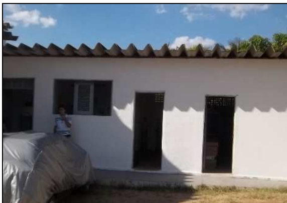
Foto 26 – Prédio de abrigo das EELF-01 e EEAT-01.
