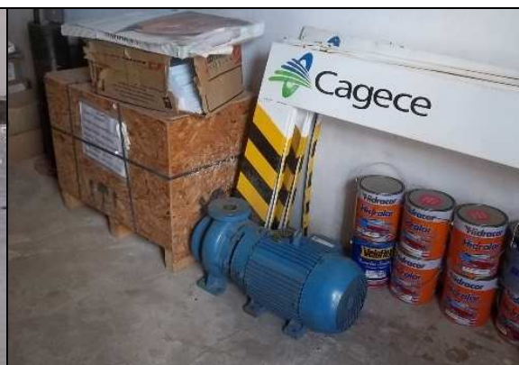
Foto 21 – Bomba reserva da EECS-01.
