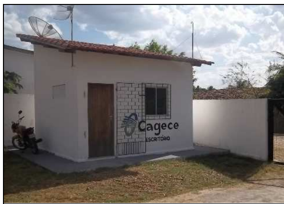
Foto 41 – Vista externa do escritório da CAGECE.
