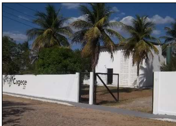
Foto 2 – Entrada da ETA.
