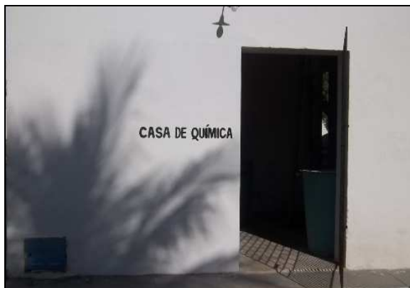
Foto 5 – Vista da casa de química.
