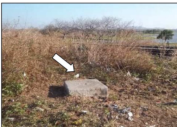
Foto 37 – Registro de descarga localizado na Rua José Linhares, Centro.
