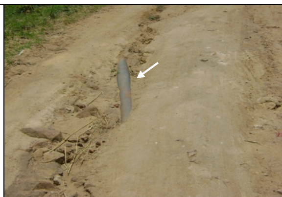
Foto 16 – Adutora de água bruta: Tubulação exposta.
