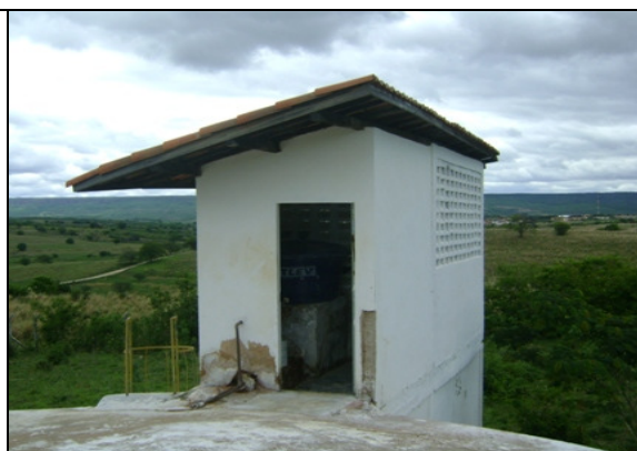
Foto 10 – Vista da casa de química.
