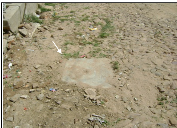
Foto 29 – Registro de descarga localizado na Rua Padre Cícero.
