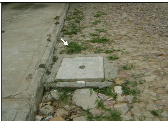
Foto 28 – Registro de descarga localizado na Rua Luís Lacerda.
