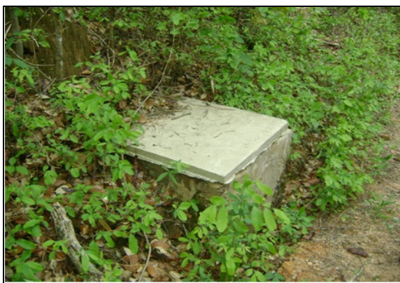
Foto 13 – Caixa de ventosa da adutora de água bruta.
