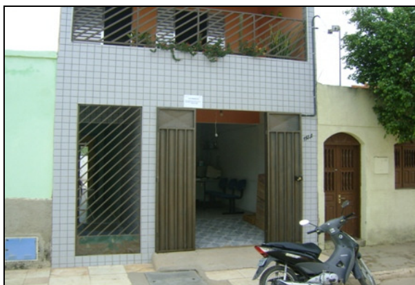
Foto 37 – Vista externa do escritório provisório de atendimento ao usuário, sem identificação da CAGECE.
