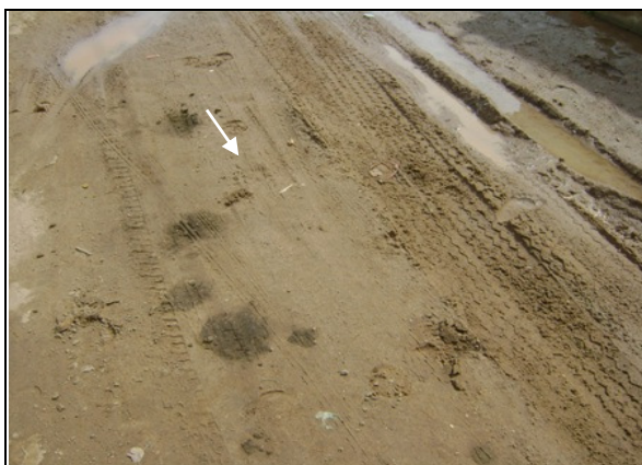
Foto 33 – Registro de descarga localizada na Rua Alves Cavalcante: soterrado.
