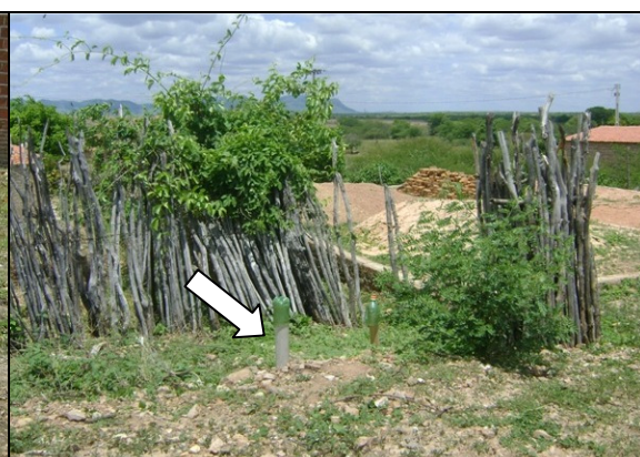
Foto 35 – Registro de descarga, sem caixa de proteção, localizado na Rua Dom Quintino, Centro.
