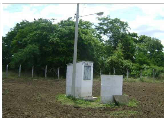
Foto 21 – Prédio de abrigo do quadro de comando da EEPT-04.
