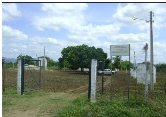
Foto 1 – Entrada e sinalização da captação.
