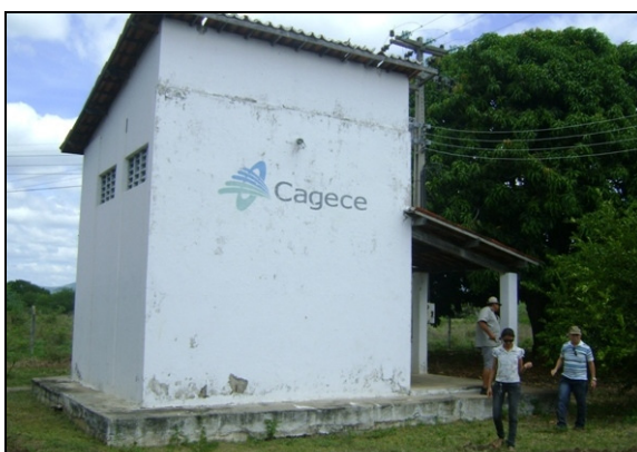
Foto 4 – Prédio de abrigo dos produtos químicos e do quadro de comando da EEPA-01.
