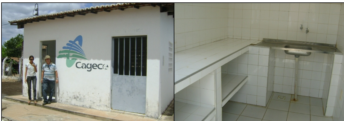
Fotos 6 e 7 – Vistas da edificação que abriga a casa de química e o laboratório, que encontram-se desativados.
