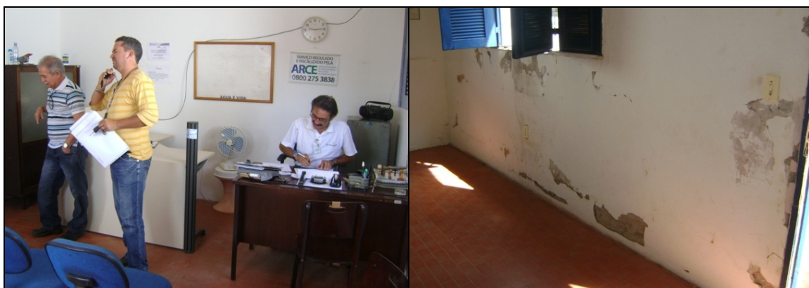
Fotos 43 e 44 – Vistas internas do escritório da CAGECE.
