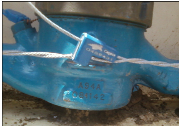
Foto 52 – Hidrômetro da ligação.
