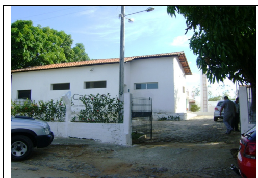
Foto 5 – Vista da entrada da ETA do SAA de Itapiúna
