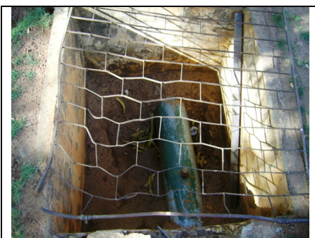
Foto 38 – Estação pitométrica na adutora de água bruta
