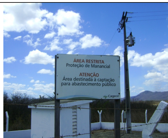
Foto 2 – Sinalização da área de captação
