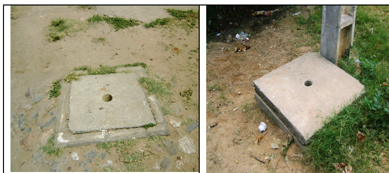
Fotos 48 e 49 – Registros de descarga nas Ruas Manoel Gustavo e Cosmo Santos
