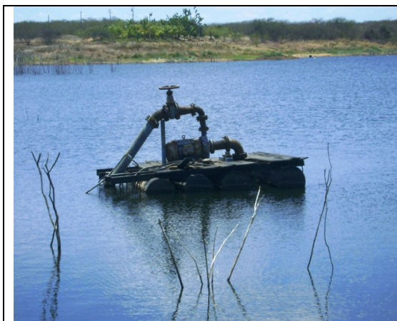
Foto 1 – Detalhe do flutuante
