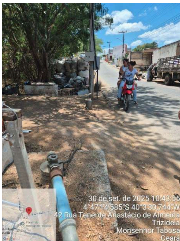
Foto 13 - PT-63: com fiação exposta e sem laje de proteção.
