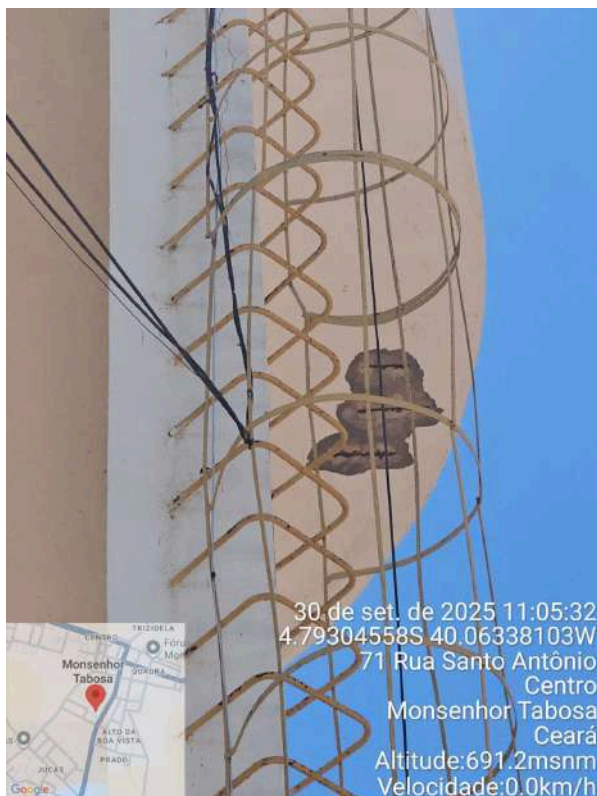
Foto 21 - REL-01: armadura aparente.
