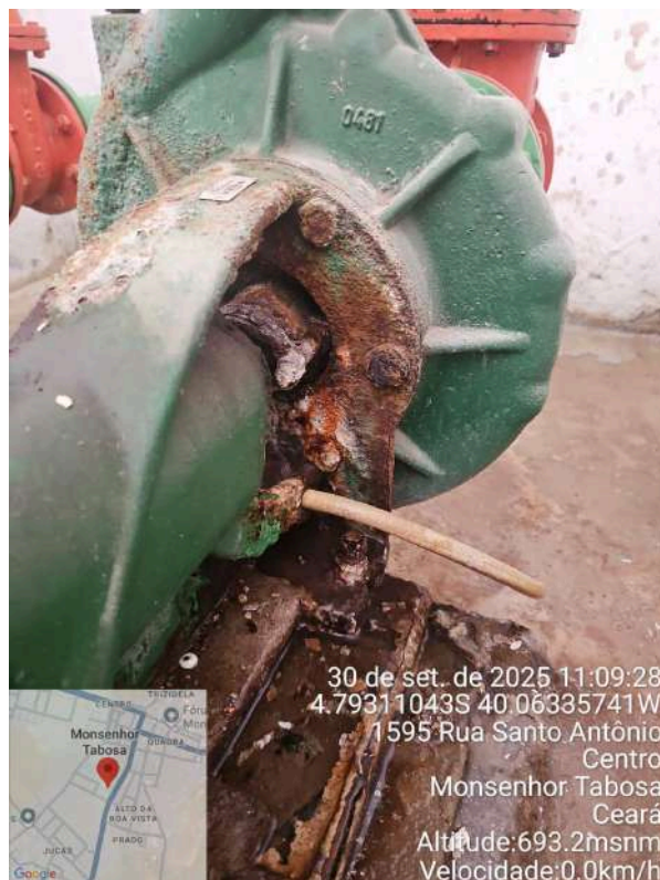
Foto 24 - ETA: vazamento na bomba.
