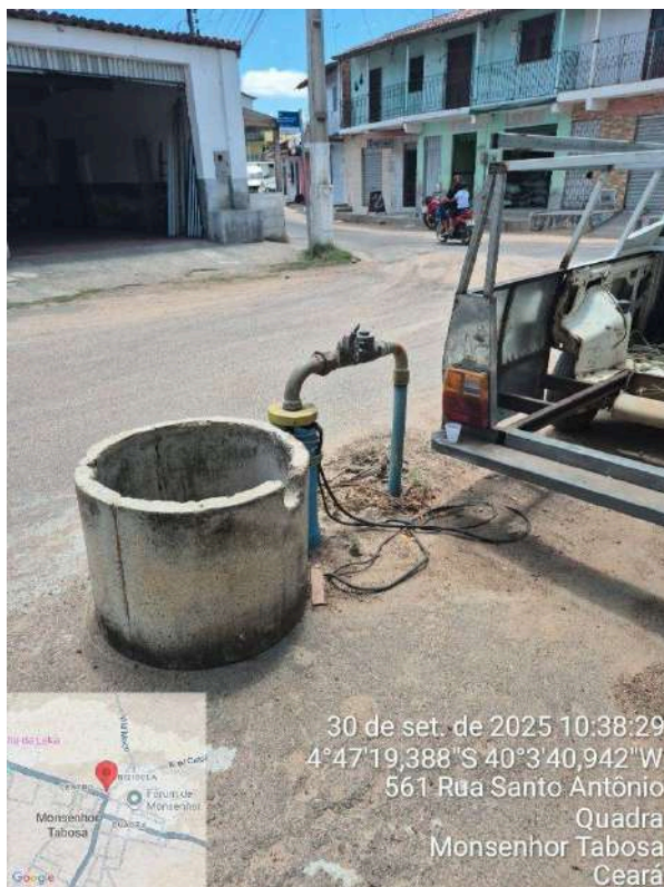
Foto 11 - PT-48: com fiação exposta e sem laje de proteção.
