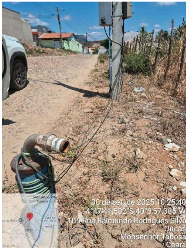
Foto 15 - PT-37 (poço desativado): com fiação exposta e sem laje de proteção.
