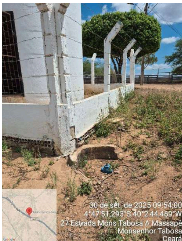
Foto 3 - REL-03: registro sem caixa de proteção.
