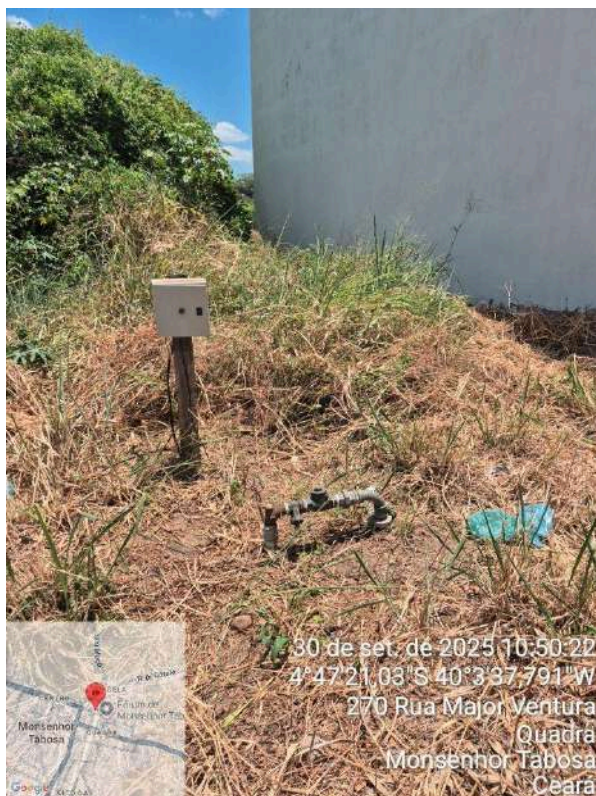
Foto 7 - PT-06: com fiação exposta e sem laje de proteção.
