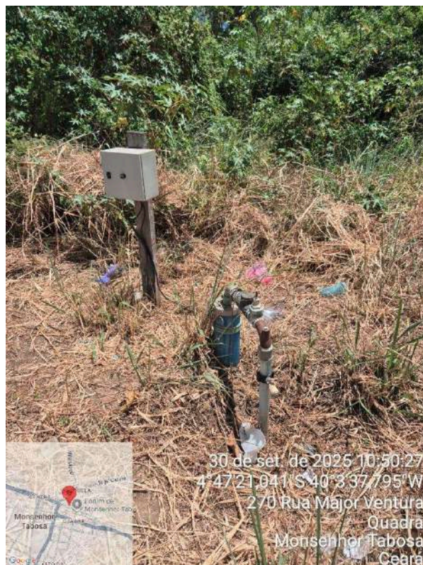
Foto 8 - PT-07: com fiação exposta e sem laje de proteção.
