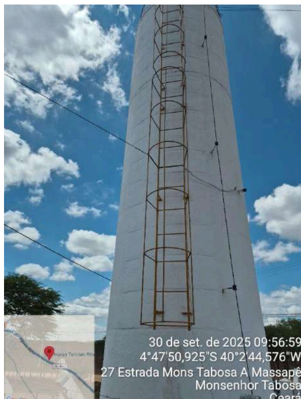
Foto 4 - REL-03: fiação transpassando a escada de acesso.
