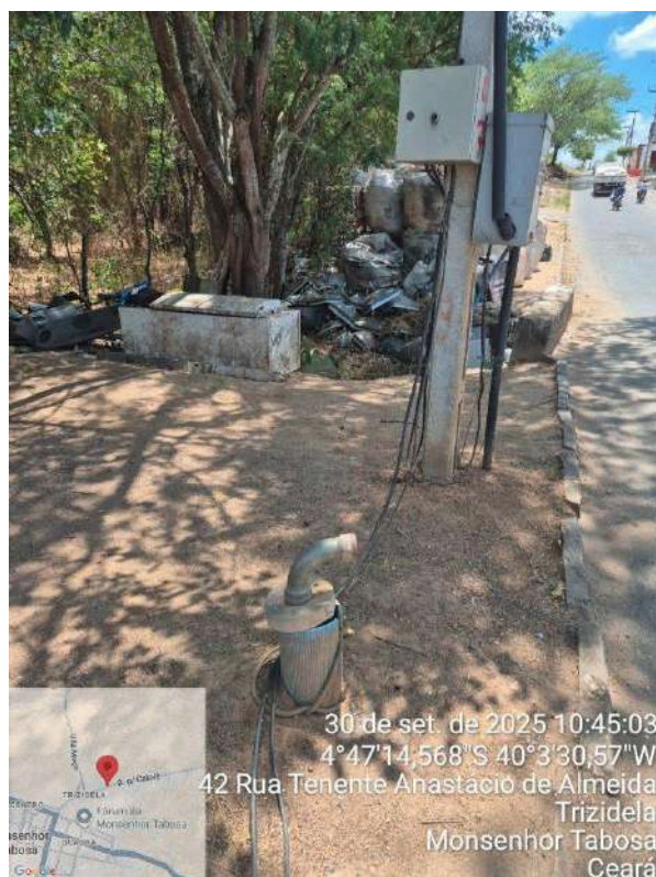
Foto 14 - PT-09 (poço desativado): com fiação exposta e sem laje de proteção.
