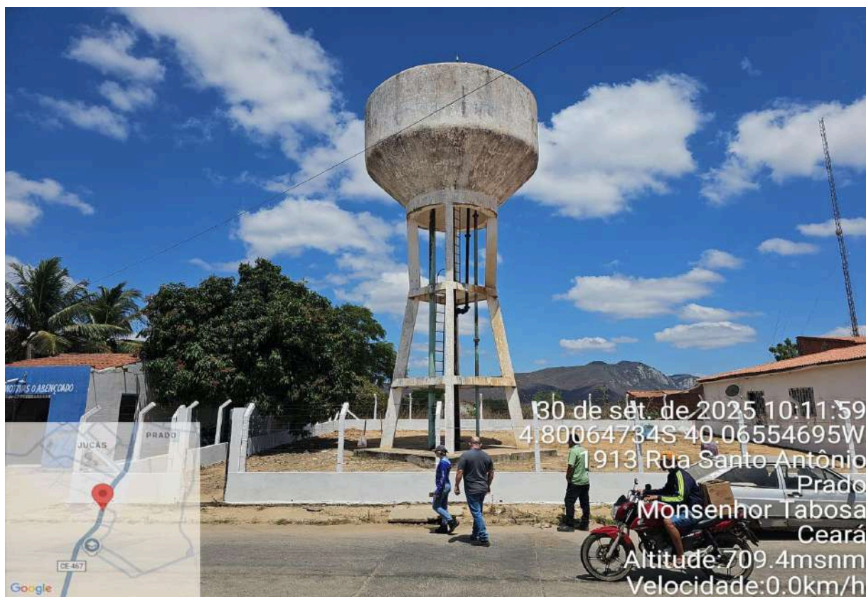
Foto 19 - REL-02: pintura desgastada e armadura aparente.
