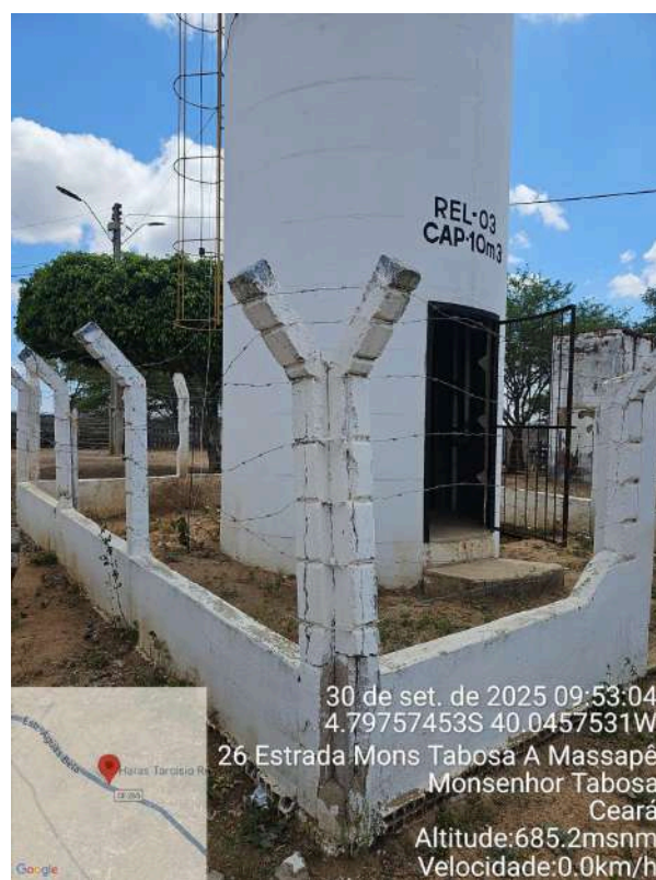
Foto 18 - REL-03 (área privada): fechamento com rachaduras e armadura aparente.
