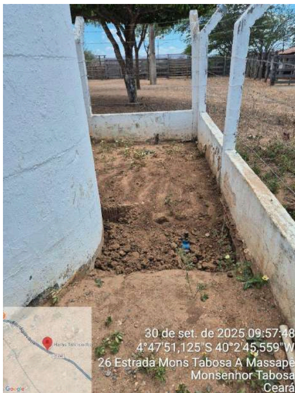
Foto 1 - REL-03: registro sem caixa de proteção.
