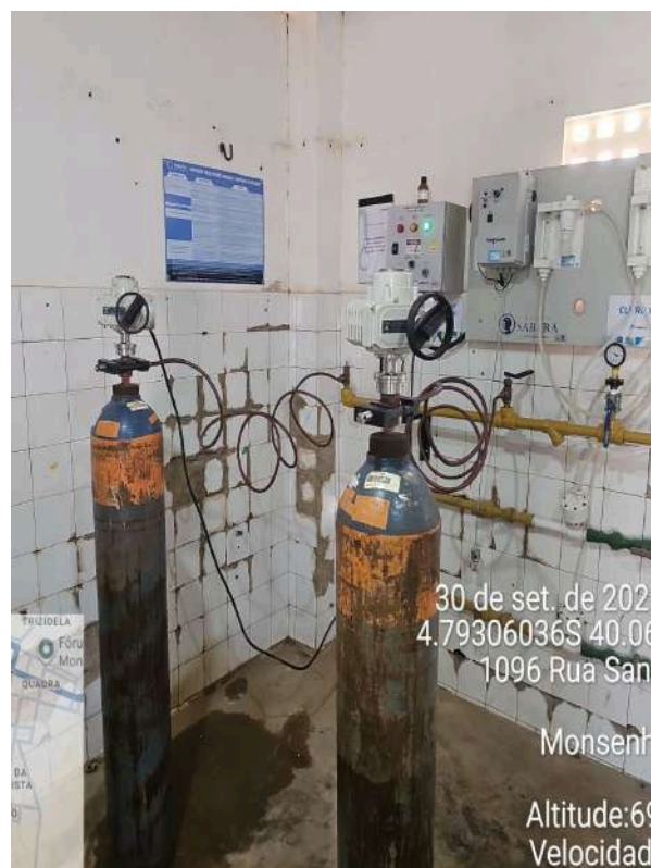
Foto 26 - Cloração: revestimento das paredes desgastadas e área servindo de depósito de material.
