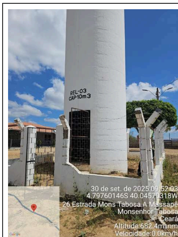
Foto 17 - REL-03 (área privada): fechamento com rachaduras e armadura aparente.
