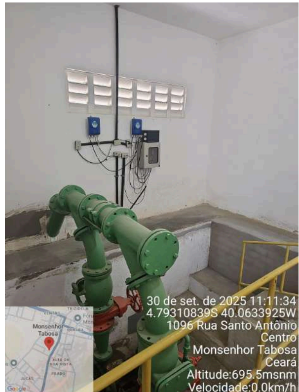
Foto 16 - ETA: área das bombas sem guarda corpo.
