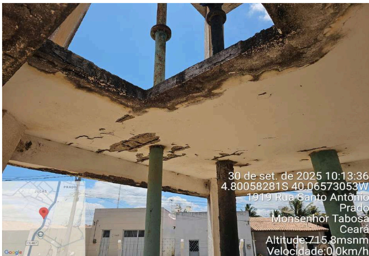
Foto 20 - REL-02: armadura aparente.
