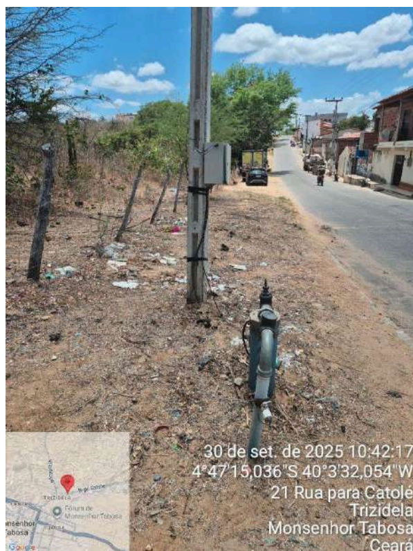
Foto 10 - PT-14: com fiação exposta e sem laje de proteção.
