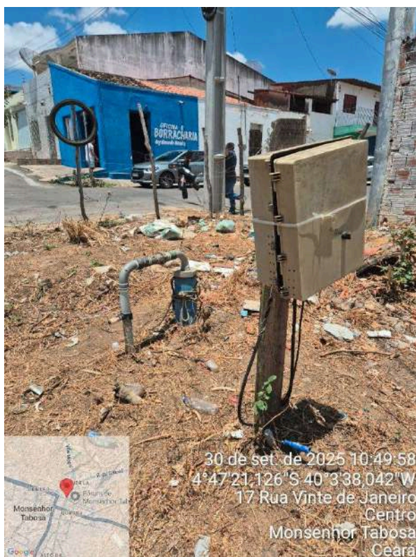
Foto 9 - PT-08: com fiação exposta e sem laje de proteção.
