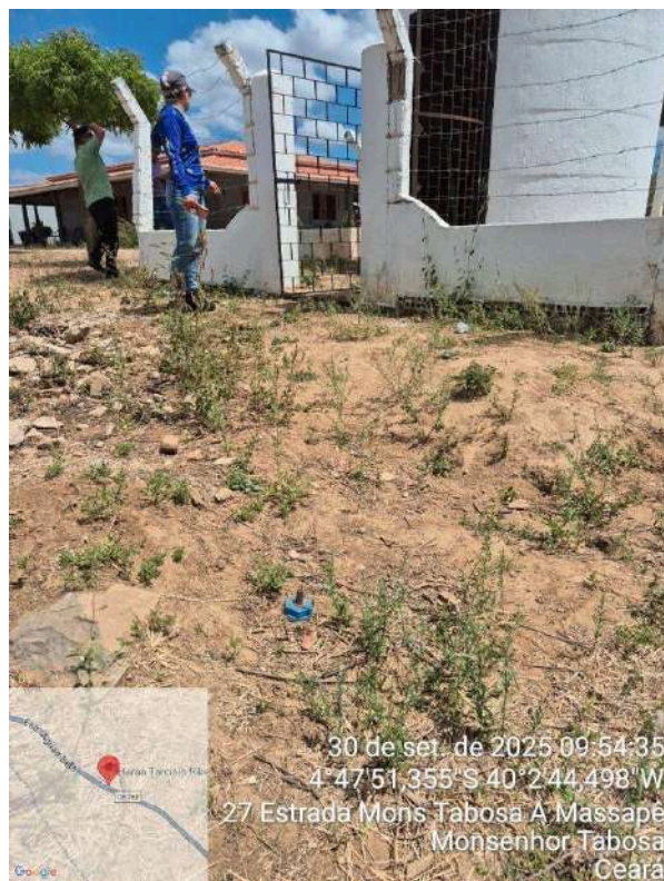
Foto 2 - REL-03: registro sem caixa de proteção.
