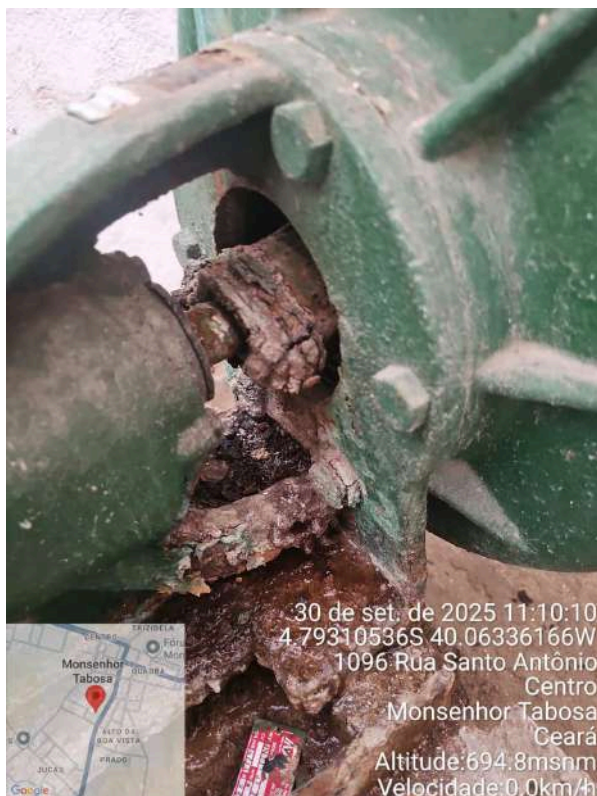
Foto 23 - ETA: vazamento na bomba.
