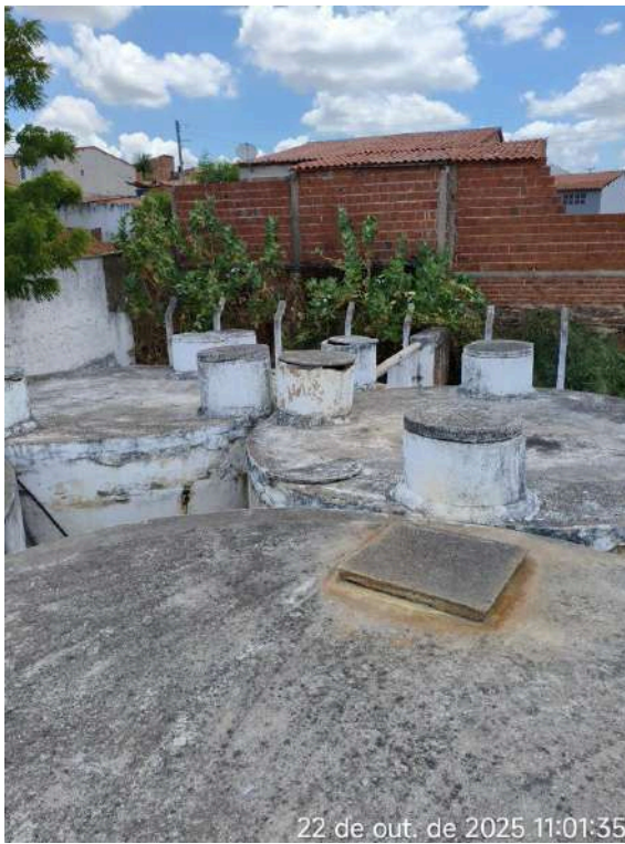
Foto 41 - ETE: tanques sem guarda-corpo de apoio e proteção.
