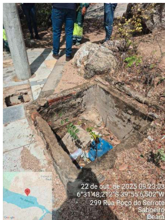
Foto 17 - Caixa do registro da adutora: não possui tampa.
