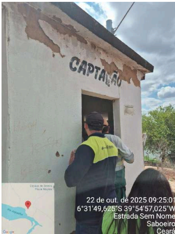
Foto 14 - Casa do Quadro de Comando apresenta pintura desgastada, paredes e tetos com reboco deteriorado.
