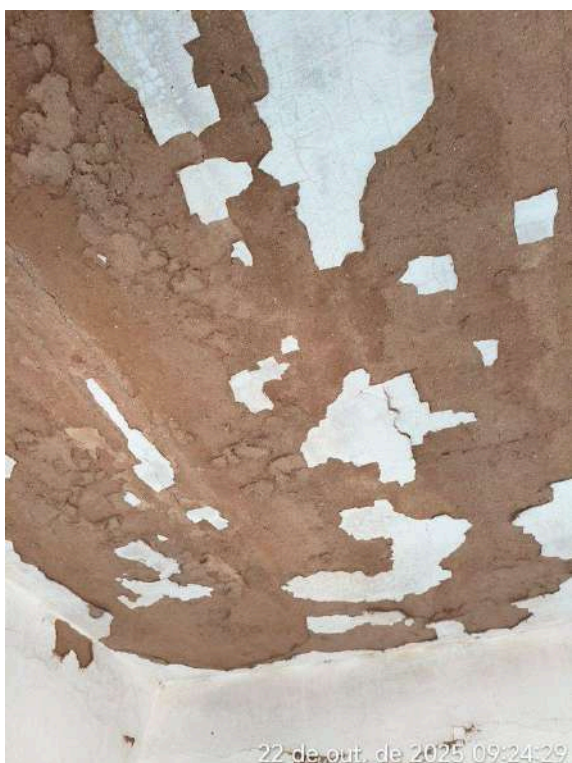
Foto 16 - Casa do Quadro de Comando apresenta pintura desgastada, paredes e tetos com reboco deteriorado.
