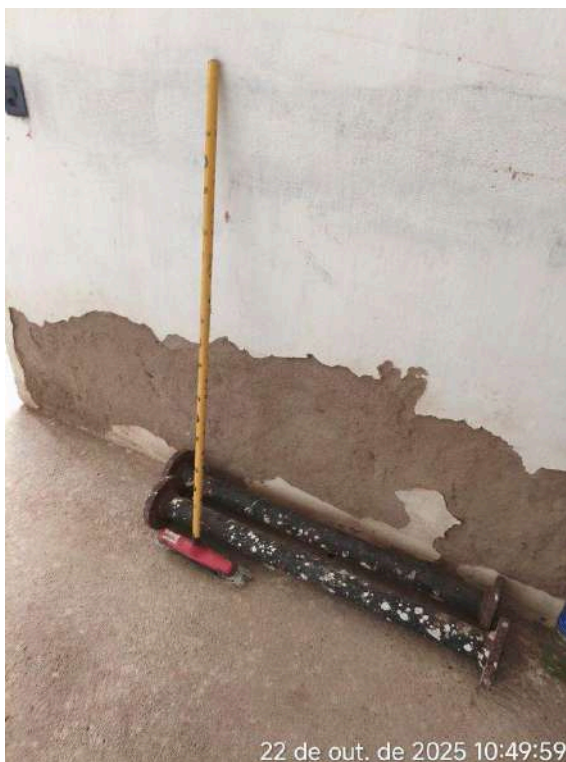
Foto 33 - EERD-01 (Booster): reboco interno e pintura desgastados.
