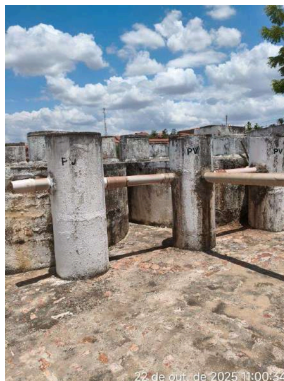
Foto 36 - ETE: infraestruturas apresentam pinturas deterioradas.
