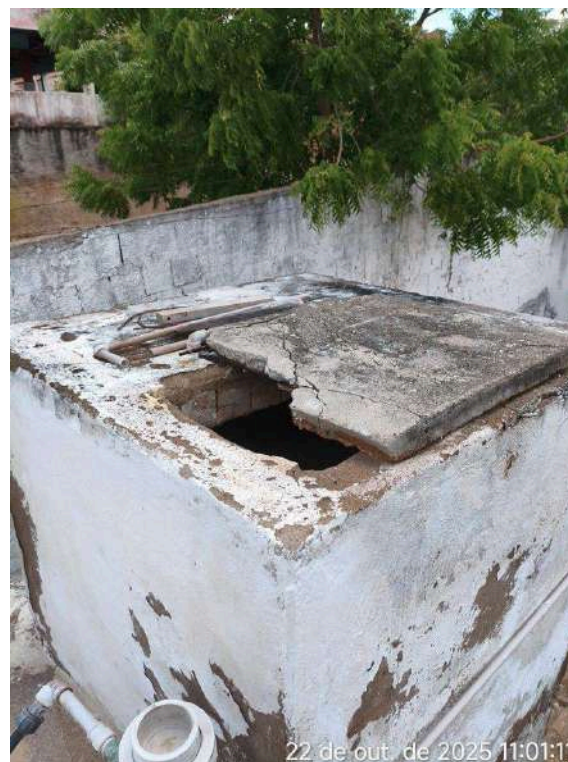
Foto 38 - ETE: tampa da entrada de inspeção danificada.
