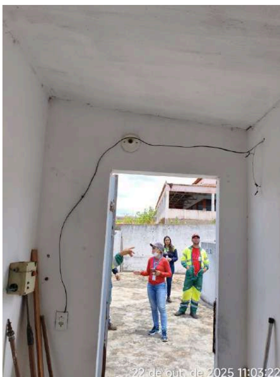
Foto 39 - ETE: casa de apoio sem lâmpada e instalações elétricas inadequadas.
