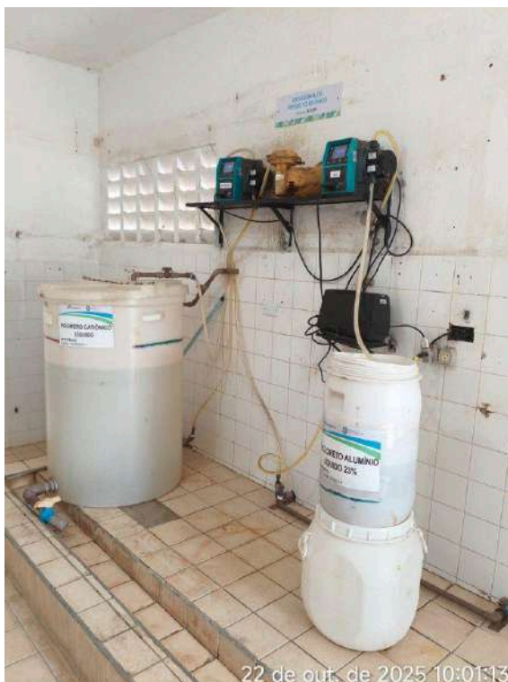
Foto 24 - Casa de química: instalações elétricas precárias com tomadas sem tampas e fiação exposta.
