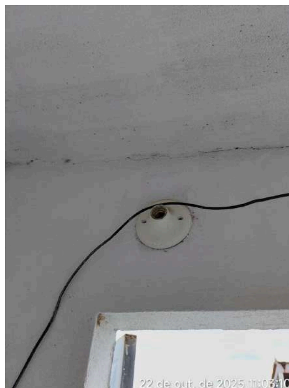
Foto 40 - ETE: casa de apoio sem lâmpada e instalações elétricas inadequadas.
