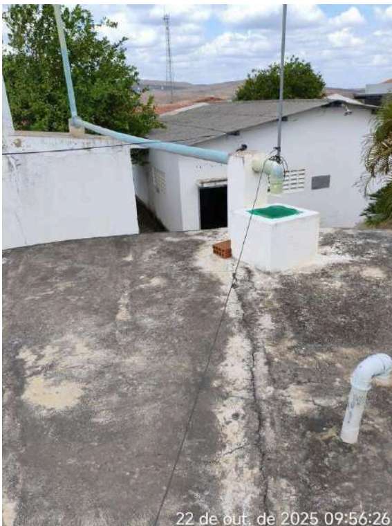
Foto 4 - RAP-01: ausência de tampa de proteção e fechamento hermético em chaminé de entrada d'água.
