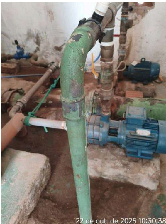
Foto 22 - EEAT: falha na drenagem, com piso molhado; reboco deteriorado.
