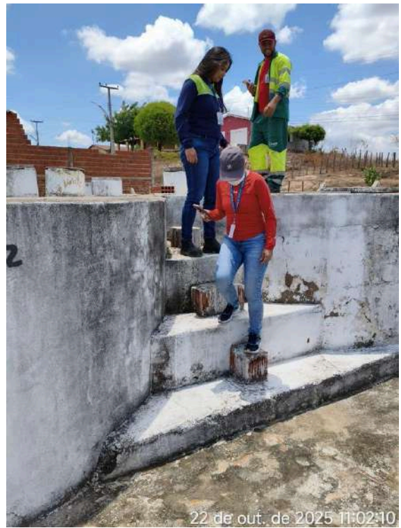
Foto 42 - ETE: escada sem corrimão de apoio e proteção.
