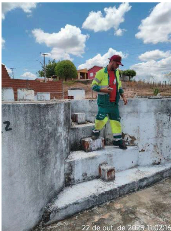
Foto 37 - ETE: infraestrutura apresenta pinturas deterioradas.
