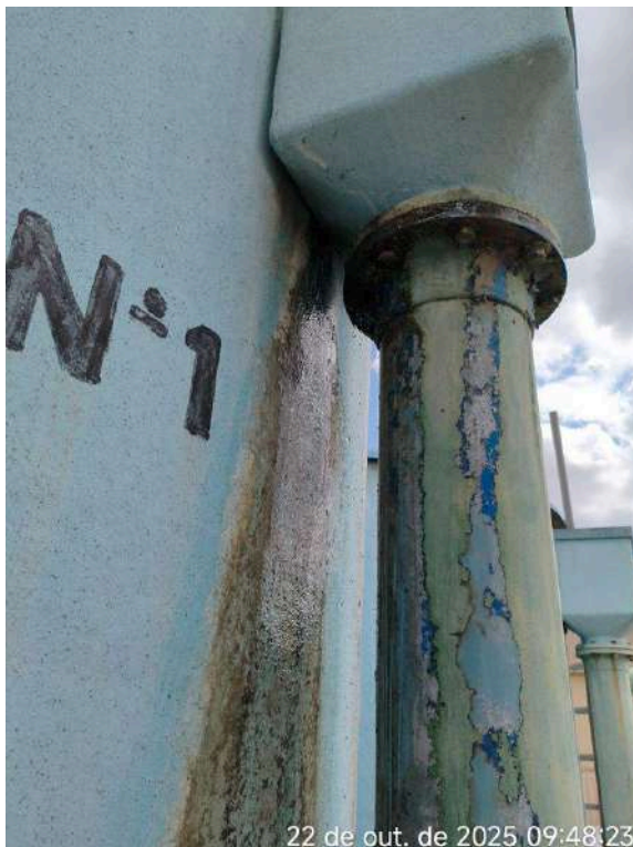
Foto 18 - F-01: registros apresentam vazamento.
