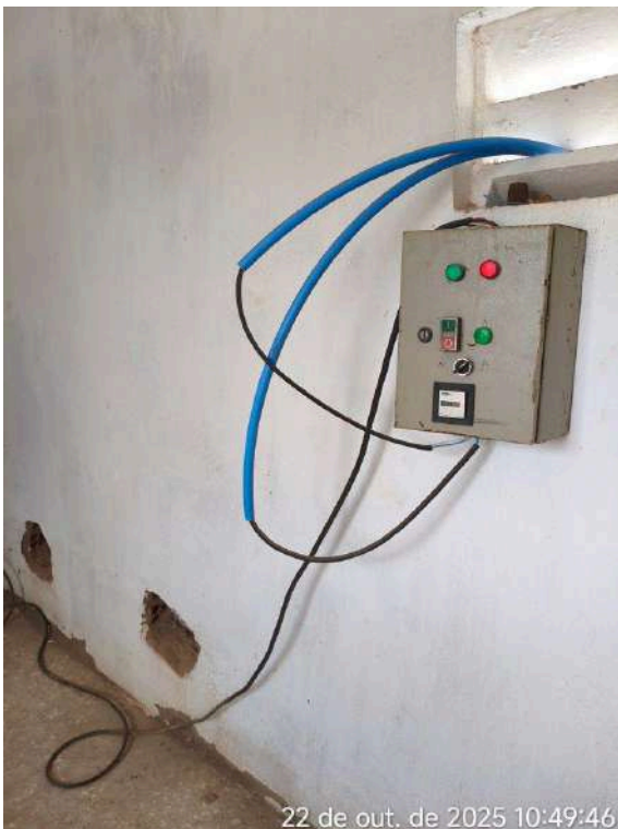
Foto 8 - EERD-01 (Booster): instalações elétricas precárias, implantadas através de cobogós e sobre o piso da área de circulação.
