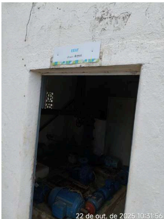
Foto 20 - EEAT: falha na drenagem, com piso molhado; reboco deteriorado.
