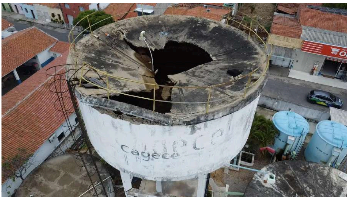
Foto 28 - REL-01: apresenta cobertura e guarda corpo destruído, pintura desgastada desgastada.
