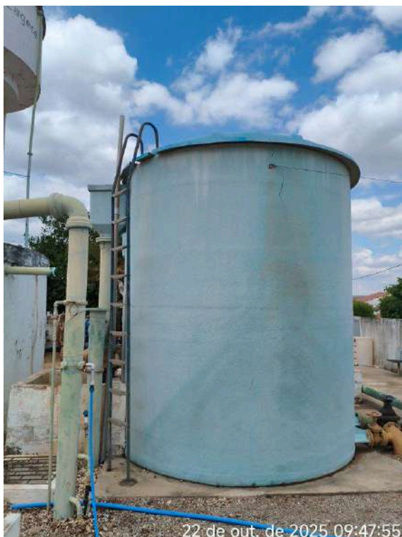
Foto 2 - Filtro: escada inadequada, sem gaiola de proteção e guarda-corpo acima do patamar superior.
