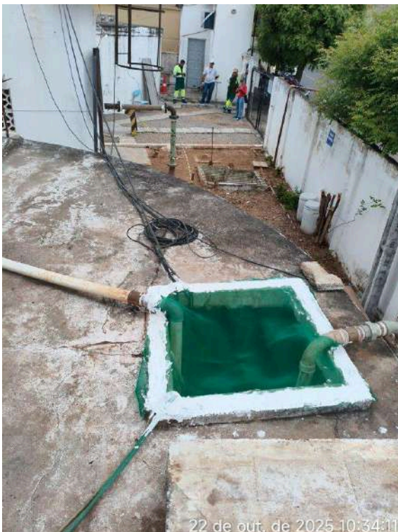
Foto 6 - RAP-02: instalações precárias por sobre a laje do reservatório, sem eletroduto de isolamento e proteção; tubulação instalada através da abertura de inspeção sem tampa de proteção e fechamento hermético.
