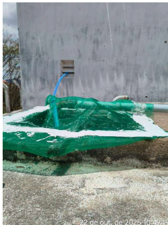
Foto 11 - EERD-01 (Booster): instalações elétricas implantadas através da abertura de inspeção sem tampa de proteção e fechamento hermético.
