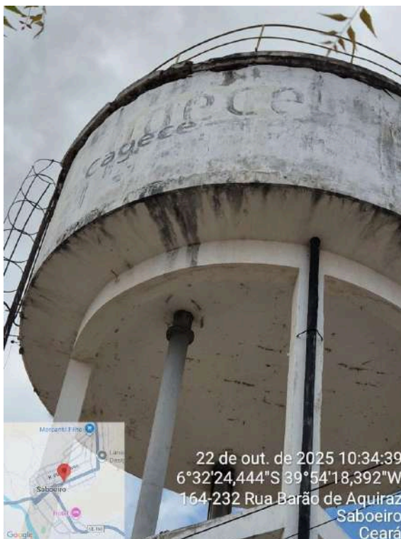
Foto 29 - REL-01: tubulações em processo de corrosão e pintura desgastada.
