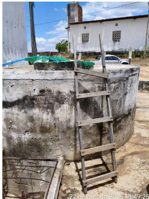
Foto 7 - RAP-03: escada inadequada, sem gaiola de proteção e guarda-corpo acima do patamar superior; tubulação instalada através da abertura de inspeção sem tampa de proteção e fechamento hermético.
