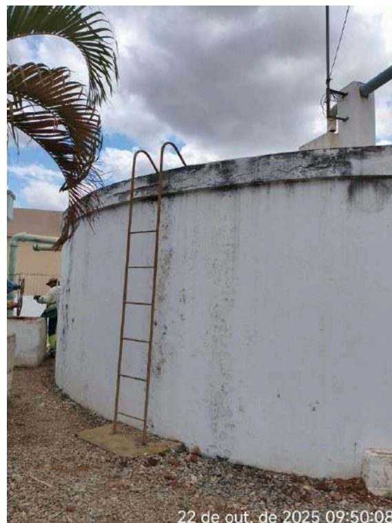
Foto 3 - RAP-01: escada inadequada, sem gaiola de proteção e guarda-corpo acima do patamar superior.
