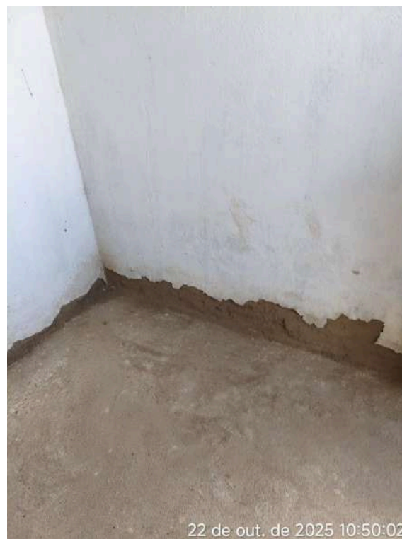
Foto 34 - EERD-01 (Booster): reboco externo e pintura desgastados.
