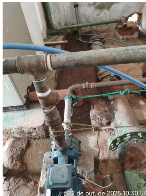
Foto 21 - EEAT: falha na drenagem, com piso molhado; reboco deteriorado.
