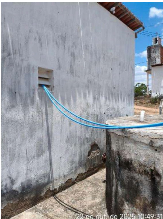
Foto 10 - EERD-01 (Booster): - EERD-01 (Booster): instalações elétricas precárias, implantadas através de cobogós.
