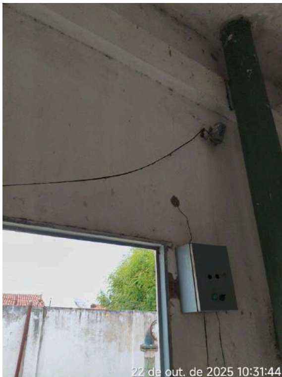
Foto 12 - EEAT: as instalações elétricas são precárias, sem eletroduto de isolamento e proteção.
