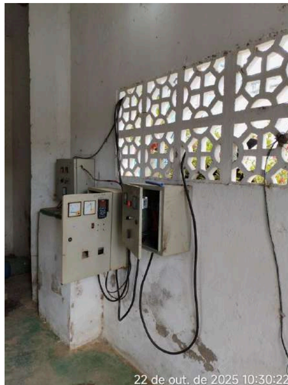
Foto 13 - EEAT: as instalações elétricas são precárias, implantadas através de cobogós, sem eletroduto de isolamento e proteção.
