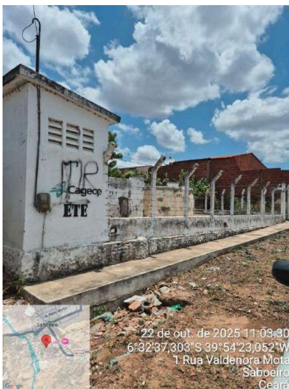
Foto 35 - ETE: infraestruturas apresentam pinturas deterioradas.
