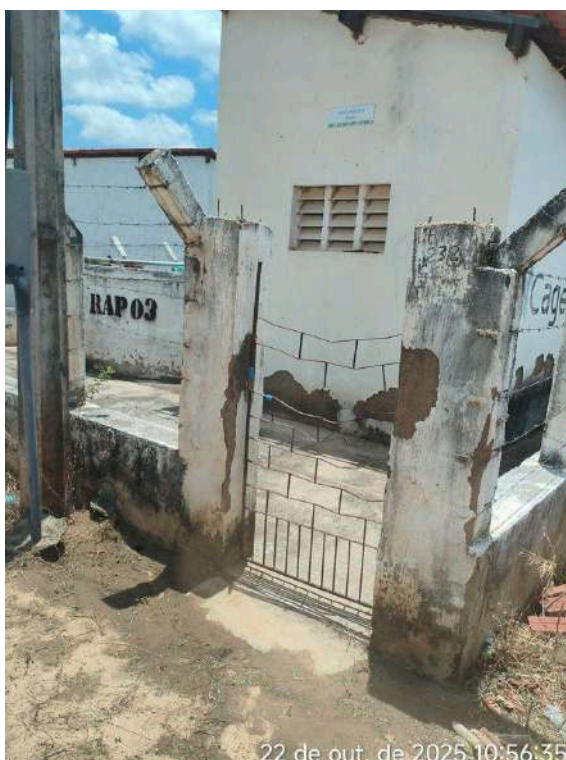
Foto 31 - RAP-03: reboco externo e pintura desgastados.
