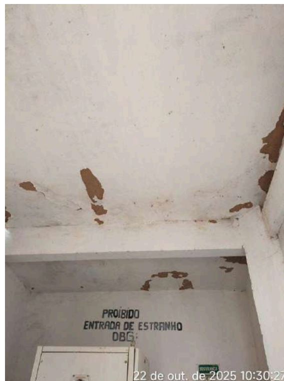
Foto 23 - EEAT: teto com reboco deteriorado.
