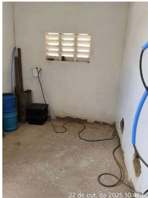
Foto 9 - EERD-01 (Booster): instalações elétricas precárias, implantadas através de cobogós e sobre o piso da área de circulação.
