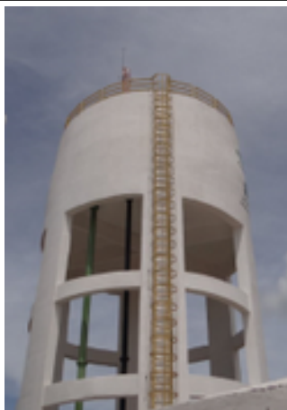
Foto 6 – REL-11: não existe protetor contra danos mecânicos no para-raios.
