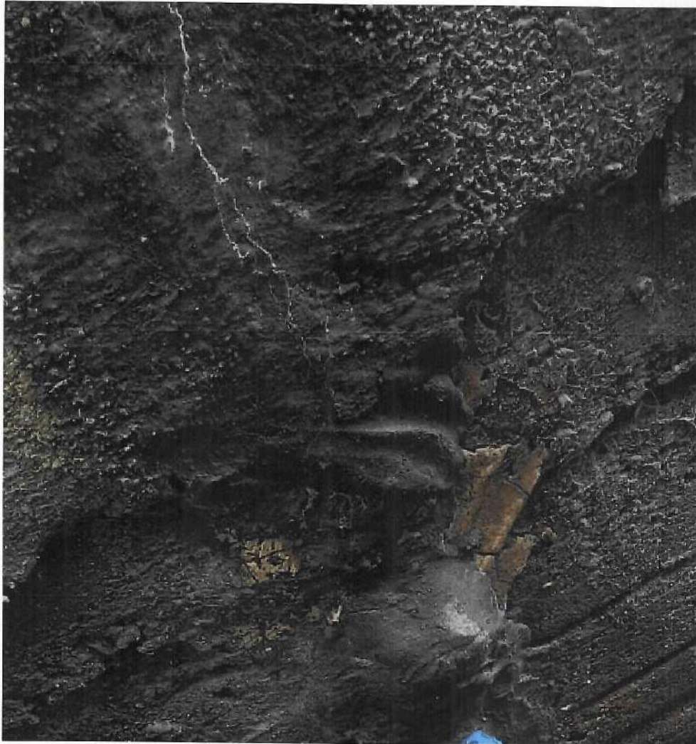
RETIRADA DE VAZAMENTO.
