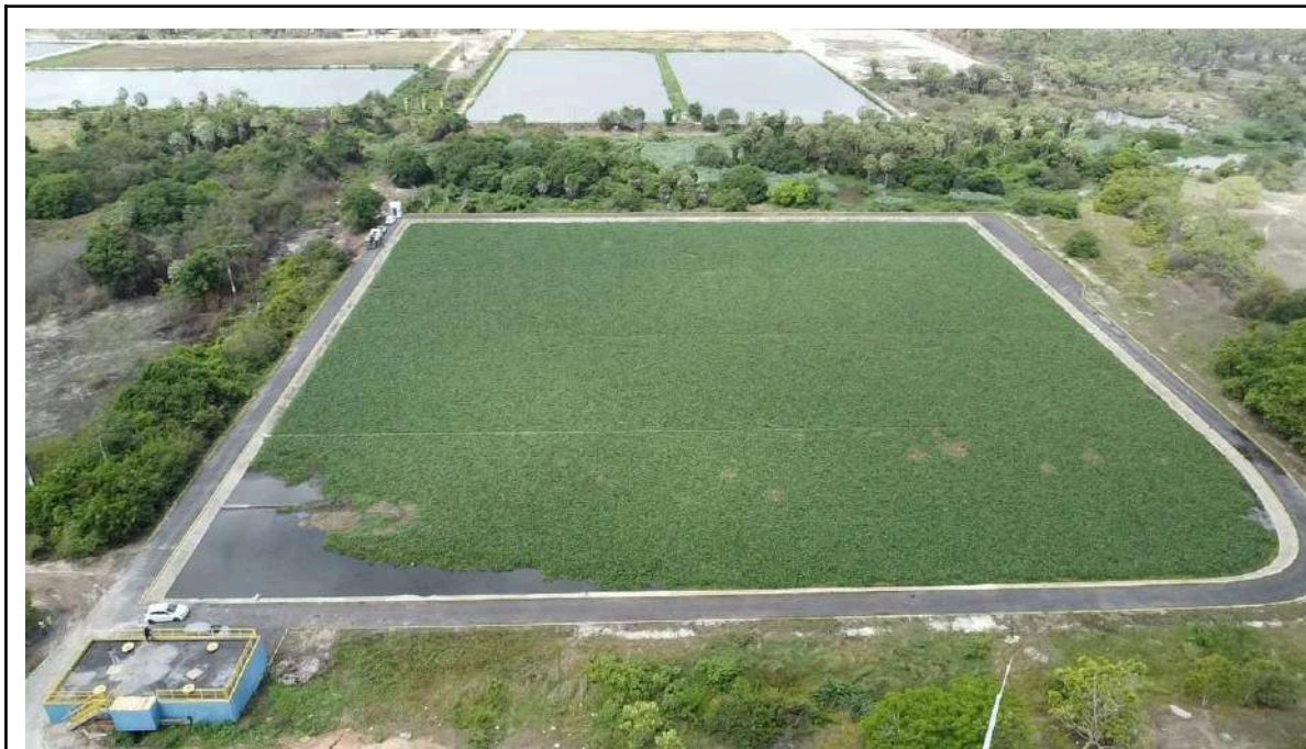
Foto 60 - ETE Riviera (lagoa de maturação): proliferação de macrófitas; indícios de assoreamento.
