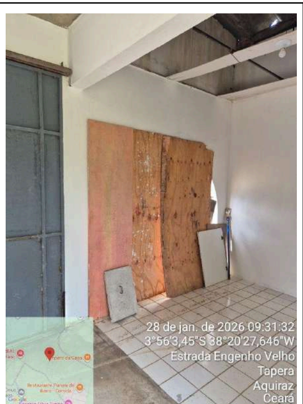
Foto 21 - ETA Riviera (geral): abertura na parede vedada de forma improvisada com madeirite.
