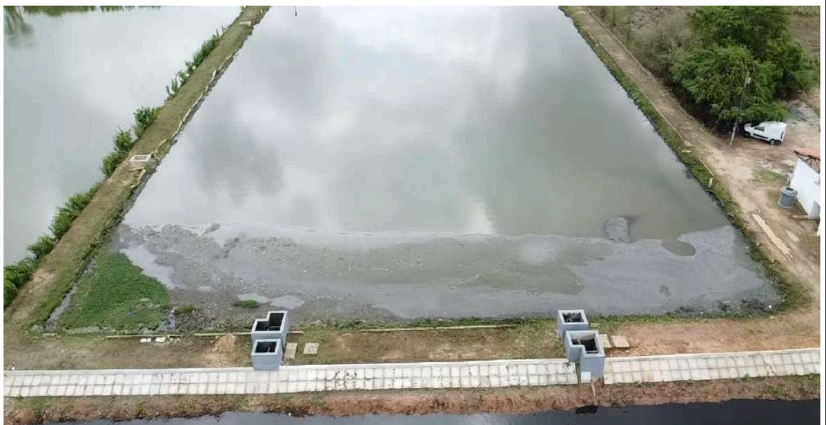
Foto 55 - ETE Aquiraz/Eusébio (lagoa anaeróbia): indícios de zonas mortas; presença de vegetação no entorno.
