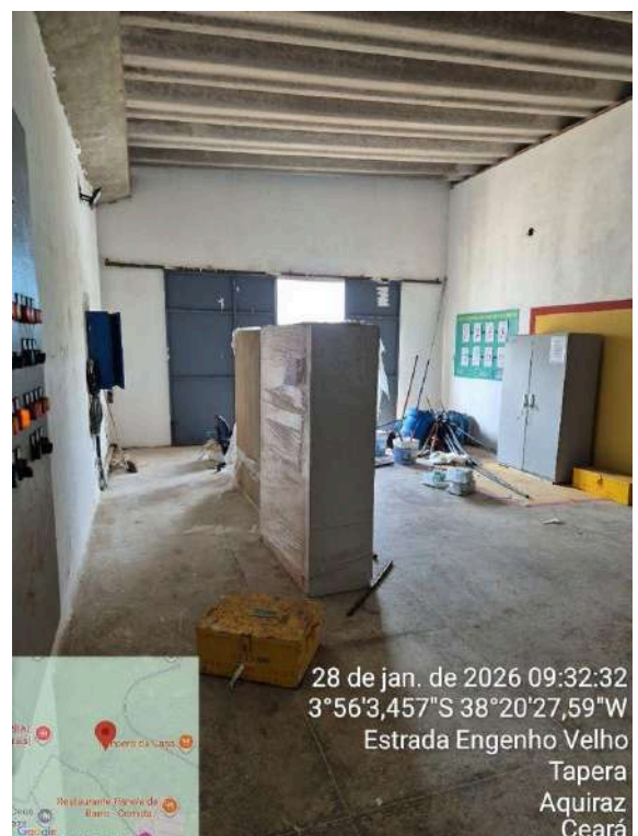
Foto 27 - ETA Riviera (casa de comando): desorganização generalizada, com materiais e equipamentos espalhados pelo piso.
