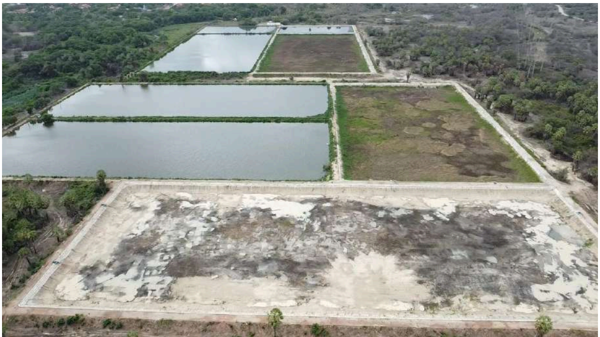
Foto 59 - ETE Aquiraz/Eusébio (lagoa de maturação): lagoas inoperantes.
