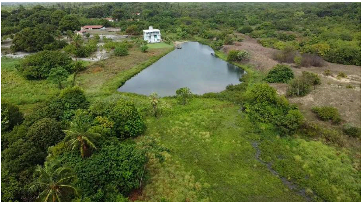
Foto 40 - ETA Riviera (ETRG): indícios de descarte incorreto de efluente.
