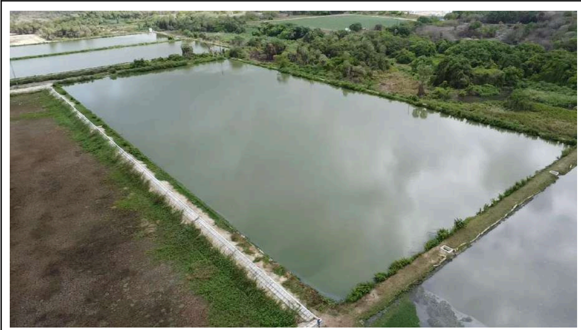
Foto 58 - ETE Aquiraz/Eusébio (lagoa facultativa): presença de vegetação no entorno.
