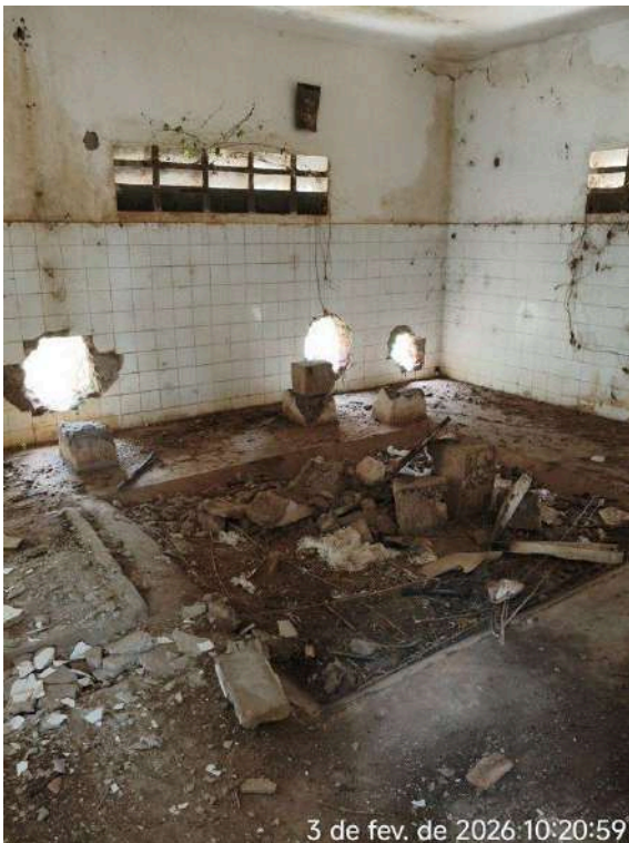
Foto 40 - ETA-01 - Taboleiro dos Mendes: unidade desativada em estado de abandono total, infraestrutura em degradação e entulhos.
