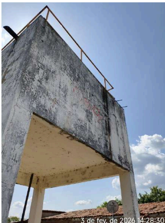
Foto 51 - REL-02 (Vila Mariana): pintura deteriorada e infraestrutura com rachaduras e ferragens expostas.
