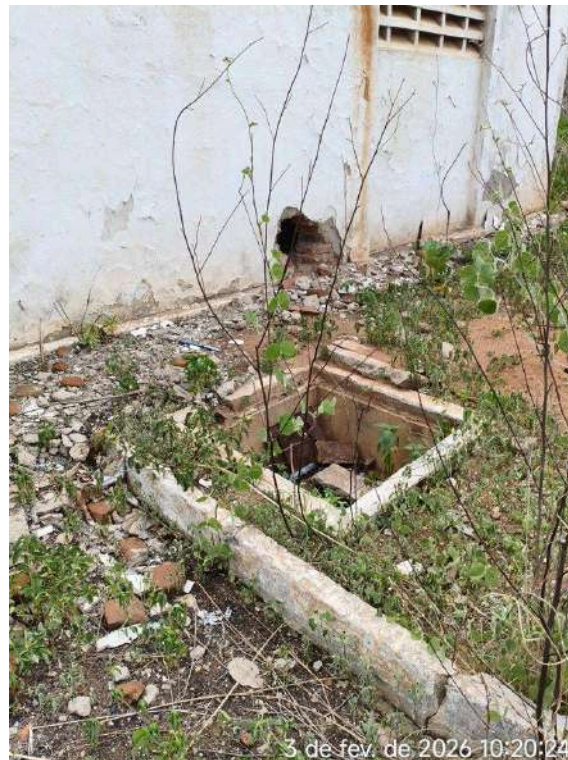
Foto 41 - ETA-01 - Taboleiro dos Mendes: unidade desativada em estado de abandono total, caixas sem tampas e entulhos.
