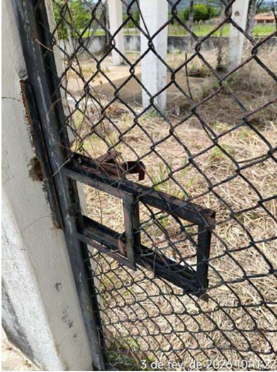
Foto 57 - REL-03 (Taboleiro dos Mendes): infraestrutura desativada sem proteção ao acesso de terceiros (portão sem tranca).
