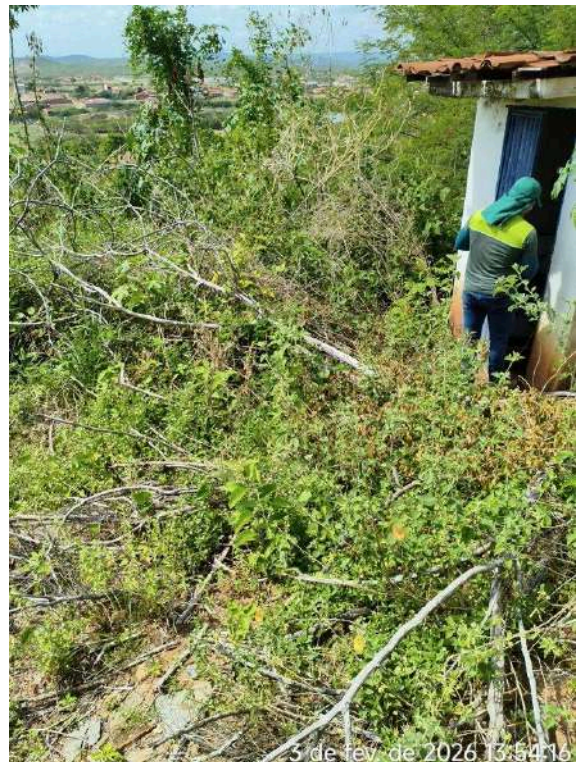
Foto 60 - RAP-04: área com mato alto e cerca danificada.
