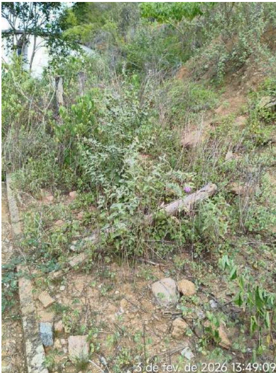
Foto 61 - RAP-04: área com mato alto e cerca danificada.
