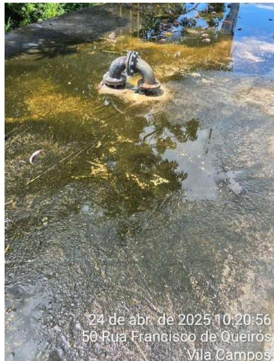
**Foto 76** - RAP-04: tampa e tubulação oxidada com risco de contaminação; acúmulo de água e lodo na superfície externa.
