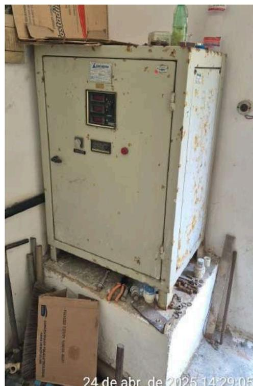
**Foto 104** - ETE Palmácia: casa do gerador sem gerador, com acúmulo de material como depósito.
