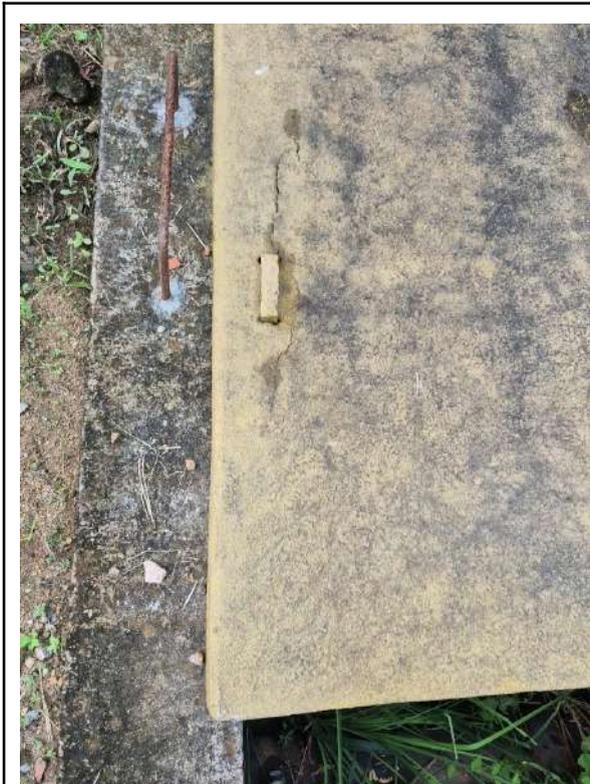
**Foto 27** - ETA Germinal: tampa com rachaduras e acúmulo de vegetação.
