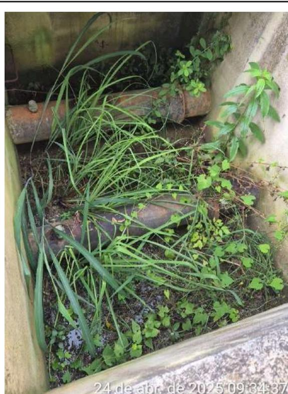
**Foto 28** - ETA Germinal: tampa com rachaduras e acúmulo de vegetação.
