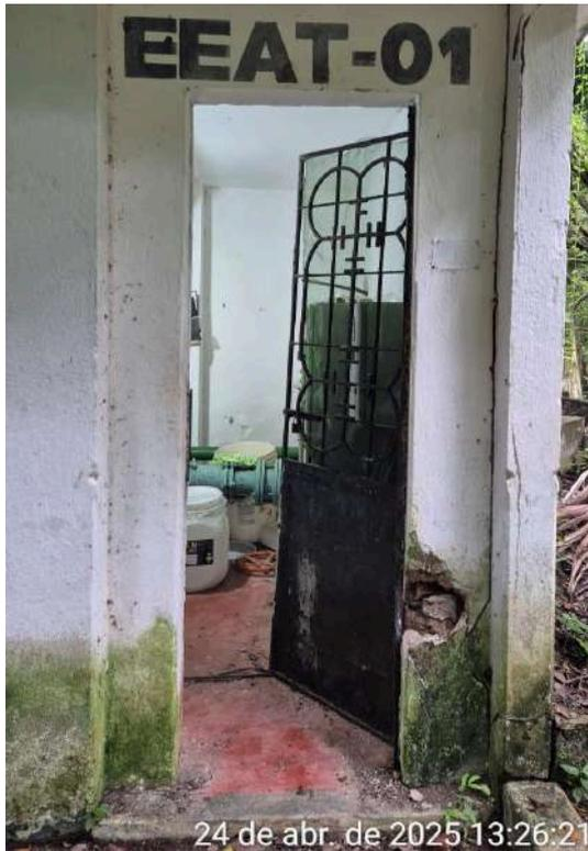
**Foto 55** - RAP-01: porta com dobradiça com tijolos expostos; lodo nas paredes.
