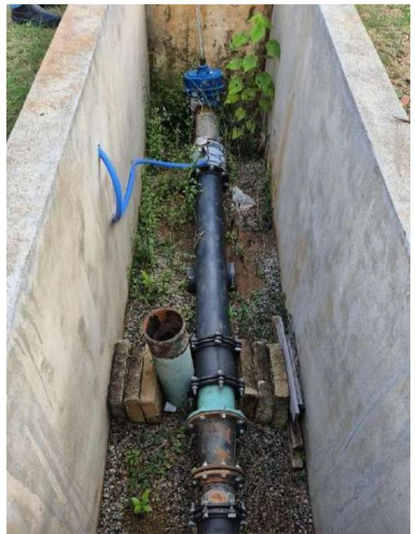
**Foto 18** - ETA Germinal: Tubulação antiga sem conexão; acúmulo de vegetação e de tijolos em local inadequado.
