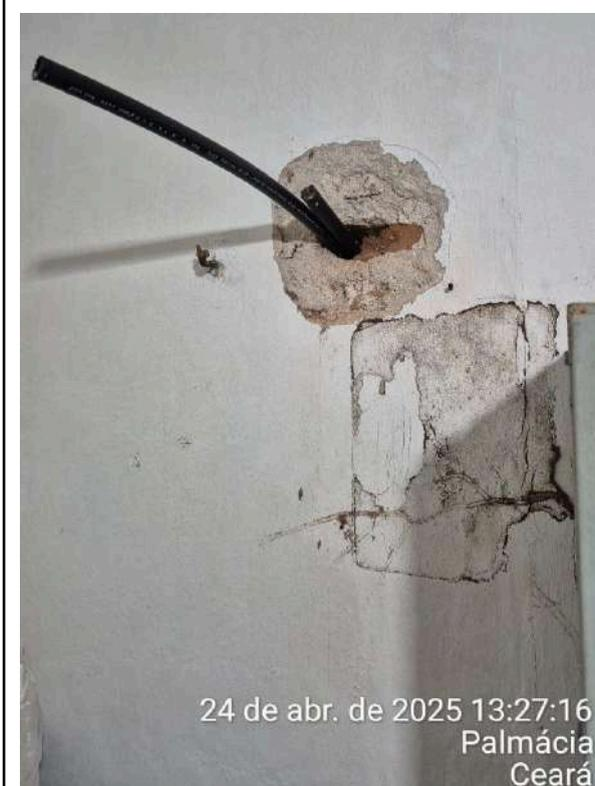
**Foto 5** - RAP-01: parede com fiação exposta inadequada, com parte da parede danificada.
