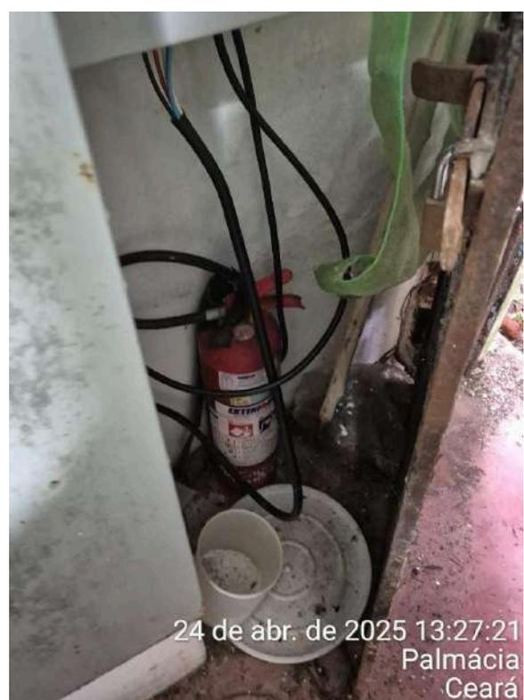
**Foto 6** - RAP-01: extintor em local inadequado com fiação por cima.
