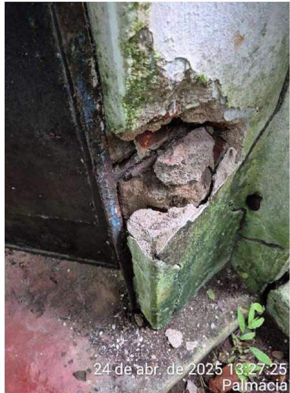
**Foto 56** - RAP-01: porta com dobradiça com tijolos expostos; lodo nas paredes.
