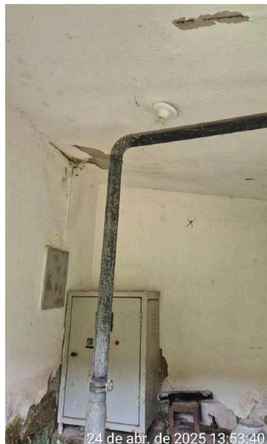
Foto 10 - EEE-04: armadura exposta no teto.
