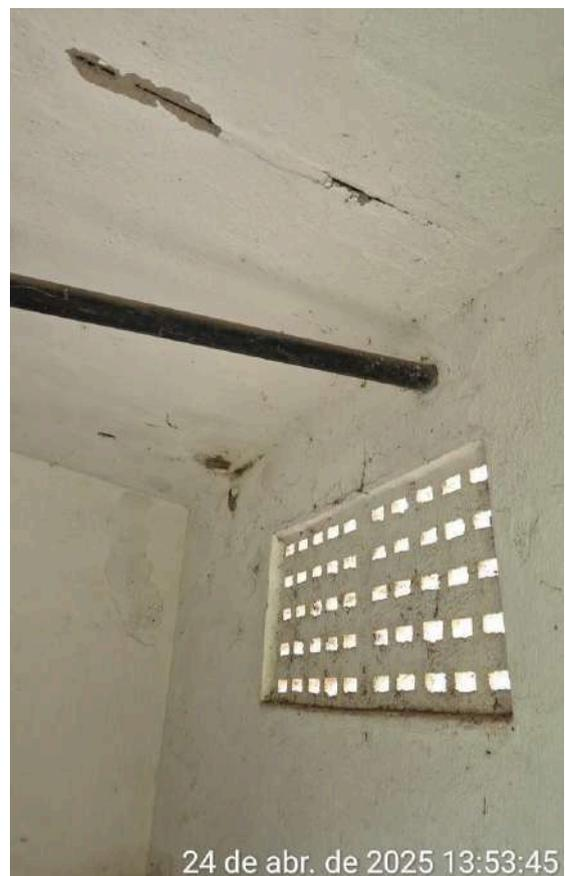
Foto 9 - EEE-04: armadura exposta no teto.
