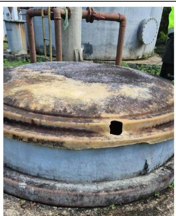
**Foto 94** - ETE Palmácia: calha de entrada enferrujada com tampa de proteção quebrada e suja.
