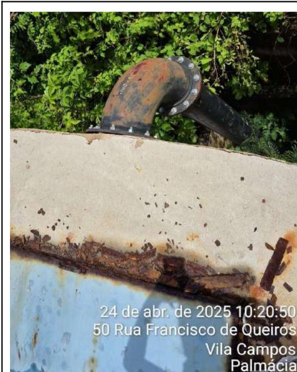
**Foto 75** - RAP-04: tampa e tubulação oxidada com risco de contaminação; acúmulo de água e lodo na superfície externa.
