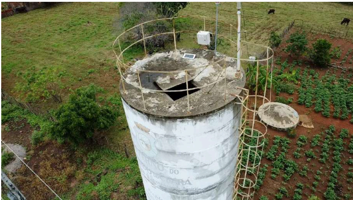
Foto 55 - REL-02: tampa da abertura de inspeção na laje superior aberta.
