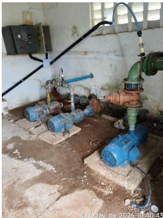
Foto 27 - RSE-01 / EERD-01 / EEAT-02: instalações implantadas através de cobogós.
