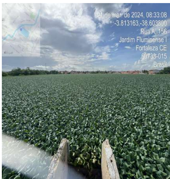
Foto 16 - ETE Conjunto Esperança: excesso de vegetação na lagoa.
