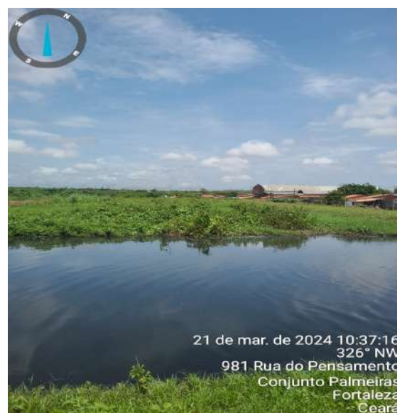
Foto 19 - ETE Conjunto Ceará: lagoa anaeróbia assoreada e com vegetação.
