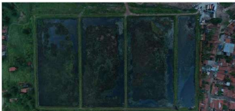
Figura 1: Vista aérea da ETE São Cristóvão.
