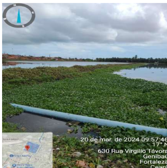
Foto 9 - ETE Conjunto Ceará: excesso de vegetação no interior das lagoas.
