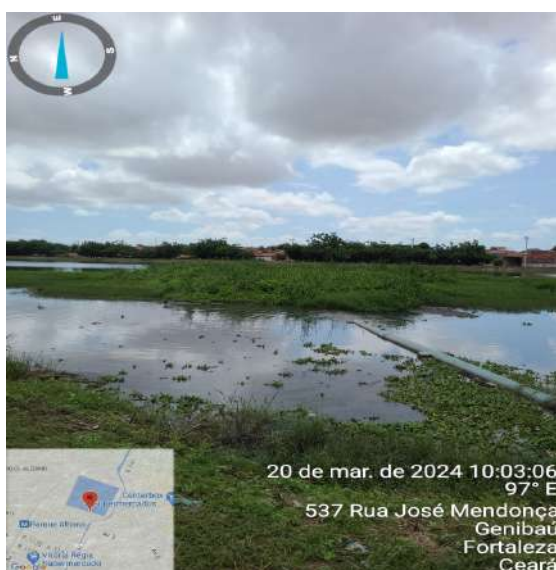
Foto 10 - ETE Conjunto Ceará: assoreamento e excesso de vegetação no interior das lagoas.
