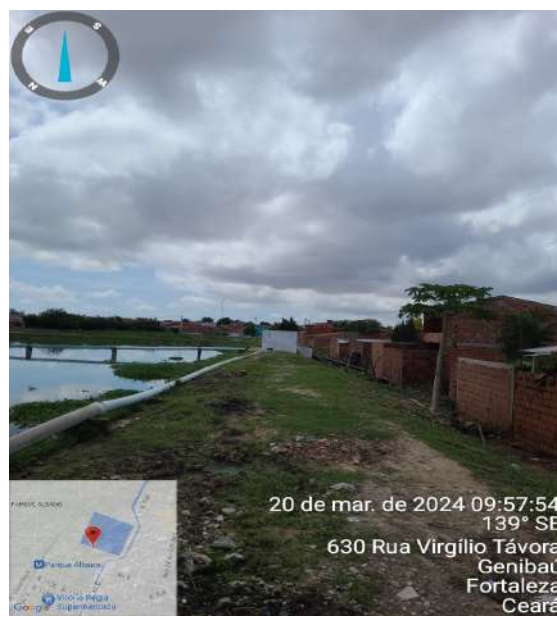
Foto 2 - ETE Conjunto Ceará: ausência de edificação de apoio.
