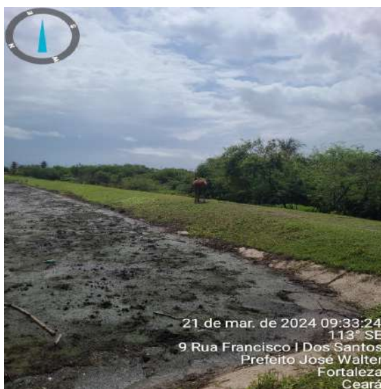
Foto 32 - ETE São Cristovão: presença de animais.
