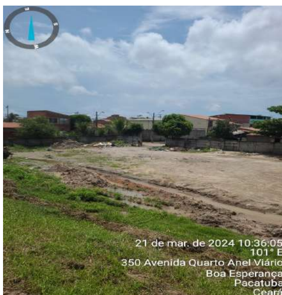
Foto 18 - ETE Conjunto Palmeiras: muro danificado.
