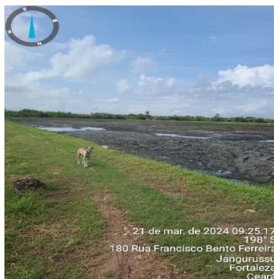
Foto 31 - ETE São Cristovão: presença de animais.
