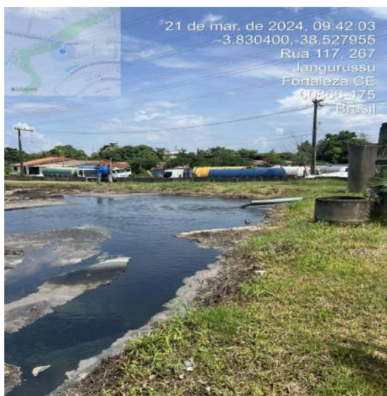
Foto 36 - ETE São Cristovão: lagoa assoreada.
