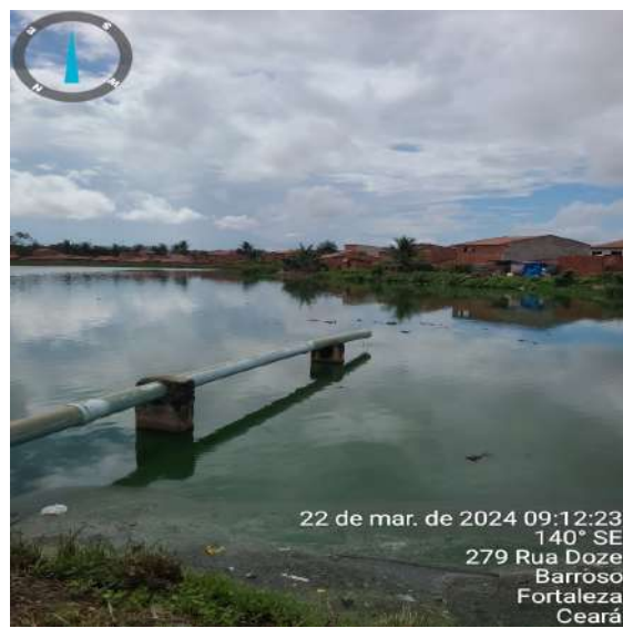
Foto 23 - Presença de vegetação nos taludes e no interior da lagoa.
