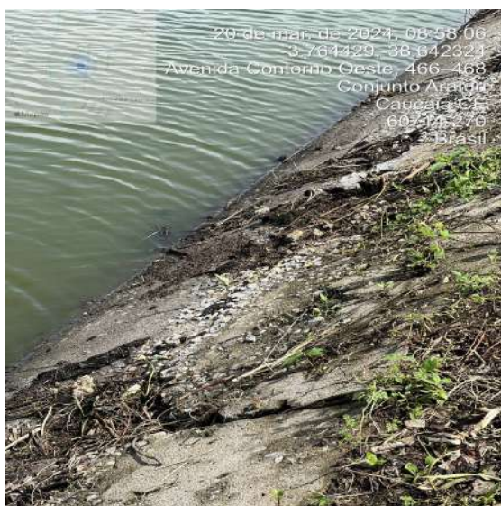
Foto 8 - ETE Araturi: placas deterioradas.
