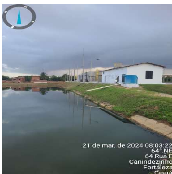
Foto 26 - ETE Parque Fluminense: local de entrada do efluente próximo à saída na lagoa facultativa.
