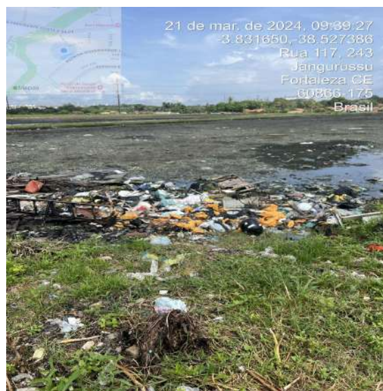
Foto 29 - ETE São Cristovão: acúmulo de resíduos.
