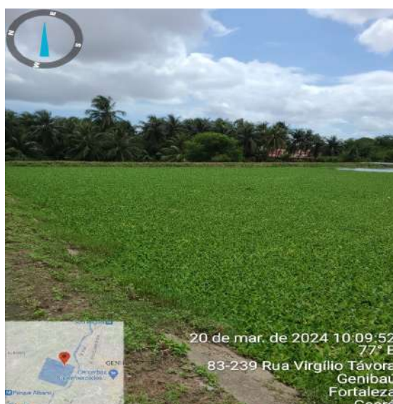
Foto 11 - ETE Conjunto Ceará: excesso de vegetação no interior das lagoas.
