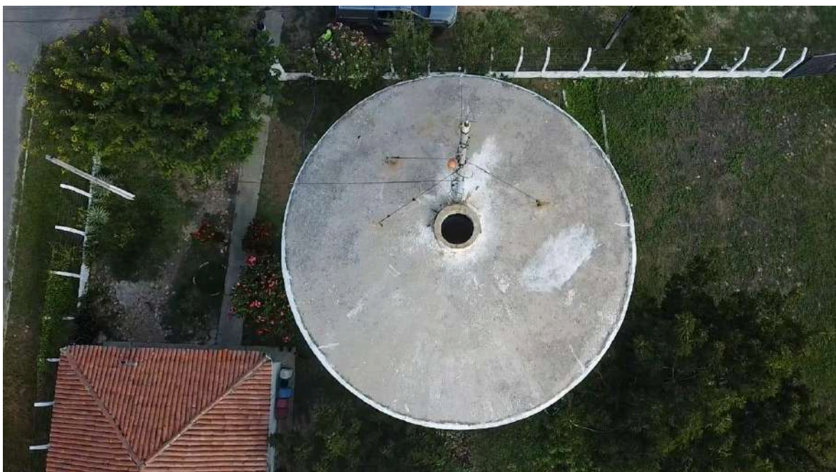
Foto 7 - REL-01 (Sucesso): sem tampa.
