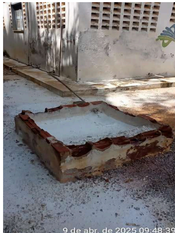
Foto 24 - ETA: o tanque de rejeitos do tratamento está deteriorado.
