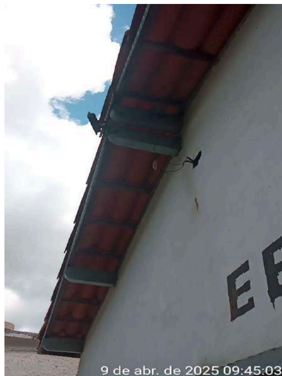
Foto 18 - ETA: a lâmpada da entrada da casa de bombas (EELF-01) está queimada.
