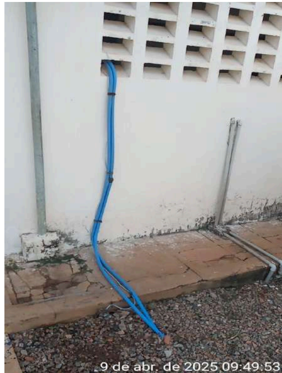
Foto 8 - ETA: instalações elétricas do laboratório estão inadequadas, com fiação instalada sem eletrodutos de isolamento e proteção e/ou através de cobogós.
