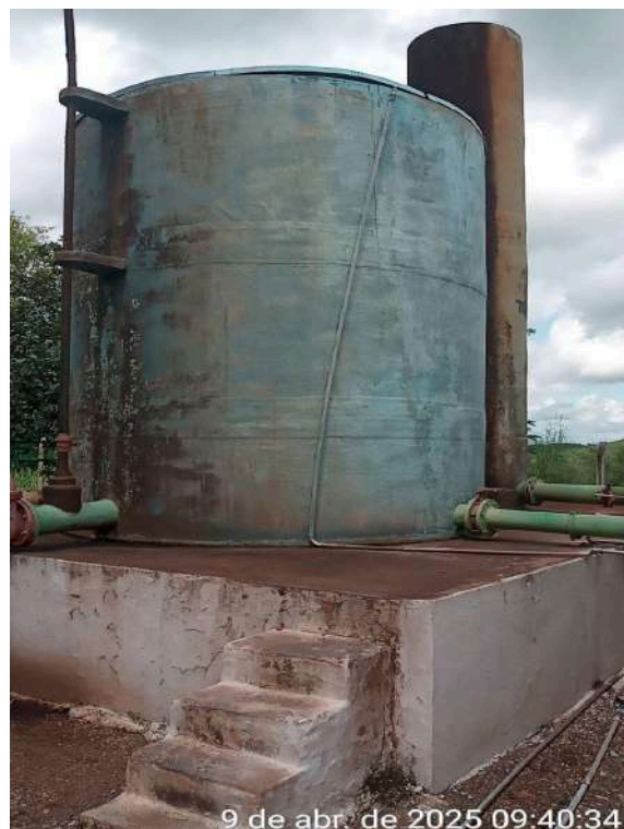
Foto 4 - ETA: filtro não possui escada de acesso tipo marinheiro.
