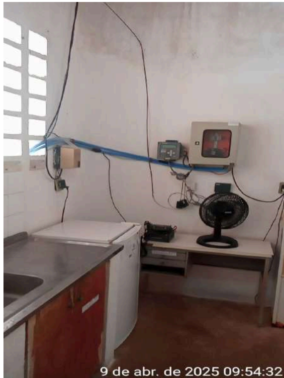
Foto 7 - ETA: instalações elétricas do laboratório estão inadequadas, com fiação instalada sem eletrodutos de isolamento e proteção e/ou através de cobogós.
