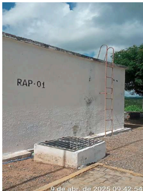
Foto 6 - ETA: a escada de acesso tipo marinheiro do RAP-01 não possui gaiola de proteção.
