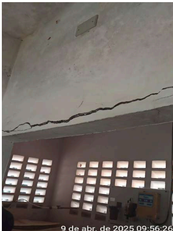
Foto 23 - ETA: laboratório com rachaduras na parede.
