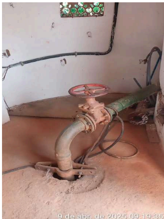
Foto 3 - Captação: instalações elétricas inadequadas com cabos/fios sem eletrodutos de isolamento e proteção, e instalados sobre o piso da área de circulação, bem como não tem iluminação.
