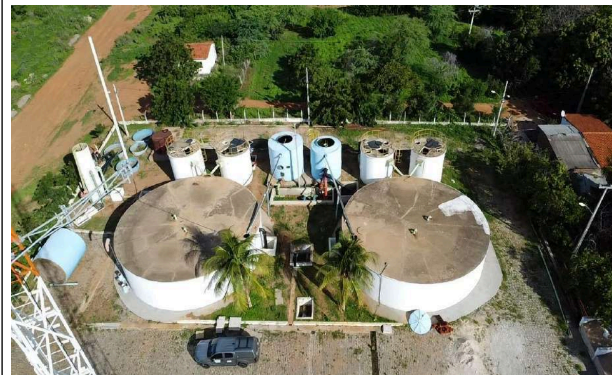
Foto 14 - F-01 / F-02 / F-03 / F-04 / F-05 / F-06: ausência de identificação.
