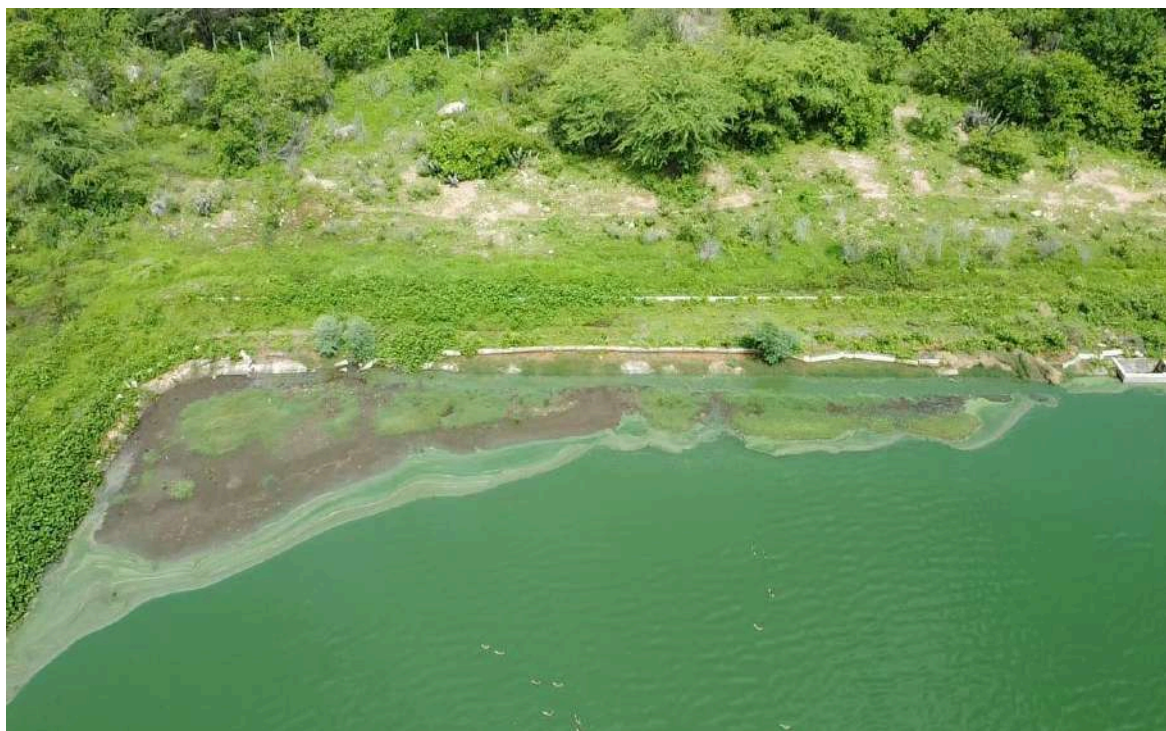
Foto 38 - Lagoa facultativa: presença de zona morta; caixa de passagem danificada; placas de isolamento danificadas.
