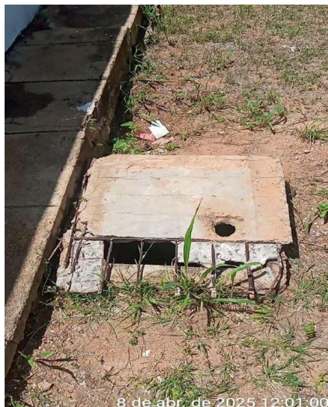
Foto 31 - RAP-03 / REL-02 / EEAT-02: Caixa com tampa danificada.
