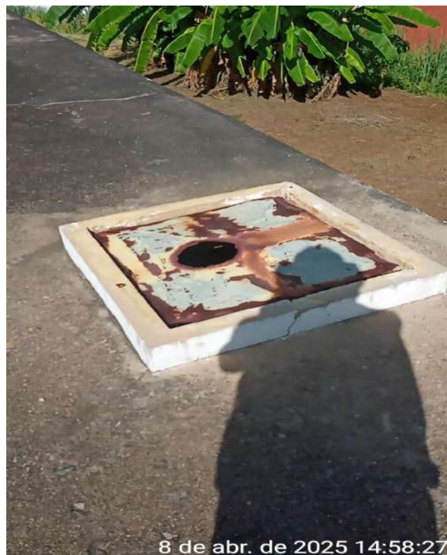
Foto 18 - RAP-02: Tampas de inspeção sem fecho hermético e em processo de corrosão avançado.
