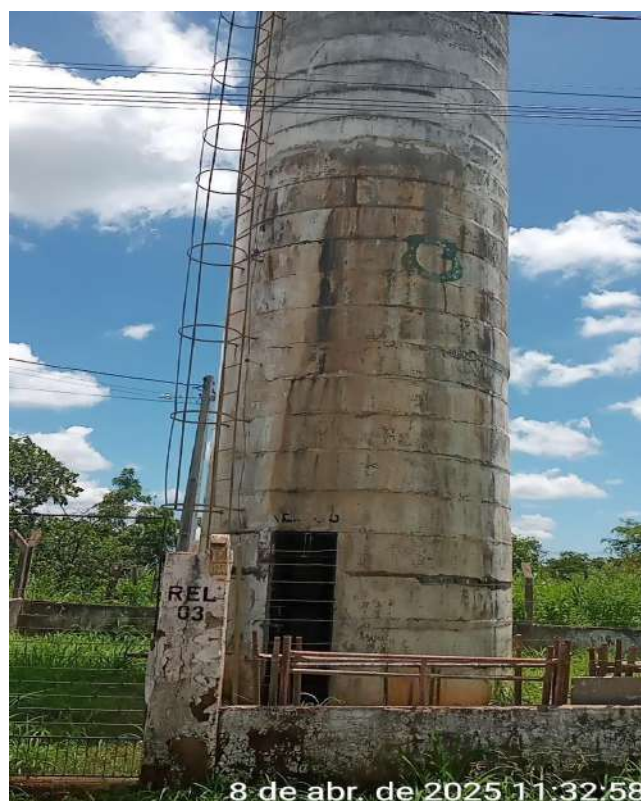
Foto 27 - REL-03: Pintura do muro e do reservatório desgastadas.
