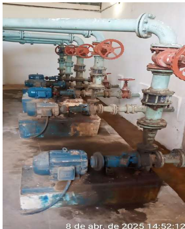
Foto 14 - EEAT-01: Equipamentos (bombas) sujos de óleo/graxa.
