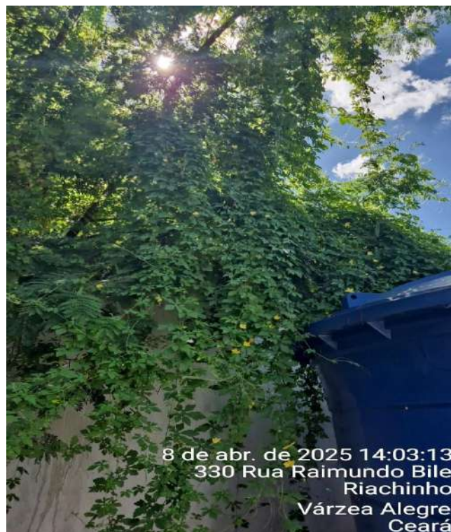
Foto 47 - EERD-01: Vegetação sobre a tampa do reservatório.
