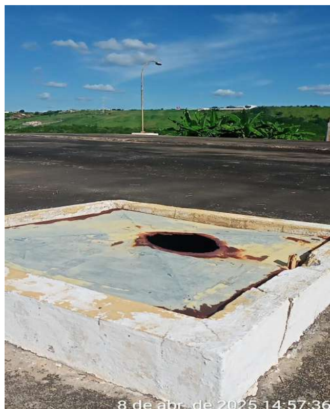
Foto 16 - RAP-02: Tampas de inspeção sem fecho hermético e em processo de corrosão avançado.
