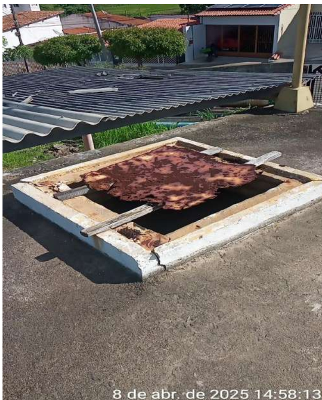
Foto 17 - RAP-02: Tampas de inspeção sem fecho hermético e em processo de corrosão avançado.
