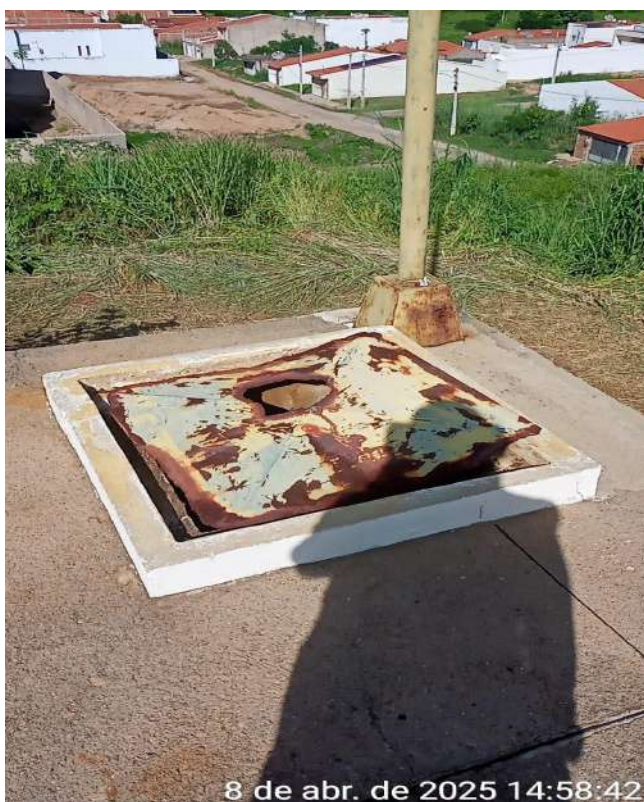
Foto 19 - RAP-02: Tampas de inspeção sem fecho hermético e em processo de corrosão avançado.
