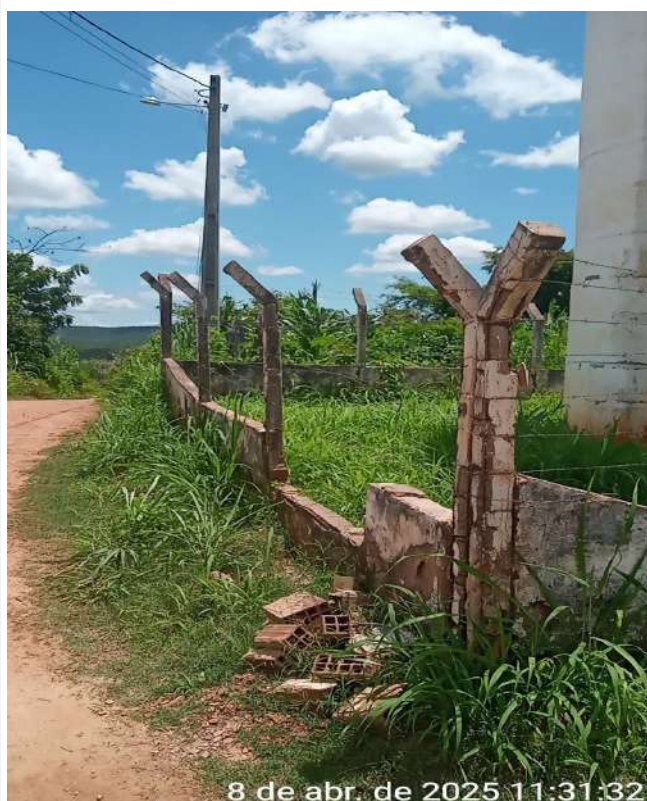
Foto 26 - REL-03: Muro e cerca de isolamento danificados.
