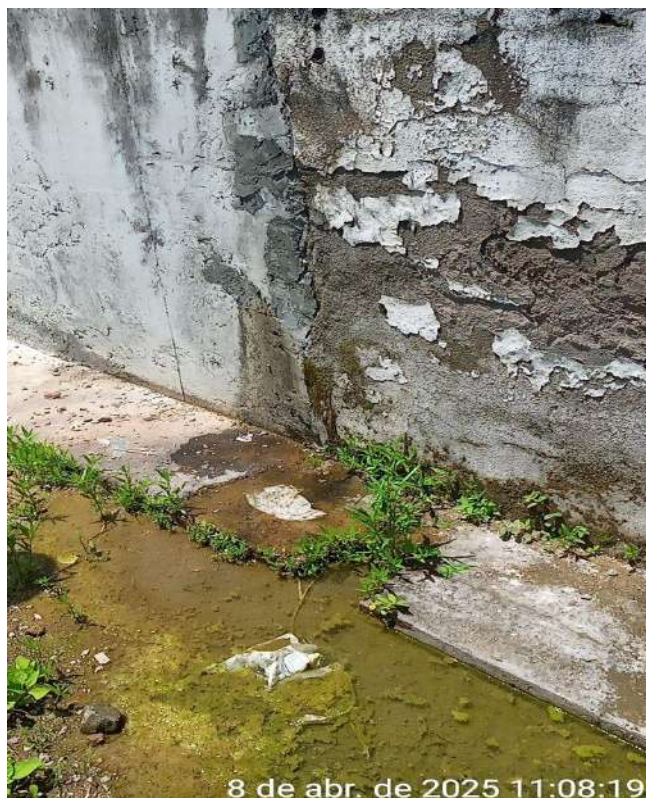
Foto 13 - ETRG: Presença de vazamento e rachaduras no tanque.
