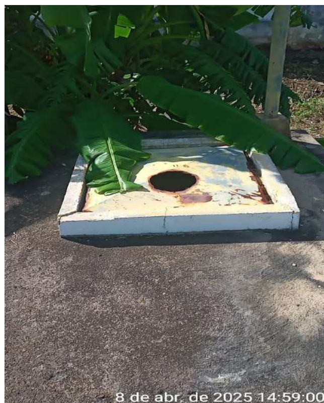
Foto 20 - RAP-02: Tampas de inspeção sem fecho hermético e em processo de corrosão avançado.
