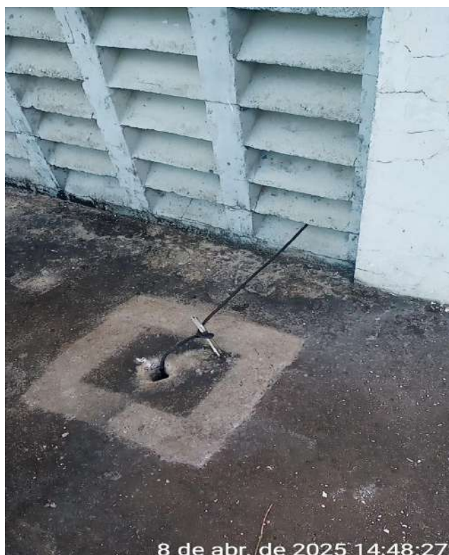
Foto 15 - RAP-02: Fiação elétrica inadequada sobre a laje e sem eletroduto de proteção e isolamento.
