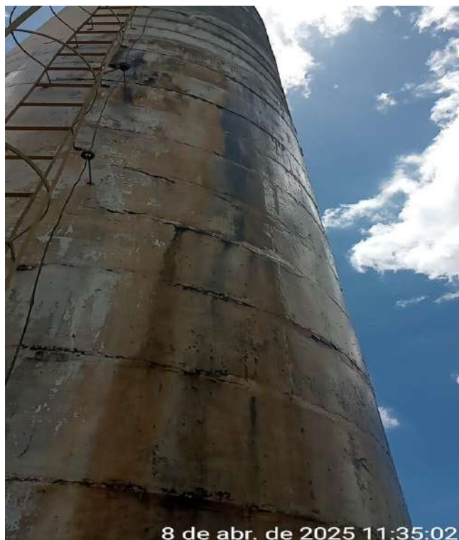
Foto 28 - REL-03: Vazamento na estrutura.
