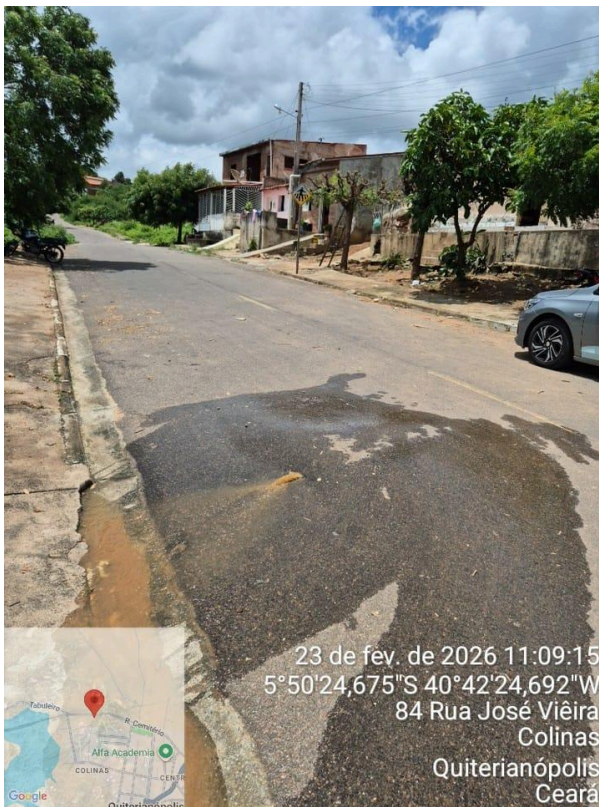
Foto 24 - Descarga (Setores 1 e 2): saída da tubulação de descarga coberta pelo pavimento.
