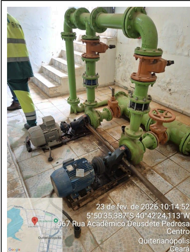
Foto 19 - ETA (EEAT-01): equipamentos sem conservação adequada.
