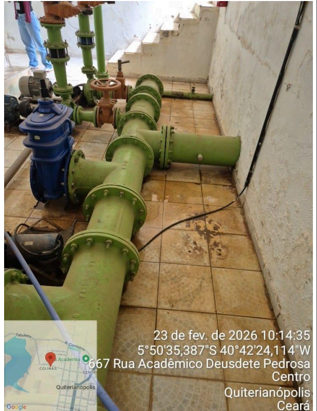
Foto 20 - ETA (EEAT-01): presença de vazamento.
