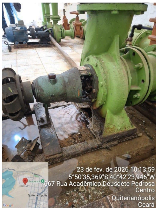
Foto 22 - ETA (EELF-01): presença de vazamento na bomba.
