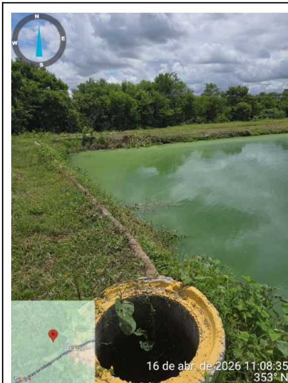
Foto 45 - ETE Pacatuba: lagoa de maturação com cor e turbidez elevadas.
