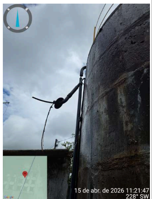
Foto 24 - RAP-01 (Sede): vazamento extremo na superfície do RAP, com transbordo e fiação com água passando.
