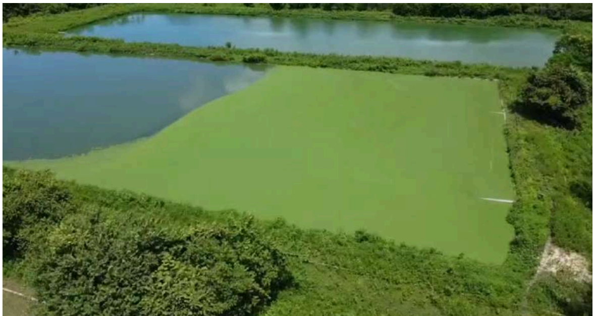
Foto 44 - ETE Pacatuba: lagoa de maturação com cor e turbidez elevadas.
