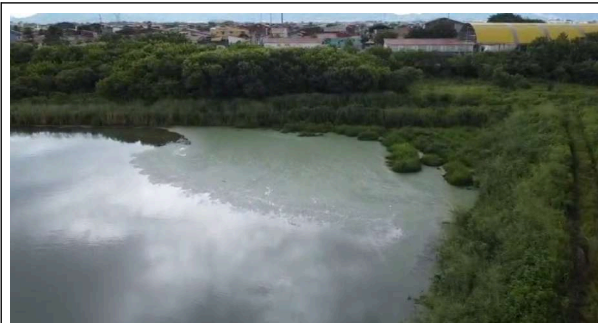
Foto 74 - ETE Mãe Rainha ( Jereissati ): presença de matéria orgânica na lagoa facultativa.
