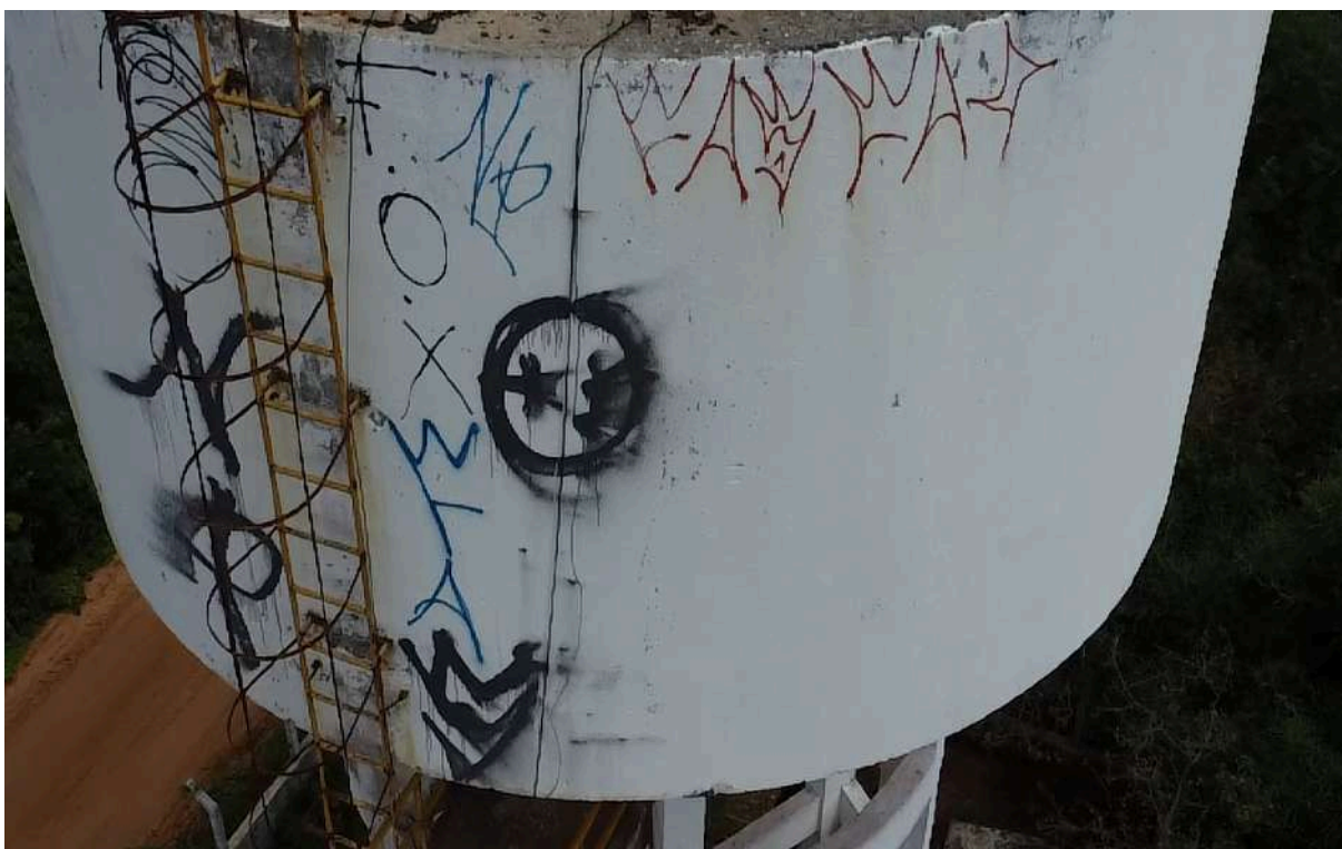
Foto 8 - REL-01: cabo de descida do para-raios instalado sem isolamento total da infraestrutura.
