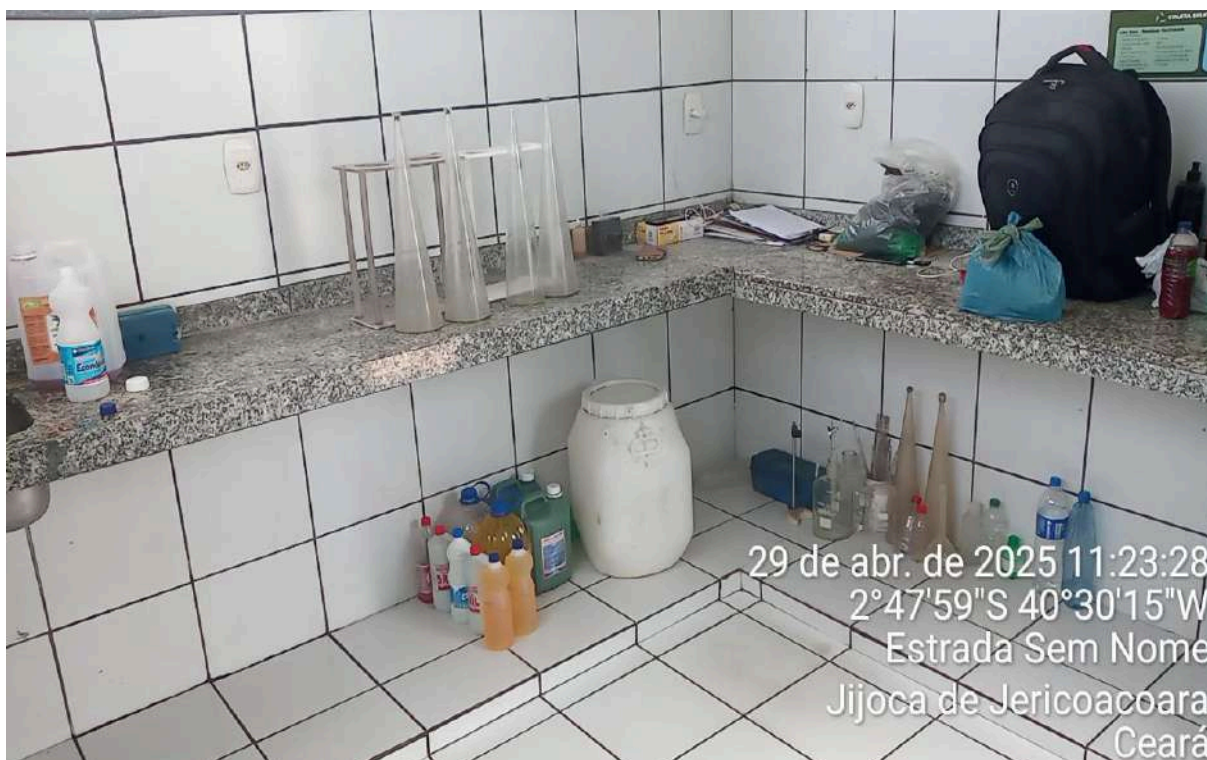
Foto 68 - Laboratório: instalações precárias sem armários para armazenagem e guarda de materiais e produtos.
