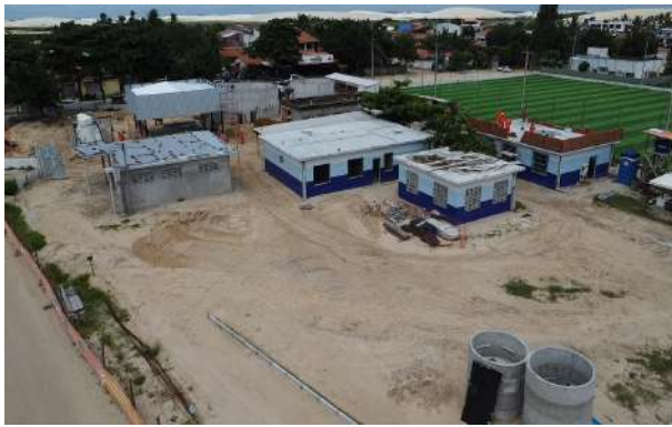
Foto 1 - Imagem aérea das obras de construção da ETA nova.
