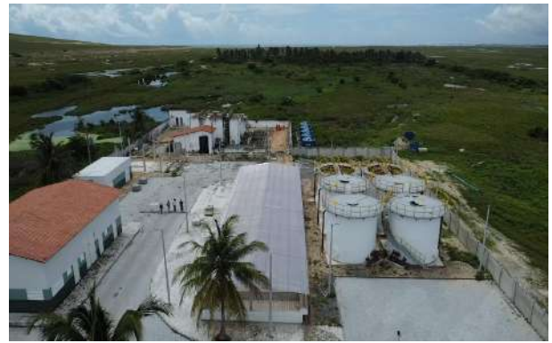
Foto 2 - Imagem aérea das obras de melhorias da ETE antiga e construção da ETE nova .
