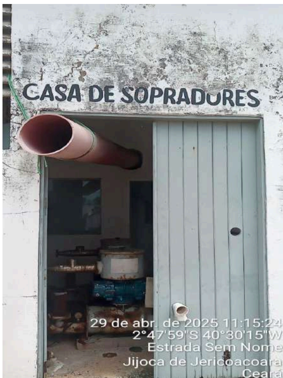
Foto 58 - Casa de sopradores: em manutenção.
