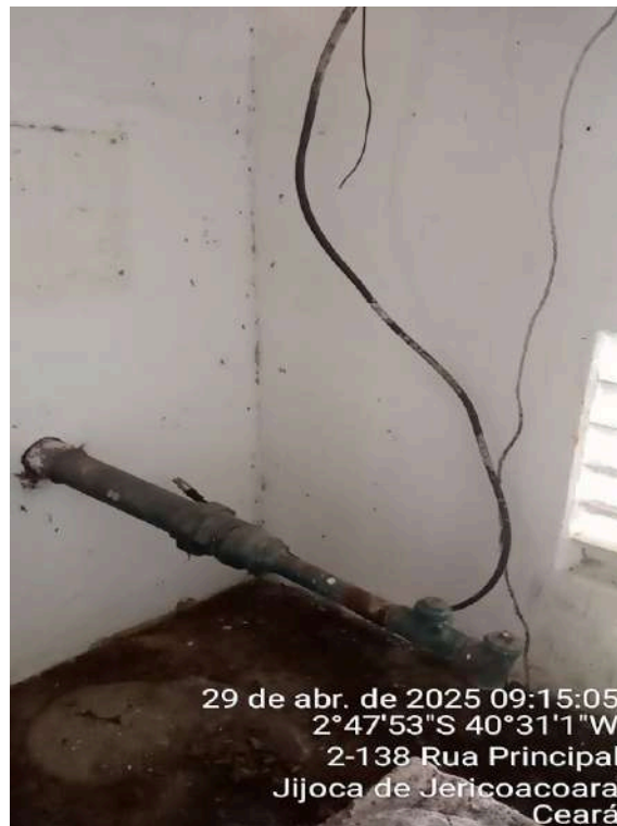
Foto 44 - PT-01: poço desativado.
