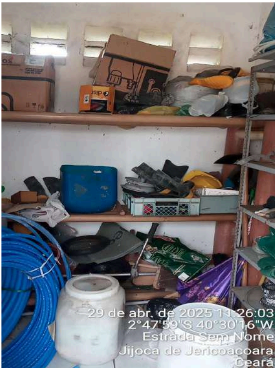
Foto 71 - Almoxarifado: armazenamento é feito sem organização e controle.
