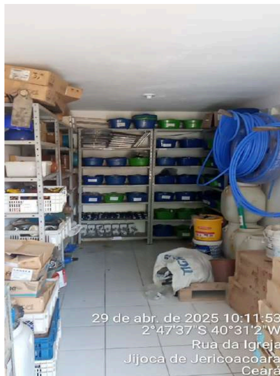
Foto 21 - Almojarifado: sem lâmpada.
