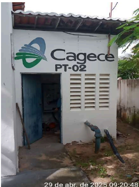
Foto 45 - PT-02: poço desativado.
