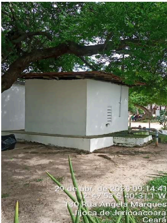
Foto 43 - PT-01: poço desativado.
