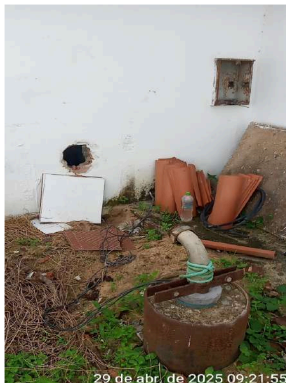
Foto 46 - PT-02: poço desativado.
