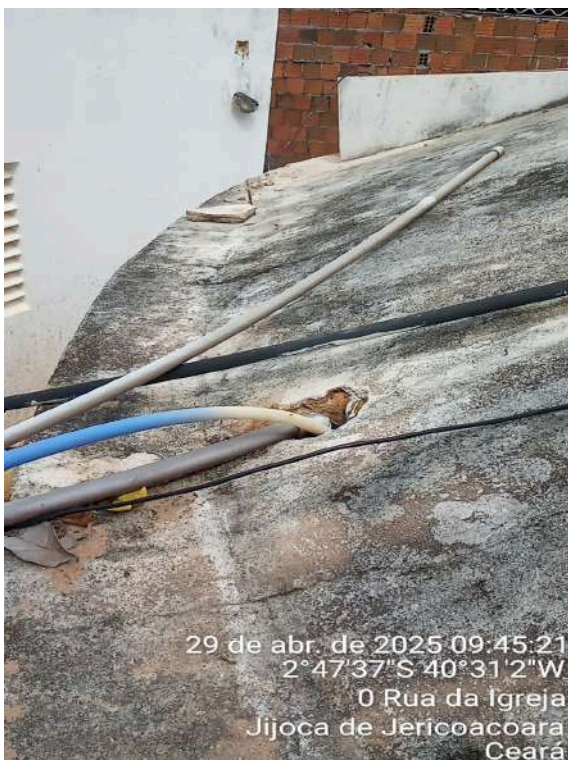
Foto 31 - RAP-01: furos de entrada de tubulação.
