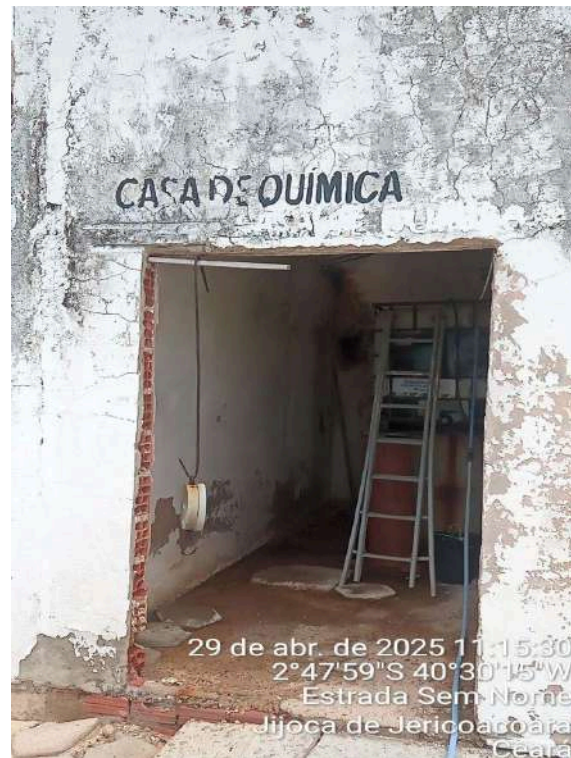
Foto 63 - Casa de Química: em manutenção.
