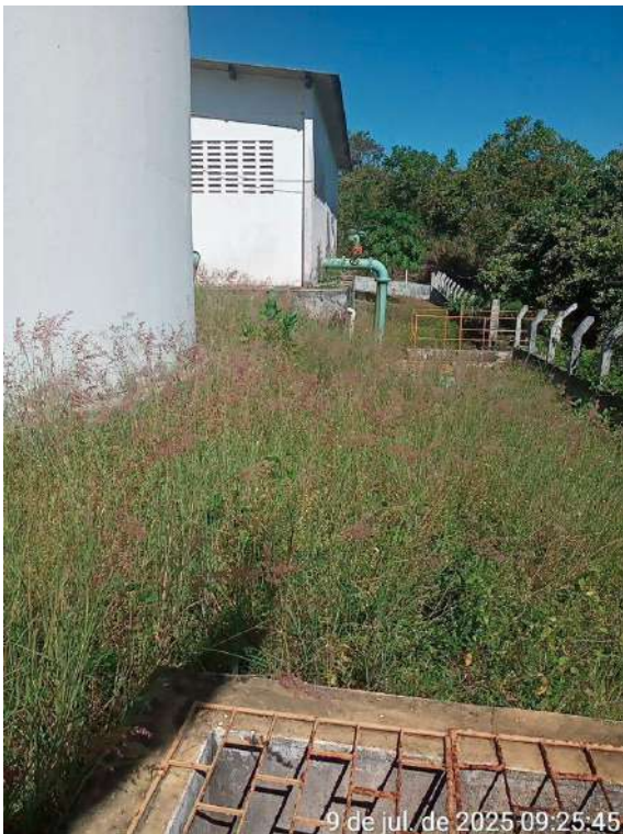
Foto 1 - ETA (Sede): a área do pátio está com a vegetação crescida.
