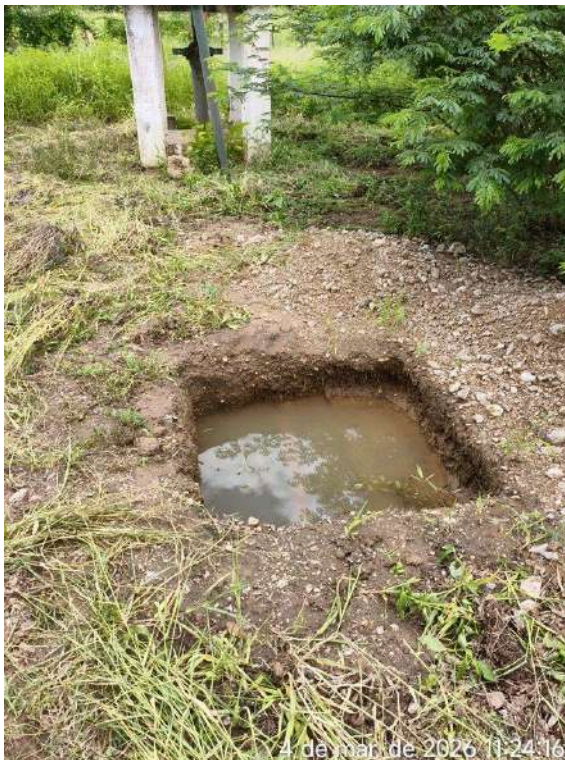
Foto 11 - Sede PT-04: caixa de proteção e inspeção inacabada.
