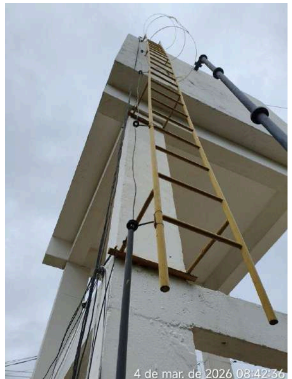
Foto 20 - lara REL-01: para-raios fixado na estrutura da escada
