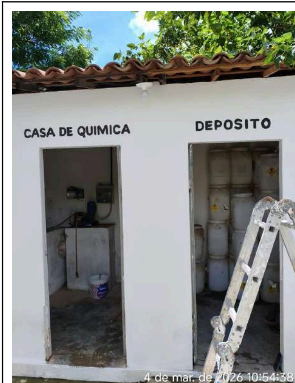
4 de mar. de 2026 10:54:38 Foto 62 - Sede Casa de Química: infraestrutura em obras de recuperação.
