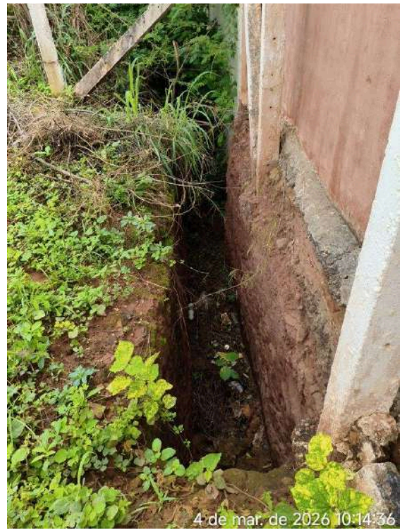
Foto 53 - Sede REL-01: vala escavada em aberto.
