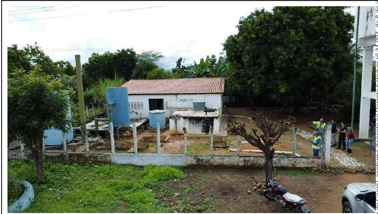
Foto 70 - Iara Geral: infraestrutura com pintura deteriorada.
