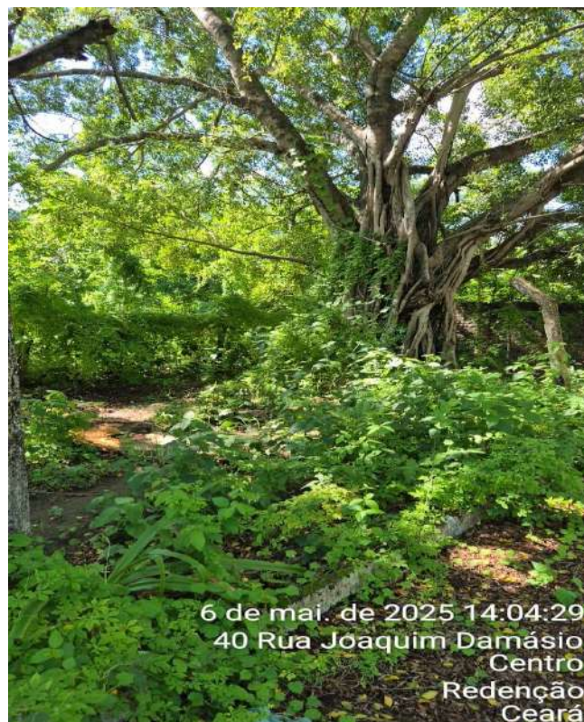
Foto 24 - EERD-02: cerca de proteção e isolamento danificada e vegetação no entorno.
