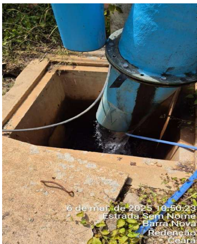
Foto 5 - Decantador: extravasamento.
