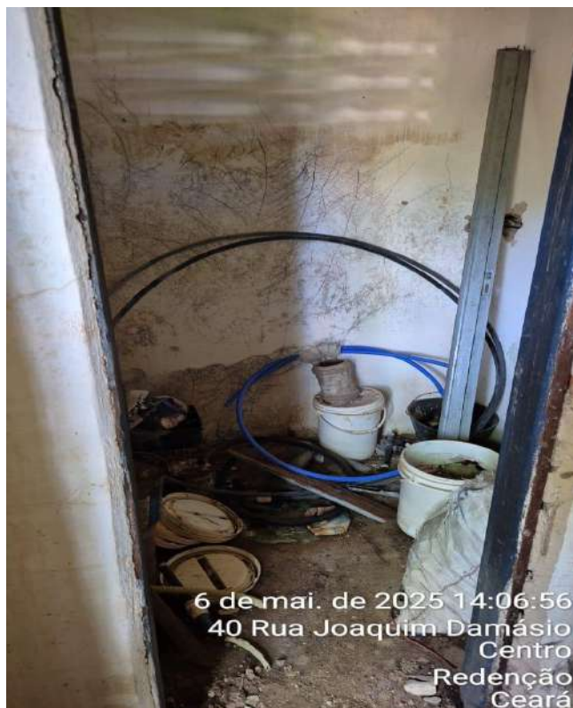
Foto 27 - EERD-02: acúmulo de material.
