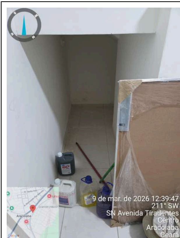
Foto 53 - Núcleo: material de limpeza sem local adequado para armazenamento.
