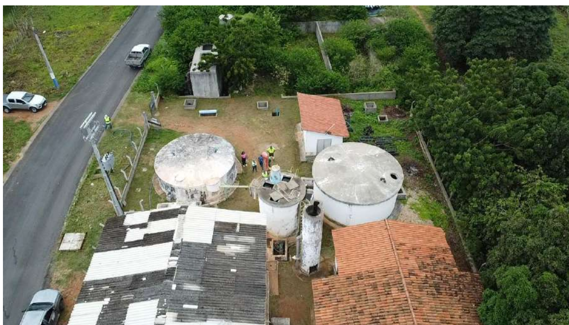
Foto 1 - Pátio (Caxitoré): existem diversas caixas de proteção sem tampas.
