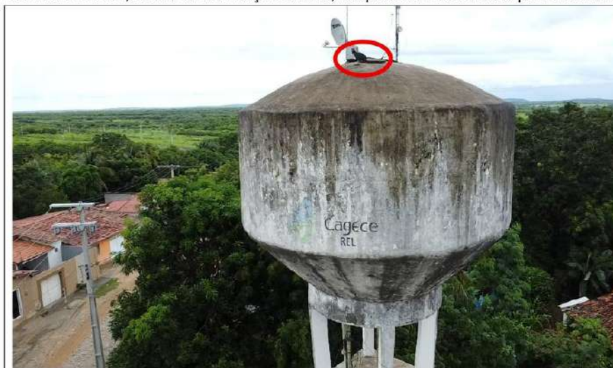
Foto 1 – Presença de urubus na cúpula do reservatório elevado de São Joaquim, distrito de Umirim.
