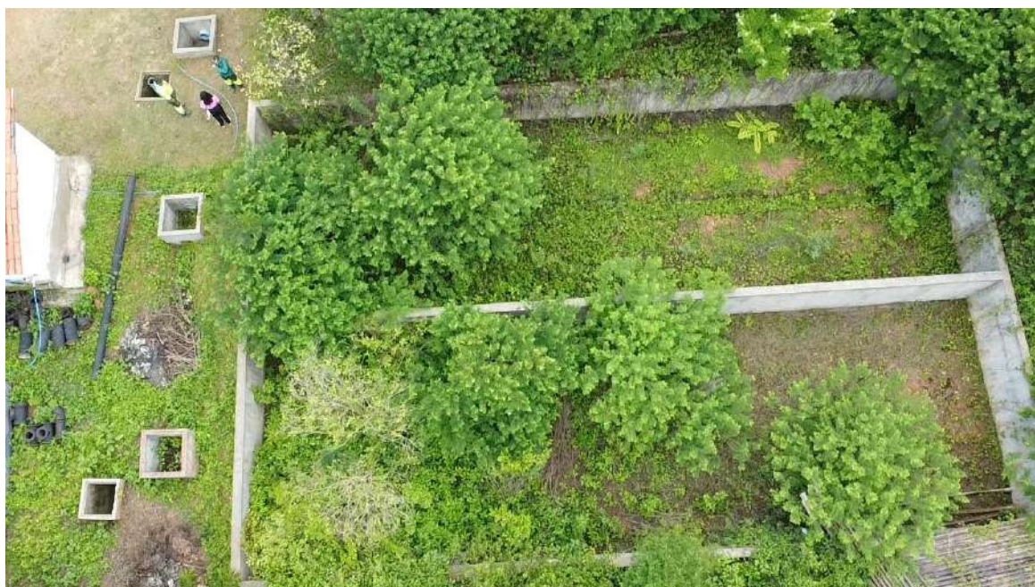
Foto 2 - Pátio (Caxitoré): existem diversas caixas de proteção sem tampas.
