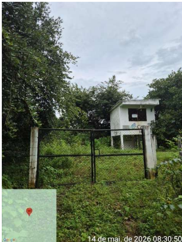
Foto 103 - EEAB-01 (Lisieux): vegetação alta.
