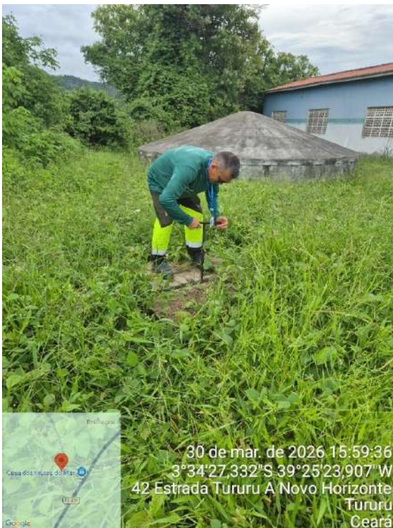
Foto 2 - Caixa de Descarga ( Sede ): presença de vegetação densa no entorno.
