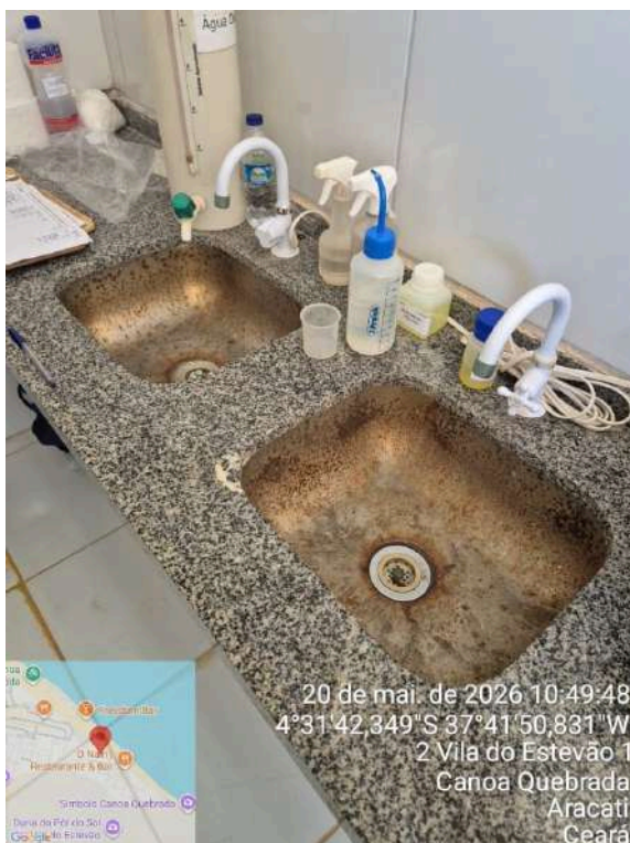
Foto 168 - EEAT-01 (Canoa): laboratório com piaas oxidadas.
