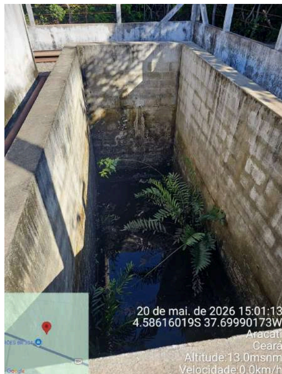
Foto 221 - EEAT-01 (Majorlândia): drenagem do RSE-01 com água acumulada.
