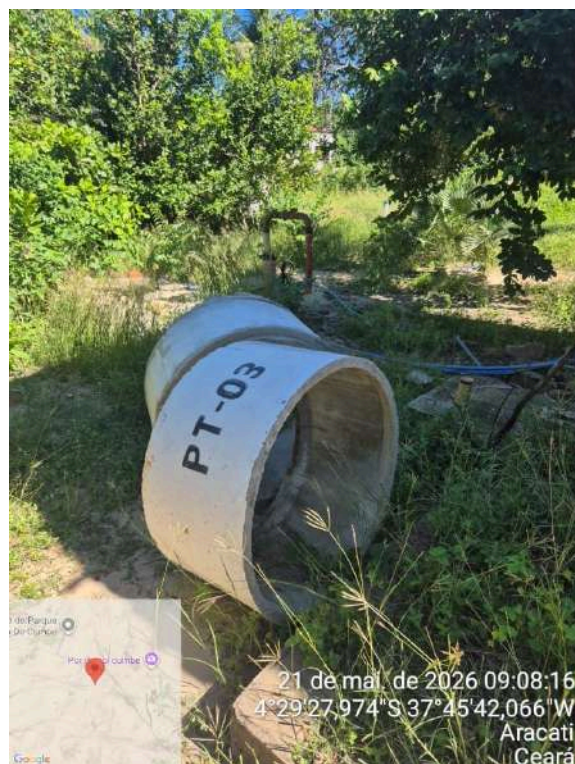
Foto 48 - PT-03 (sede): proteção caída.
