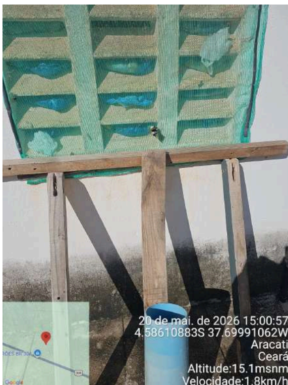
Foto 222 - EEAT-01 (Majorlândia): escada segurando a tela do cobogó.
