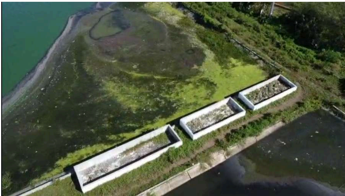
Foto 254 - ETE Aracati : lagoa facultativa com vegetação e sujeira, reduzindo a área útil de tratamento.
