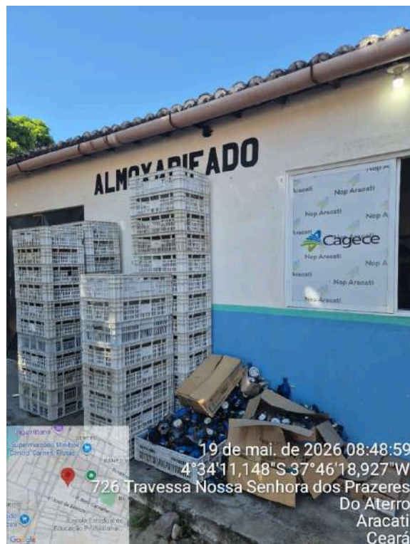
Foto 7 - Núcleo Aracati (sede): armazenamento inadequado dos hidrômetros, expostos a intempéries.
