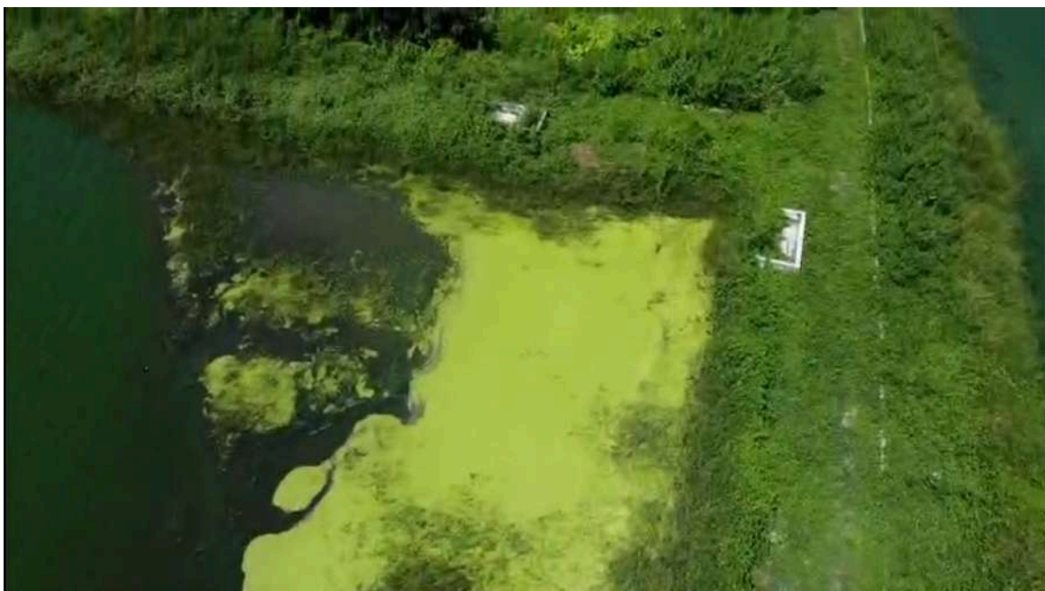
Foto 293 - ETE Canoa Quebrada : lagoa com vegetação e sujeira, reduzindo a área útil de tratamento.
