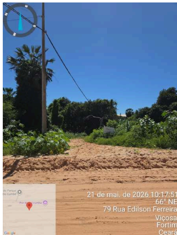
Foto 98 - Área externa (sede): terreno dos poços sem fechamento.
