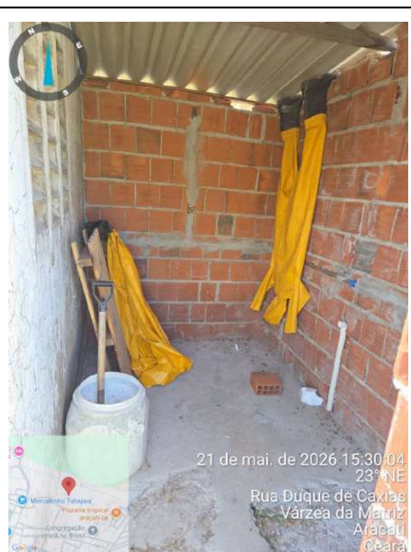
Foto 279 - EEE-G (sede): banheiro em construção, sem prazo de conclusão.
