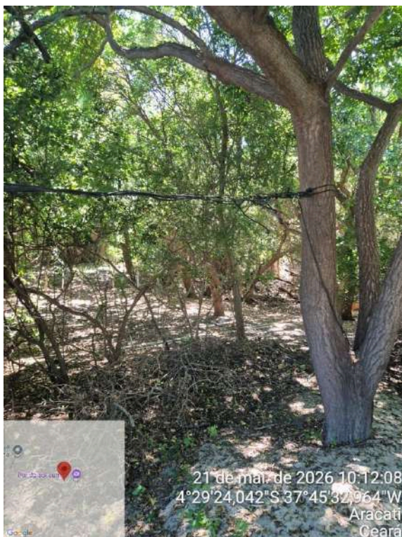
Foto 97 - Área externa (sede): fiação solta sem proteção, apresentando risco operacional.
