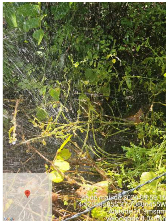
Foto 159 - PT-08 (Canoa): vazamento extremo na adutora próxima ao poço.
