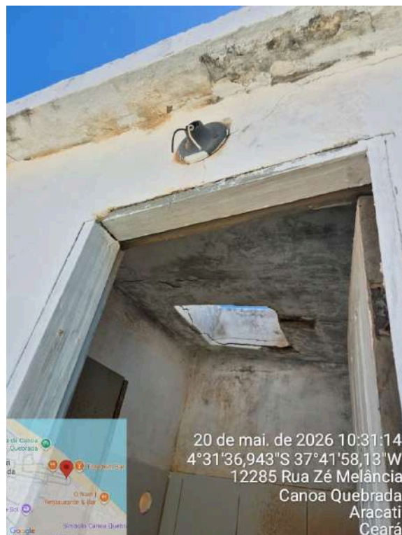
Foto 167 - PT-05 (Canoa): teto com abertura, sem iluminação.
