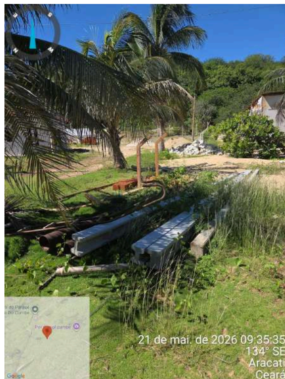
Foto 102 - ETA Cumbe (sede): equipamentos novos aguardando instalação com sinais de desgaste.
