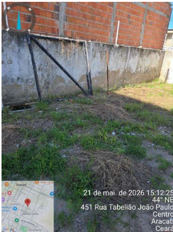
Foto 271 - EEE-D (sede): portão antigo disposto inadequadamente.
