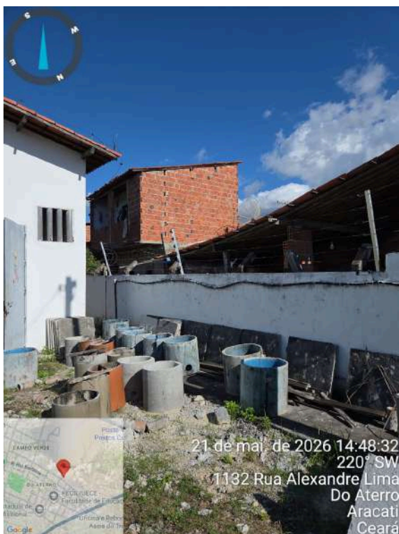
Foto 265 - EEE-A (sede): residências próximas a elevatória com forte odor.
