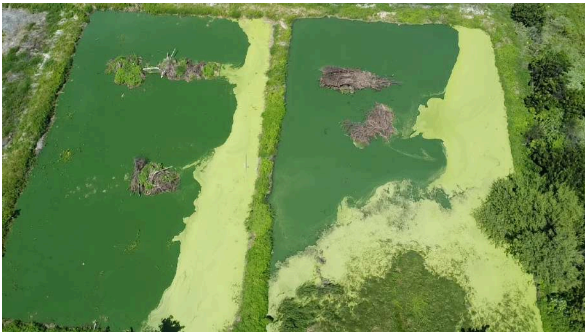
Foto 294 - ETE Canoa Quebrada: leito de secagem com vegetação acumulada.
