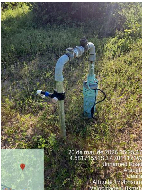
Foto 250 - PT-07 (Majorlândia): sem proteção e identificação.
