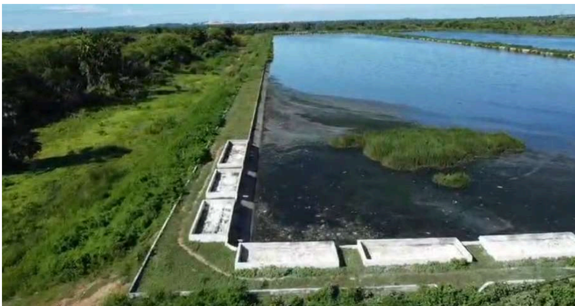
Foto 252 - ETE Aracati : lagoa facultativa com vegetação e sujeira, reduzindo a área útil de tratamento.
