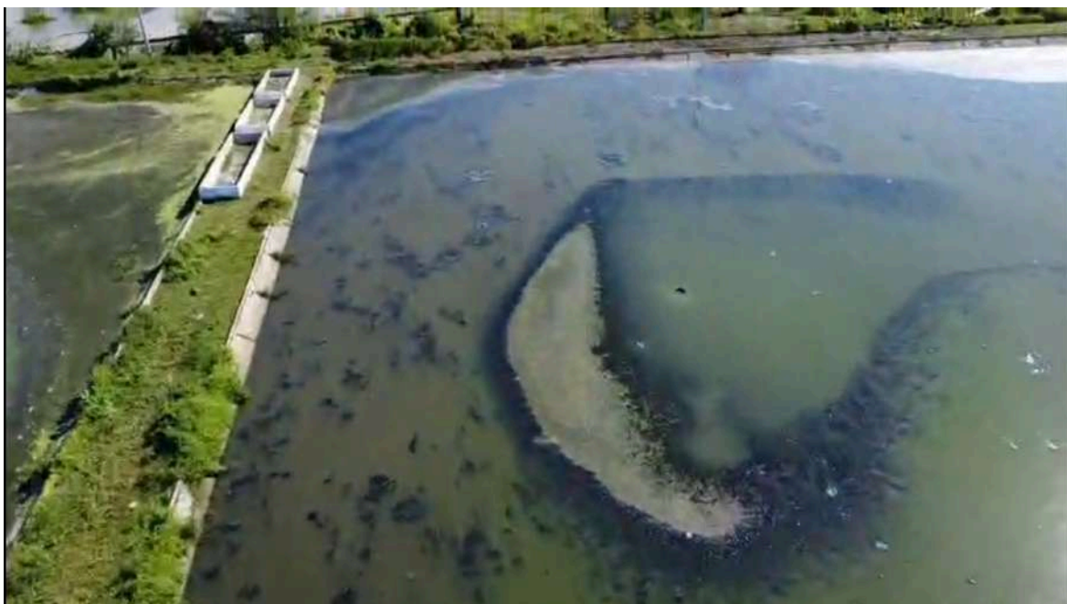
Foto 253 - ETE Aracati : lagoa facultativa com vegetação e sujeira, reduzindo a área útil de tratamento.
