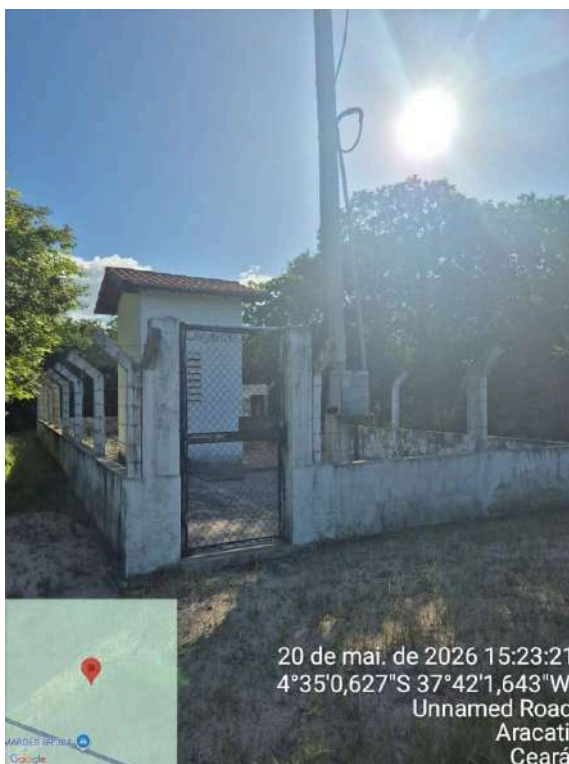
Foto 242 - PT-01 (Majorlândia): portão sem cadeado.
