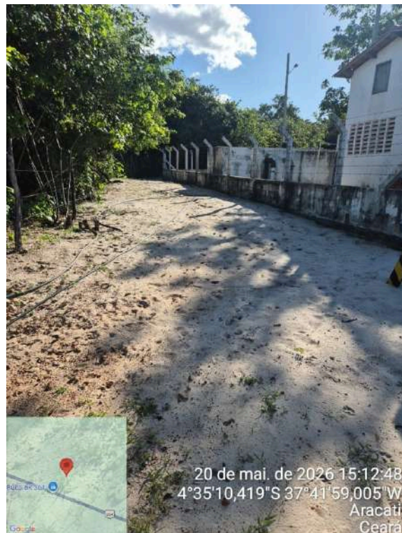
Foto 229 - EEAT-01 (Majorlândia): fiação na parte externa inadequada.
