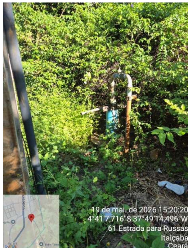
Foto 58 - PT-02 (sede): tubulação oxidada, poço sem proteção, coberto por vegetação.
