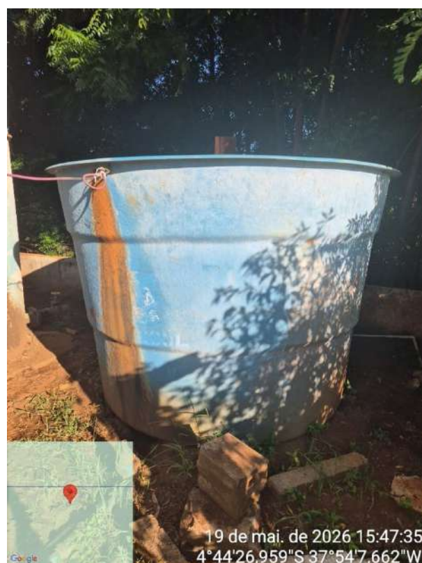
Foto 72 - ETA Tomé Afonso: RAP-01 com apoio improvisado e parede desgastada.
