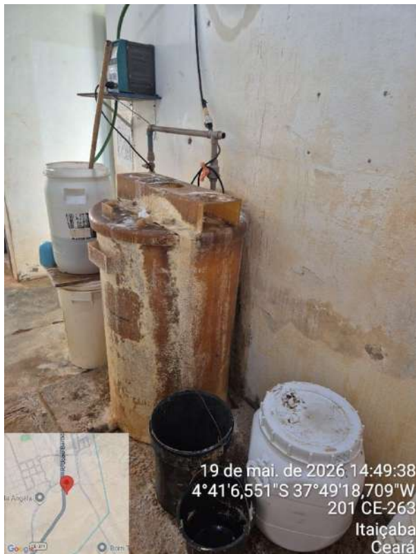
Foto 45 - ETA Itaíçaba: sistema de cloração desativado desgastado e com sujeira.
