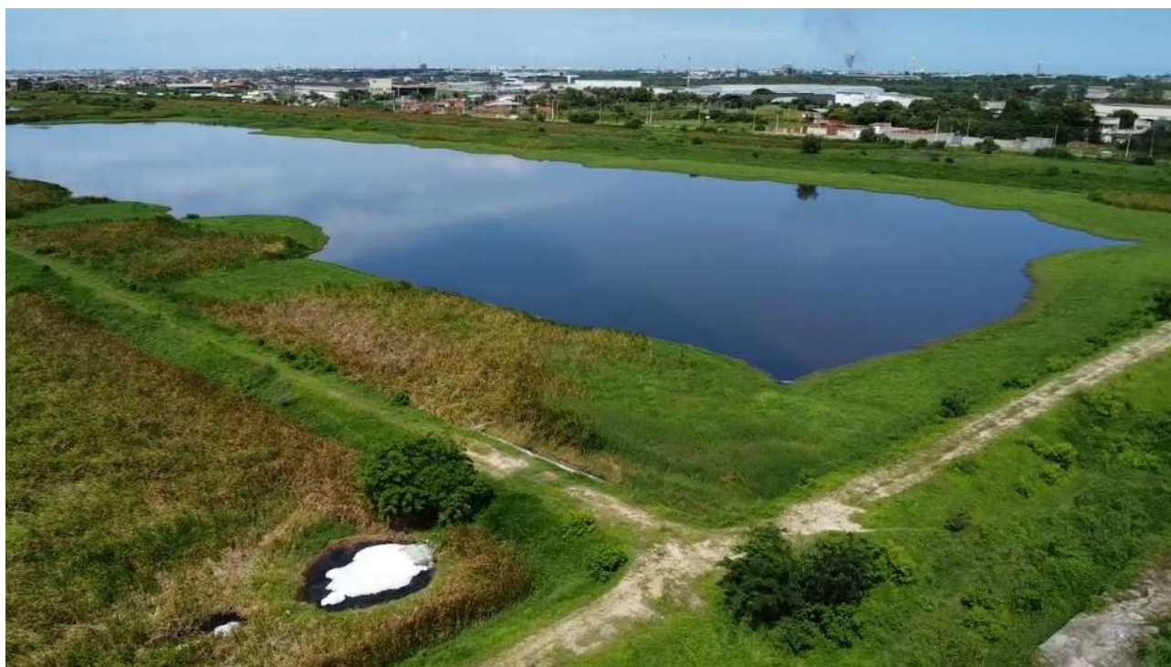
Foto 8 - ETE SIDI: Assoreamento completo, fluxos preferenciais, excesso de vegetação, acesso tomado pela vegetação, vegetação nas partes internas das lagoas e ausência de placas de proteção das lagoas de estabilização.
