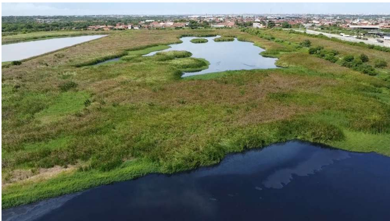
Foto 5 - ETE SIDI: Assoreamento completo, fluxos preferenciais, excesso de vegetação, acesso tomado pela vegetação, vegetação nas partes internas das lagoas e ausência de placas de proteção das lagoas de estabilização.
