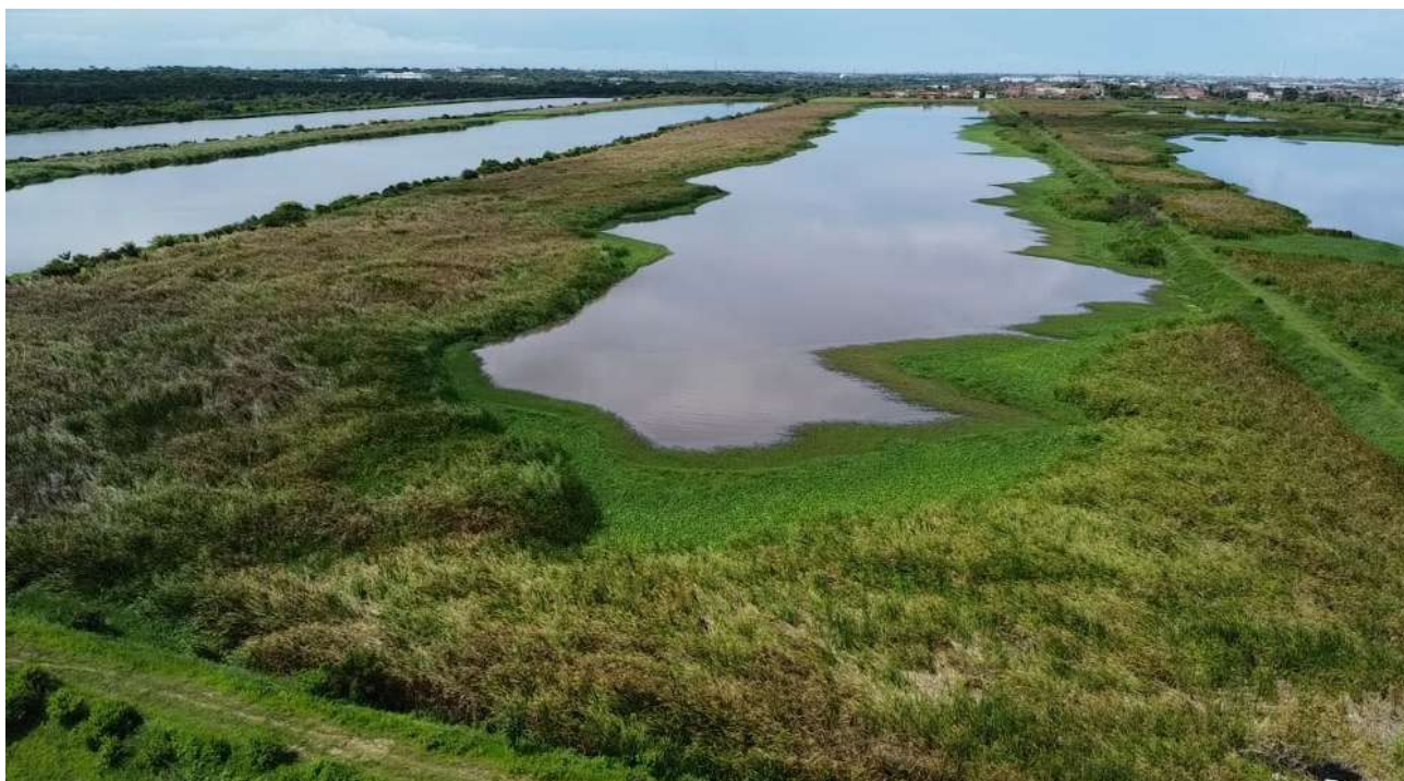
Foto 9 - ETE SIDI: Assoreamento completo, fluxos preferenciais, excesso de vegetação, acesso tomado pela vegetação, vegetação nas partes internas das lagoas e ausência de placas de proteção das lagoas de estabilização.
