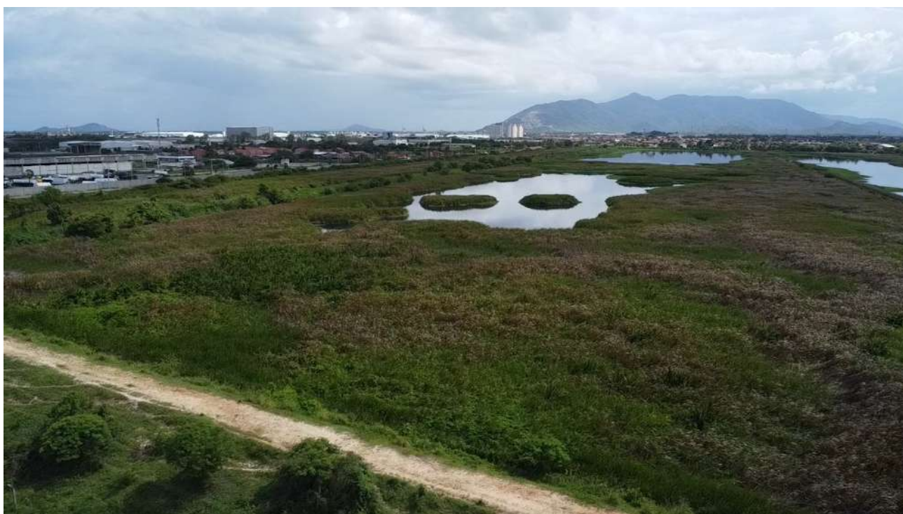
Foto 1 - ETE SIDI: Assoreamento completo, fluxos preferenciais, excesso de vegetação, acesso tomado pela vegetação, vegetação nas partes internas das lagoas e ausência de placas de proteção das lagoas de estabilização.
