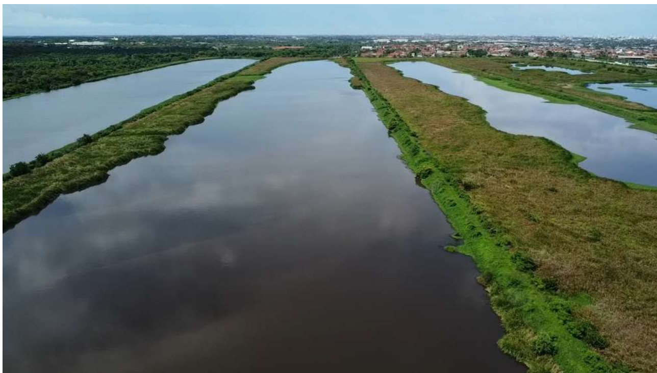
Foto 7 - ETE SIDI: Assoreamento completo, fluxos preferenciais, excesso de vegetação, acesso tomado pela vegetação, vegetação nas partes internas das lagoas e ausência de placas de proteção das lagoas de estabilização.
