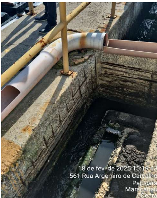
Foto 10 - ETE Pajuçara: corrosão nos acessos e armadura exposta em toda sua estrutura.
