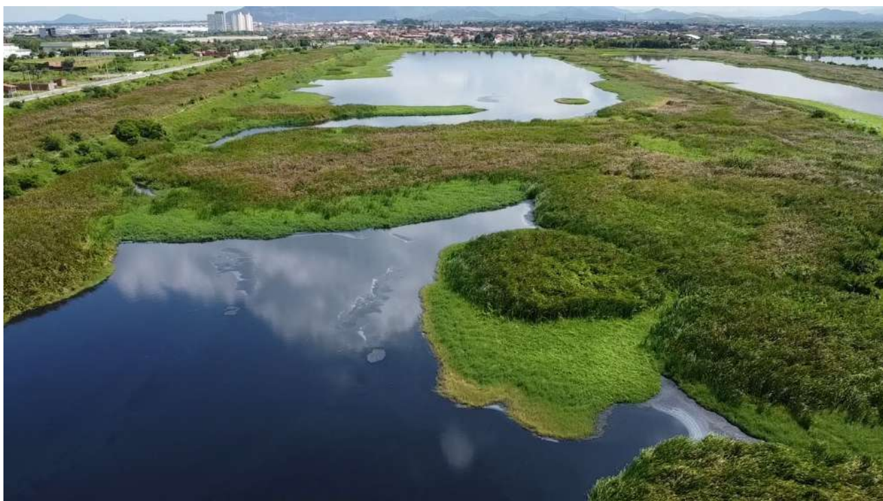
Foto 6 - ETE SIDI: Assoreamento completo, fluxos preferenciais, excesso de vegetação, acesso tomado pela vegetação, vegetação nas partes internas das lagoas e ausência de placas de proteção das lagoas de estabilização.
