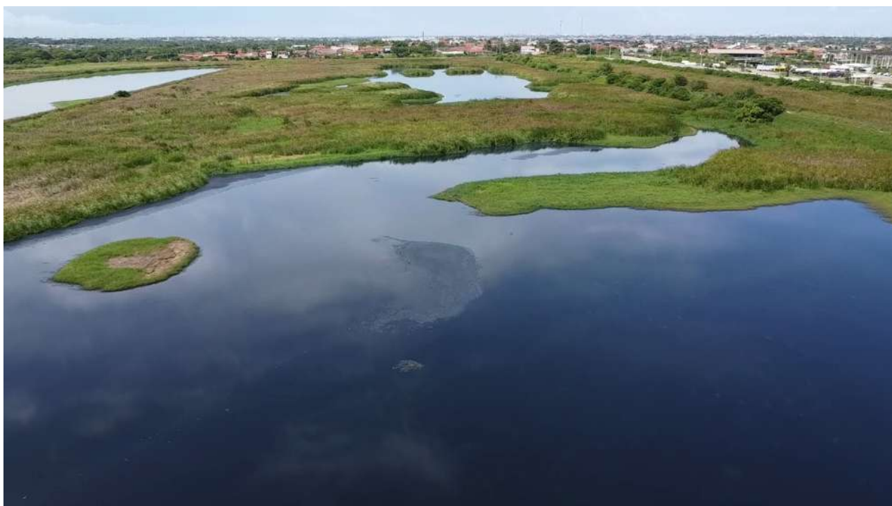
Foto 4 - ETE SIDI: Assoreamento completo, fluxos preferenciais, excesso de vegetação, acesso tomado pela vegetação, vegetação nas partes internas das lagoas e ausência de placas de proteção das lagoas de estabilização.
