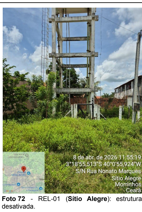
Foto 71 - REL-01 (Sítio Alegre): estrutura desativada.
