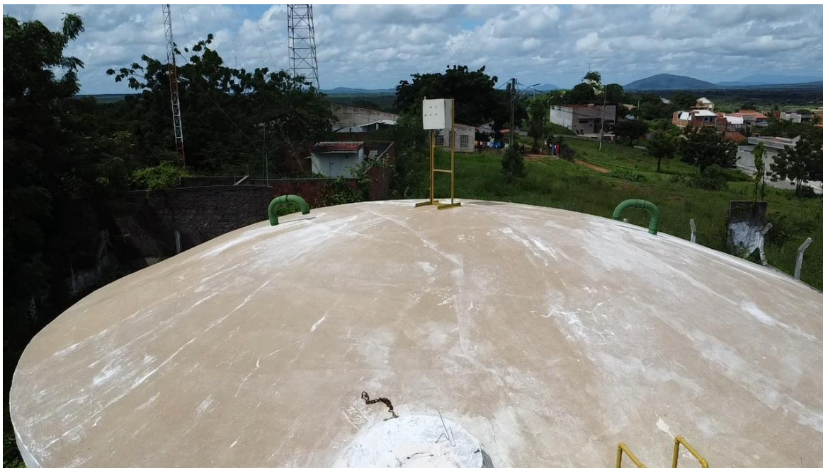
Foto 33 - RAP-02 (Sede): tubulações de ventilação sem tela de proteção.
