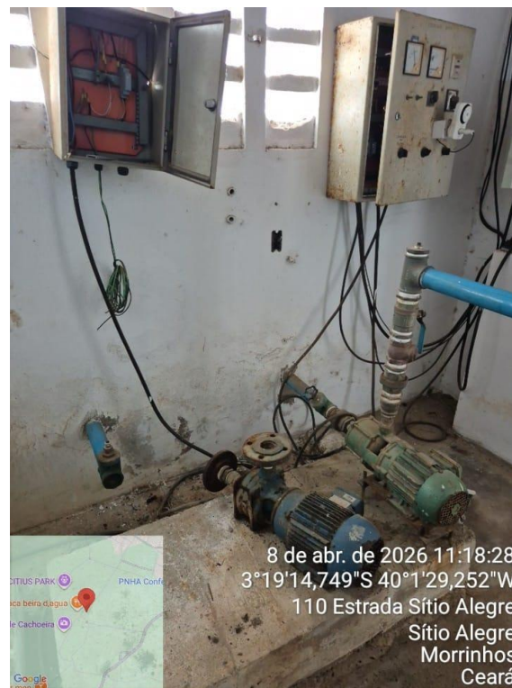
Foto 44 - ETA / EELF-01 (Sítio Alegre): cabeamento inadequado e quadro de comando oxidado.
