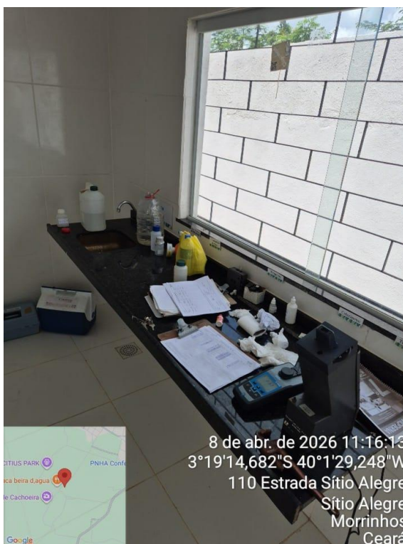
Foto 38 - ETA / Laboratório (Sítio Alegre): carência de armários para armazenagem de materiais e equipamentos, ocupando e sobrecarregando a bancada de trabalho.
