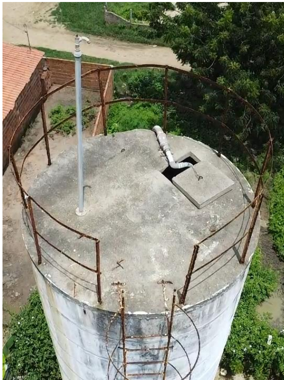
Foto 17 - REL-02 (Sítio Alegre): tubulação instalada, através da abertura da entrada de inspeção.
