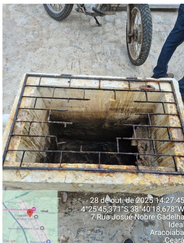
Foto 8 - ETA Ideal/Aracoiaba: grade oxidada e com defeito.
