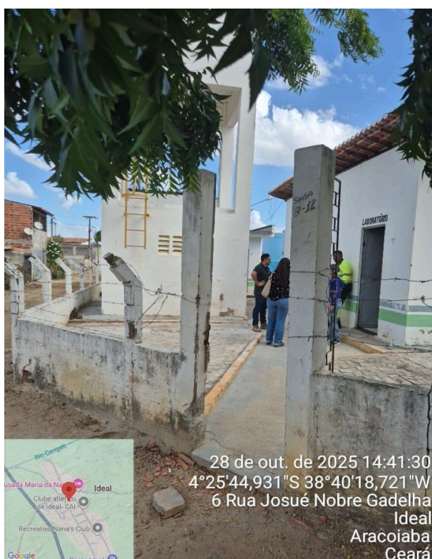
Foto 3 - ETA Ideal/Aracoiaba: pintura desgastada e muro/cerca com defeito.
