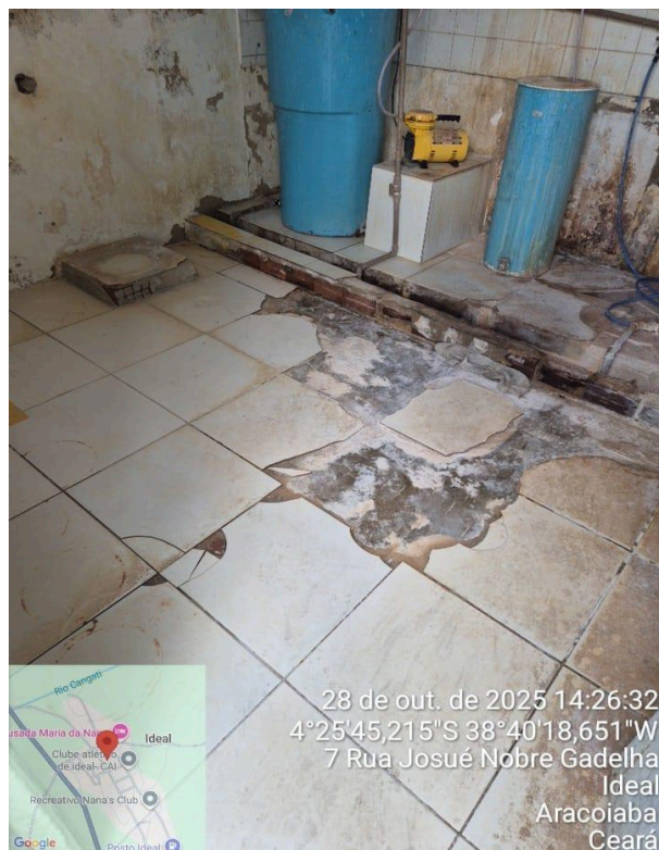
Foto 14 - ETA Ideal/Aracoiaba - Casa de química: paredes desgastadas, piso danificado e com revestimento solto.
