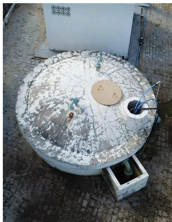
Foto 24 - Capivara/Aracoiaba - RSE-03: tampa de inspeção deslocada.
