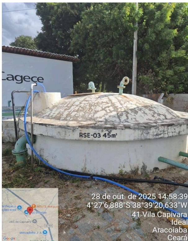
Foto 21 - Capivara/Aracoiaba - RSE-03: pintura desgastada e presença de rachaduras.
