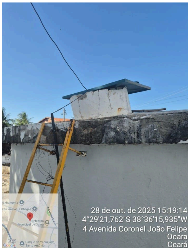
Foto 33 - Sede - RSE-05: pintura desgastada e presença de rachadura.
