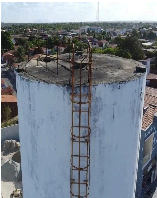
Foto 37 - Vila São Marcos - REL-05: escada oxidada e guarda-corpo danificado.
