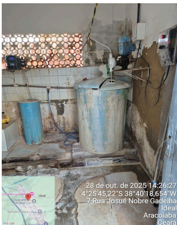
Foto 15 - ETA Ideal/Aracoiaba - Casa de química: paredes desgastadas, piso danificado e com revestimento solto.
