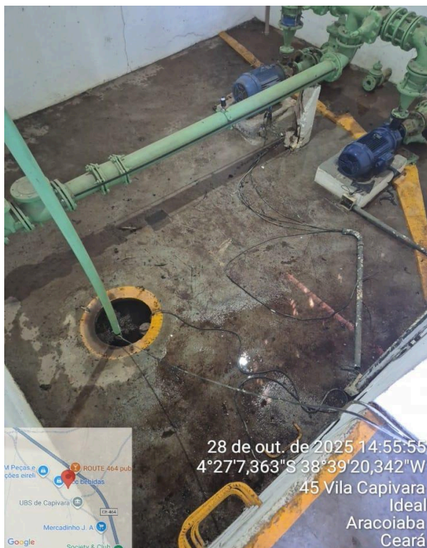
Foto 29 - Capivara/Aracoiaba - EEAT-02: fiação inadequada e presença de vazamento.
