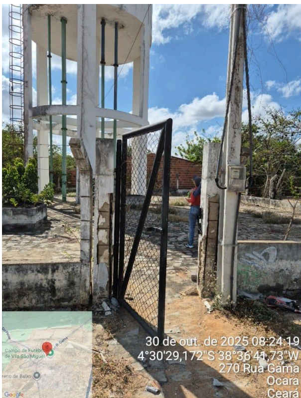
Foto 39 - Sereno de Cima - REL-06: muro do portão de acesso com armadura exposta.
