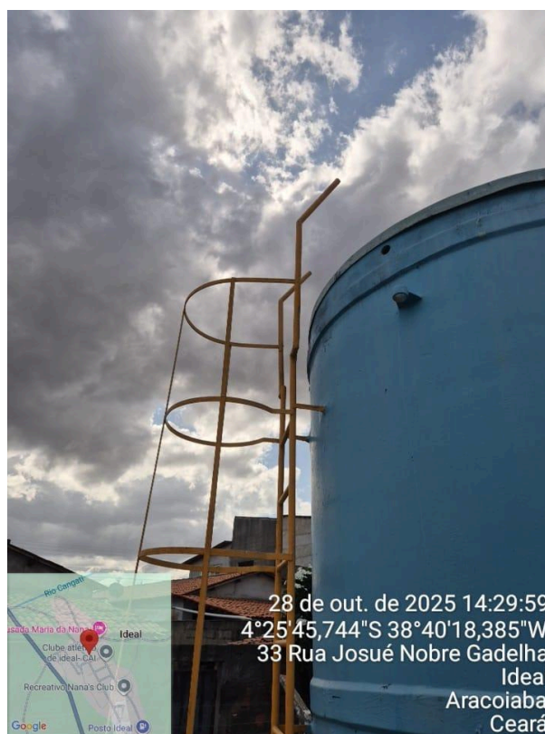
Foto 20 - ETA Ideal/Aracoiaba - Filtro: corrimão do guarda-corpo inadequado.
