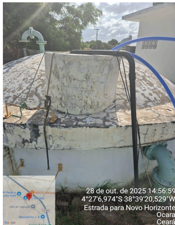
Foto 22 - Capivara/Aracoiaba - RSE-03: pintura desgastada, presença de rachaduras e tubulação improvisada.
