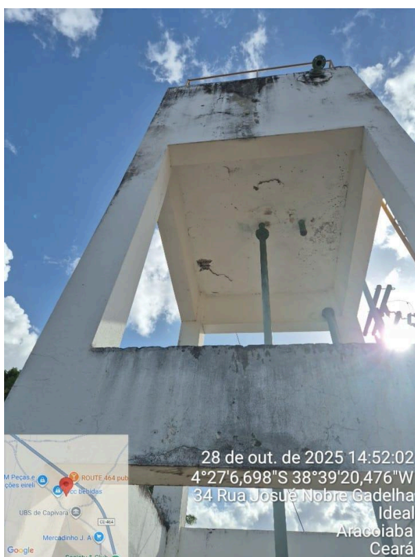
Foto 27 - Capivara/Aracoiaba - REL-02: pintura desgastada e presença de rachaduras.
