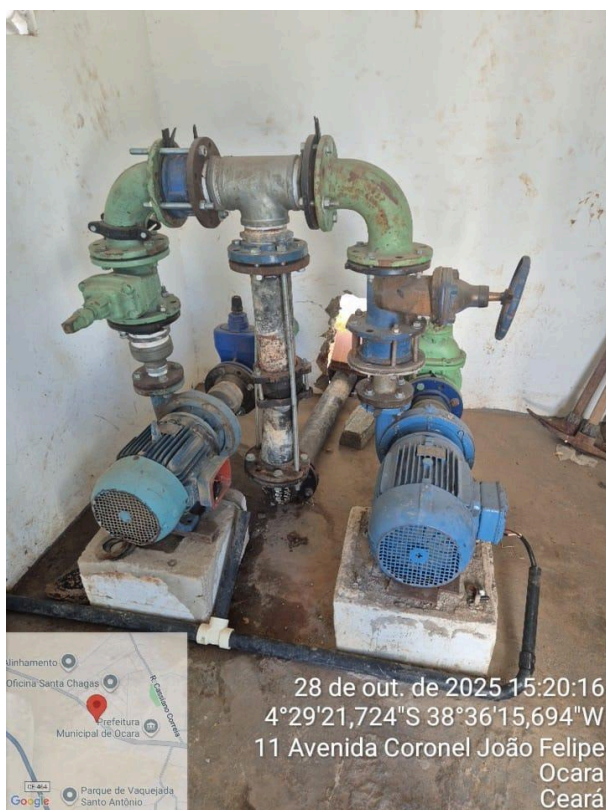
Foto 35 - Sede - Casa de comando: peças metálicas oxidadas.
