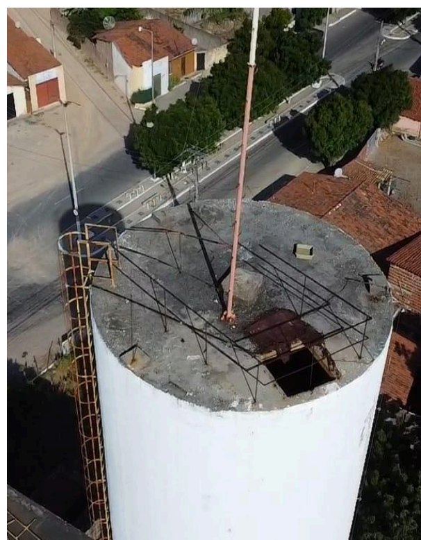
Foto 32 - Sede - REL-04: guarda-corpo com defeito, ausência de tampa e presença de oxidação.
