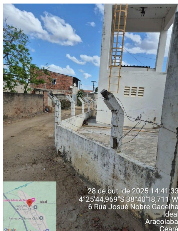
Foto 4 - ETA Ideal/Aracoiaba: pintura desgastada e muro/cerca com defeito.
