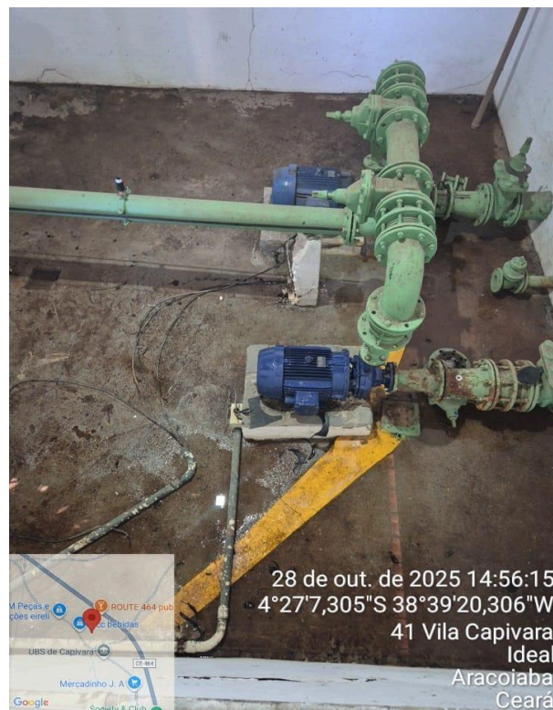
Foto 30 - Capivara/Aracoiaba - EEAT-02: fiação inadequada, presença de vazamento e de oxidação.
