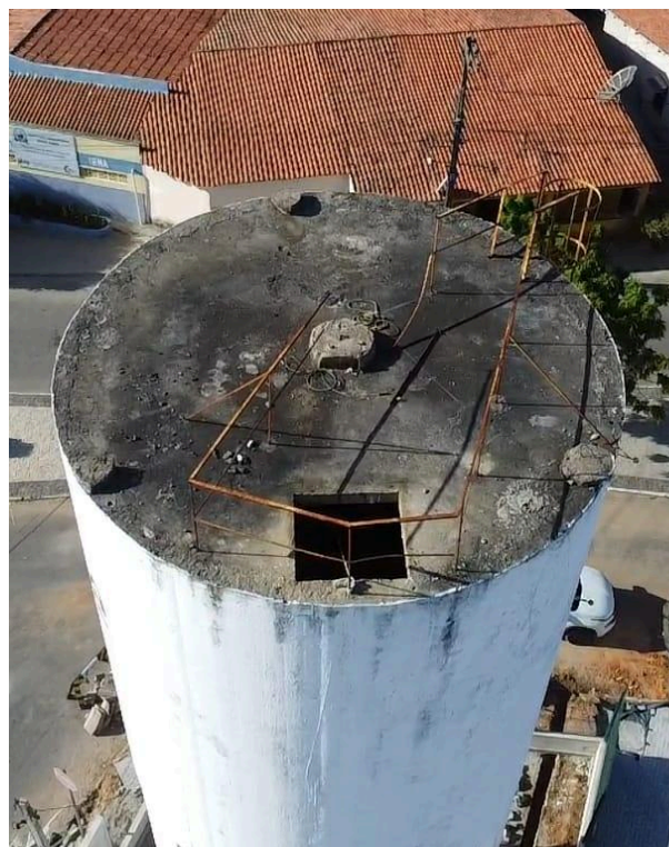
Foto 38 - Vila São Marcos - REL-05: escada oxidada, guarda-corpo danificado e ausência de tampa.
