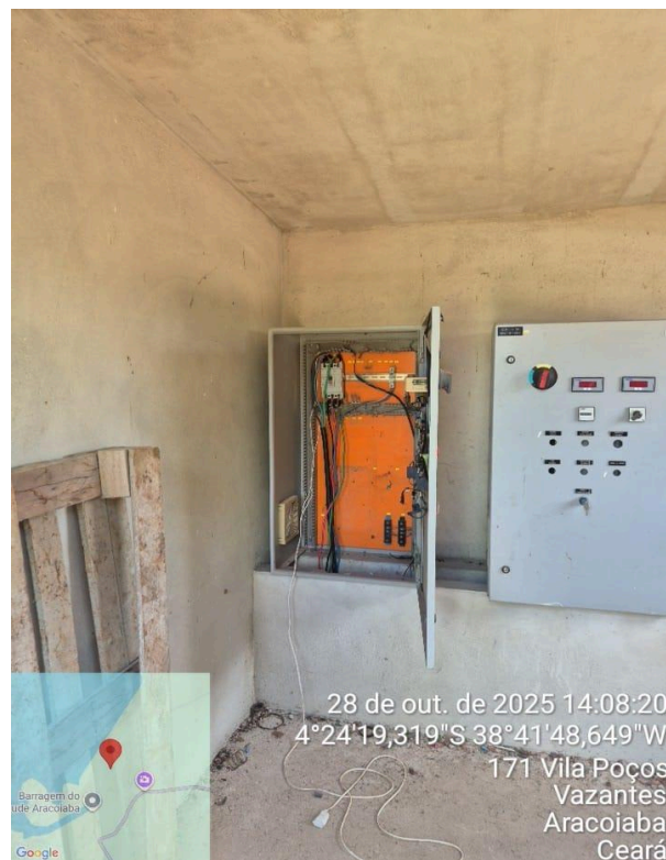
Foto 2 - Captação/Aracoiaba - Casa de comando: fiação inadequada.
