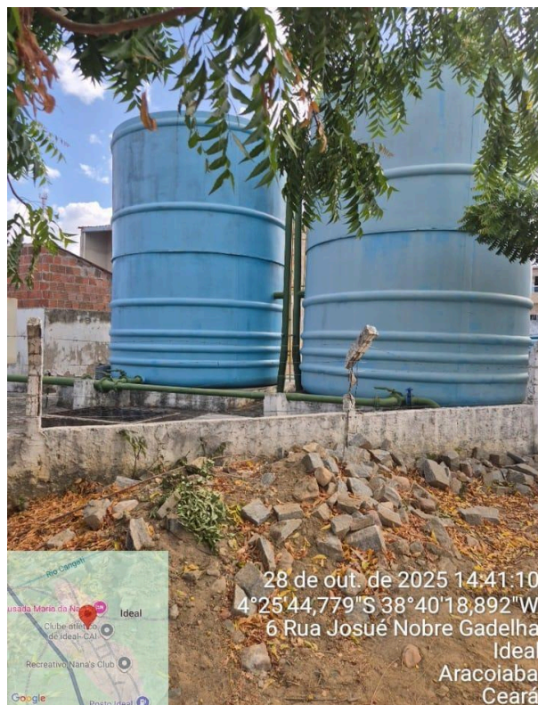
Foto 6 - ETA Ideal/Aracoiaba: pintura desgastada e muro/cerca com defeito.
