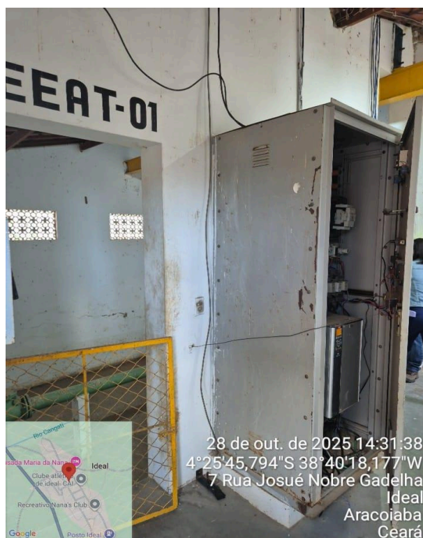
Foto 16 - ETA Ideal/Aracoiaba - EEAT-01: fiação inadequada.
