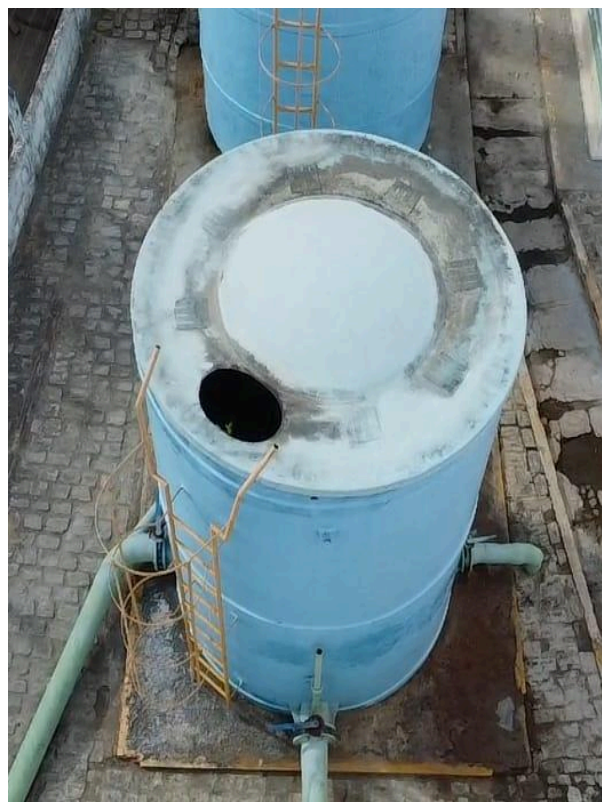
Foto 18 - ETA Ideal/Aracoiaba - Filtro: ausência de tampa de inspeção.
