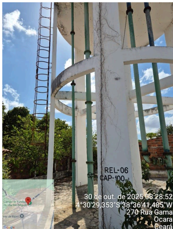
Foto 42 - Sereno de Cima - REL-06: pintura desgastada e sinais de vazamento.
