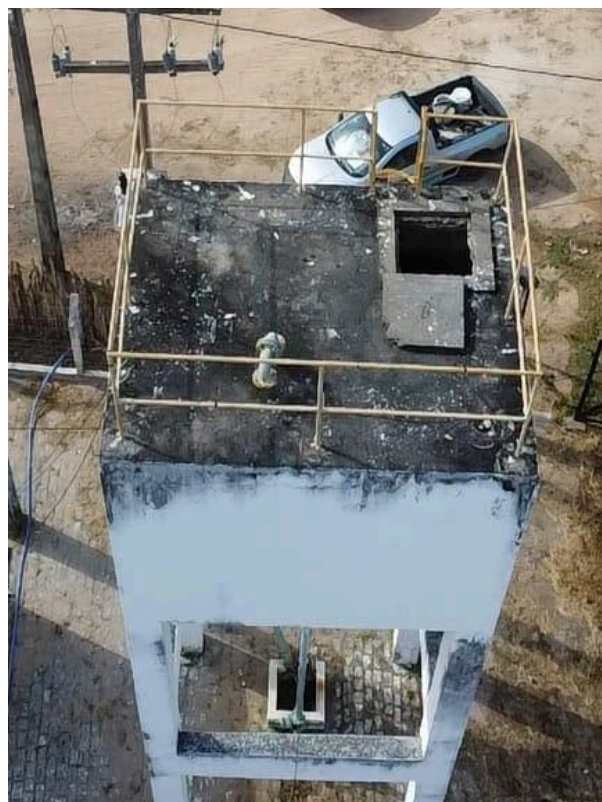
Foto 26 - Capivara/Aracoiaba - REL-02: tampa de inspeção deslocada.
