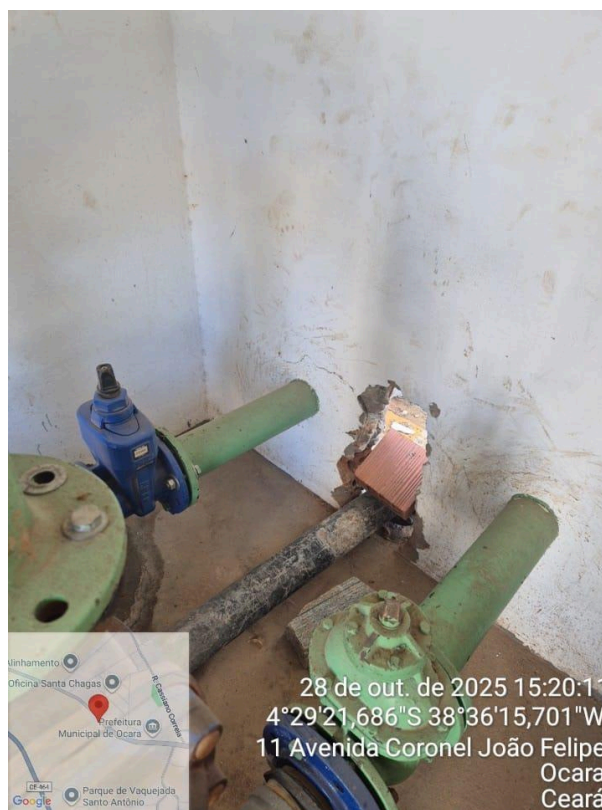
Foto 36 - Sede - Casa de comando: perfuração inadequada na parede.
