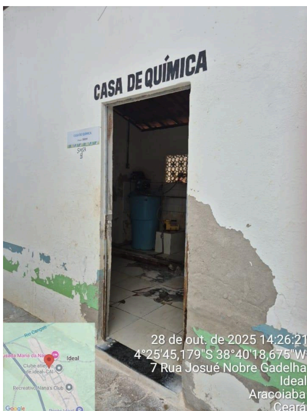
Foto 11 - ETA Ideal/Aracoiaba - Casa de química: parede desgastada.
