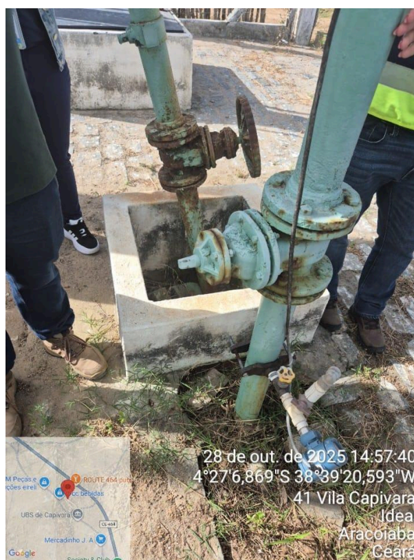
Foto 28 - Capivara/Aracoiaba - REL-02: presença de oxidação.
