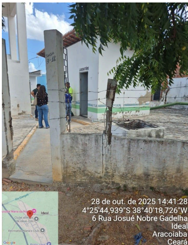
Foto 5 - ETA Ideal/Aracoiaba: pintura desgastada e muro/cerca com defeito.
