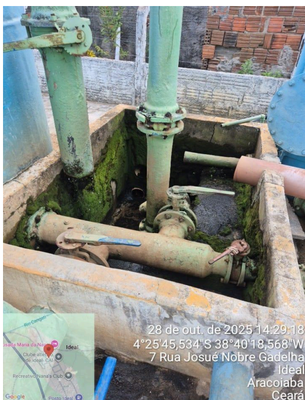
Foto 7 - ETA Ideal/Aracoiaba: presença de algas e musgos nas superfícies úmidas da estrutura.
