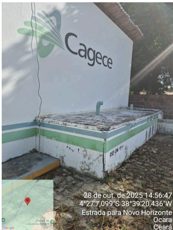
Foto 25 - Capivara/Aracoiaba - RSE-04: pintura desgastada e presença de rachaduras.
