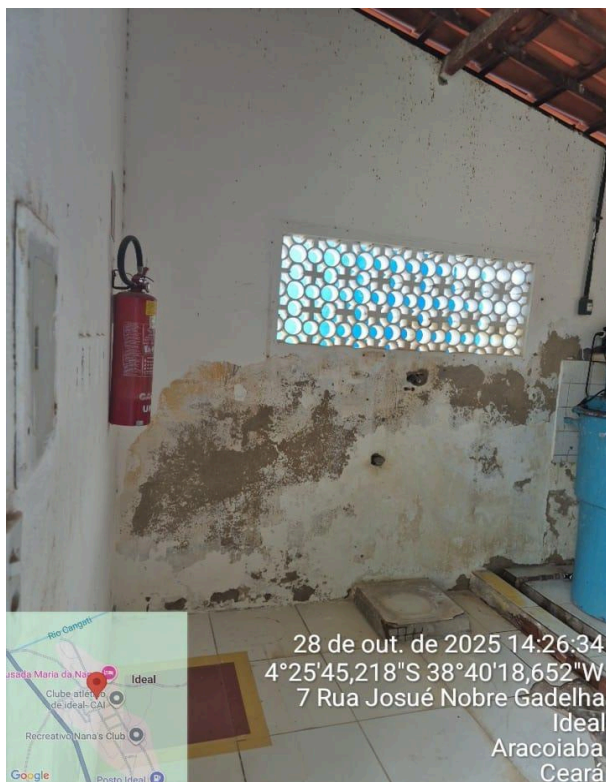
Foto 13 - ETA Ideal/Aracoiaba - Casa de química: paredes desgastadas, piso danificado e com revestimento solto.
