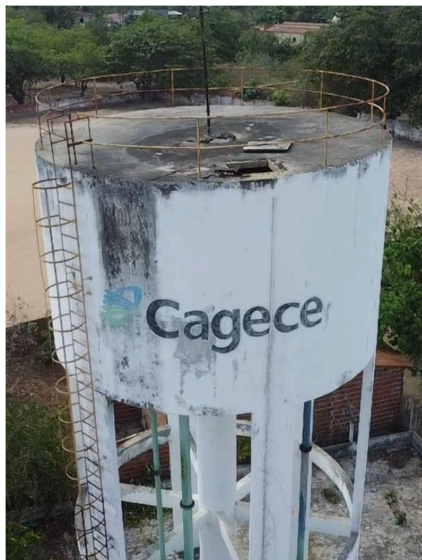
Foto 40 - Sereno de Cima - REL-06: pintura desgastada, escada e guarda-corpo oxidados.
