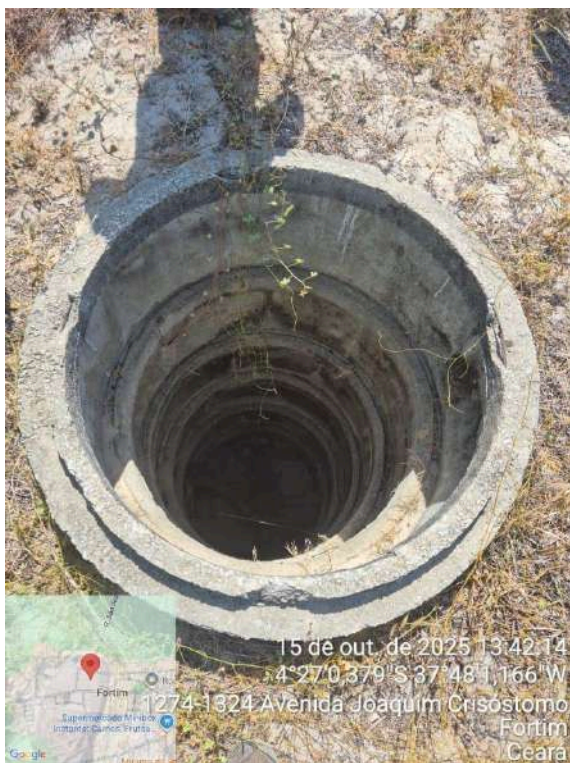
Foto 25 - Poços desativados (sem identificação): Necessário aterrar os poços, sem identificação com riscos de acidentes por não ter proteção.
