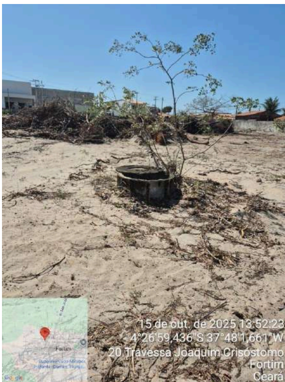
Foto 29 - Poços desativados (sem identificação): Necessário aterrar os poços, sem identificação com riscos de acidentes por não ter proteção.
