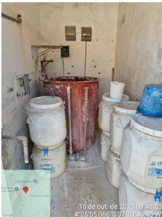
Foto 105 - Casa de Química: sem espaço para circulação do operador e adequado manuseio dos materiais.
