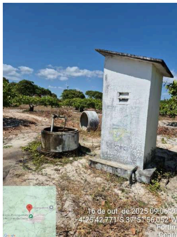
Foto 84 - Poço PT-22: pintura desgastada do quadro de comando, identificação desgastada.
