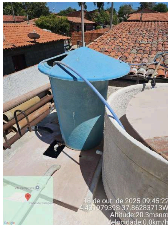
Foto 114 - RAP-01: falta da tela no respirador e o clorador não permite a vedação do reservatório.
