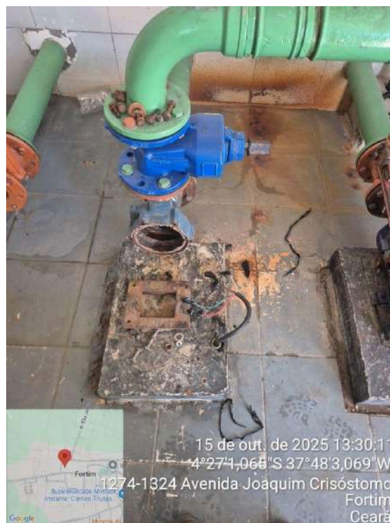
Foto 12 - Casa de Bombas: bomba retirada para manutenção, mas com parafusos soltos.
