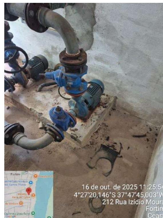
Foto 48 - EERD-01: Peças da bomba oxidadas, com restos de material e sujidades no piso.
