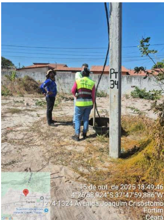
Foto 37 - PT-34: fiação pendurada com riscos de acidente e sem eletrodutos.
