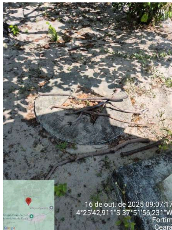
Foto 86 - Poço PT-22: tampa do poço e porta oxidada ao lado caída no chão.
