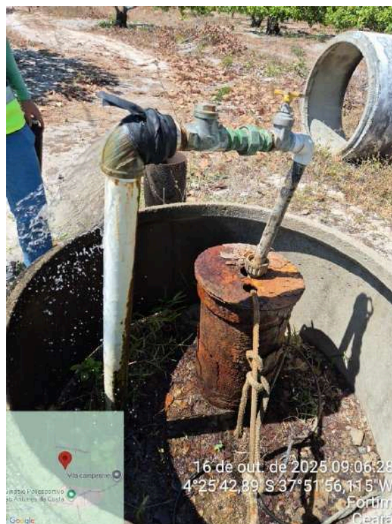
Foto 88 - Poço PT-22: estrutura da captação oxidada e com vazamento extremo.
