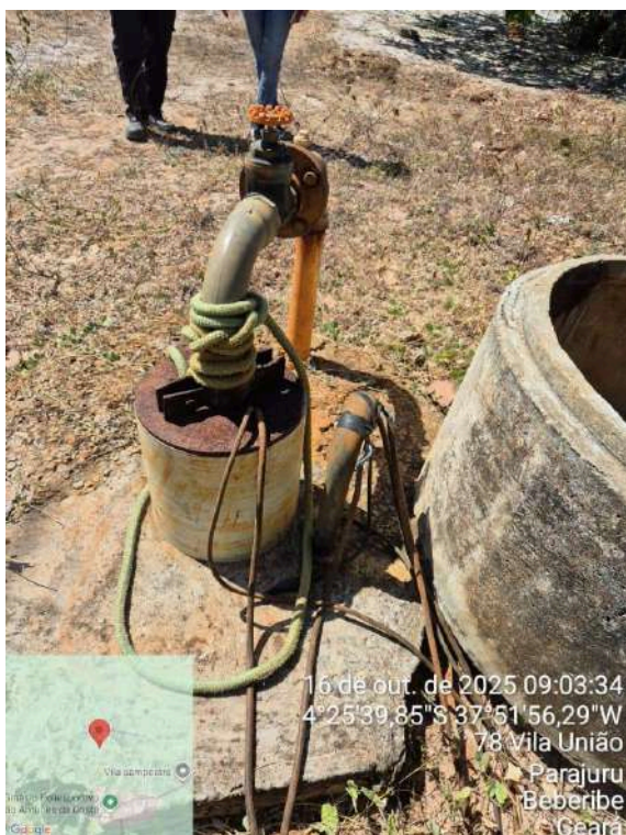
Foto 79 - Poço PT-17: estrutura da captação oxidada, captação sem proteção, possível presença de ferro.
