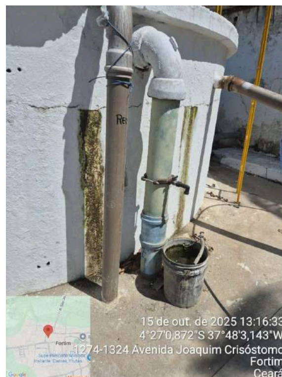
Foto 19 - RAP-02: Vazamento na parede do reservatório, com rachaduras.
