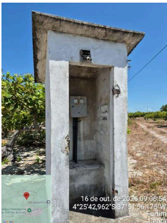
Foto 83 - Poço PT-22: Sem porta, sem lâmpada, com acúmulo de sujeira.
