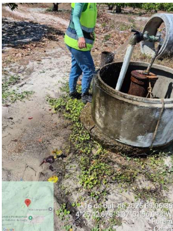
Foto 87 - Poço PT-22: estrutura da captação oxidada e com vazamento extremo.
