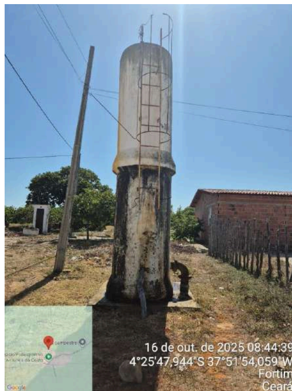
Foto 54 - Tanque de Reunião: Muitos pontos de vazamento, estrutura corroída.
