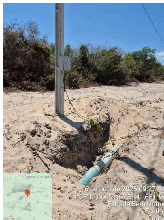
Foto 96 - Poços PT-43 e PT-45: Fiação exposta sem eletrodutos, partes oxidadas.
