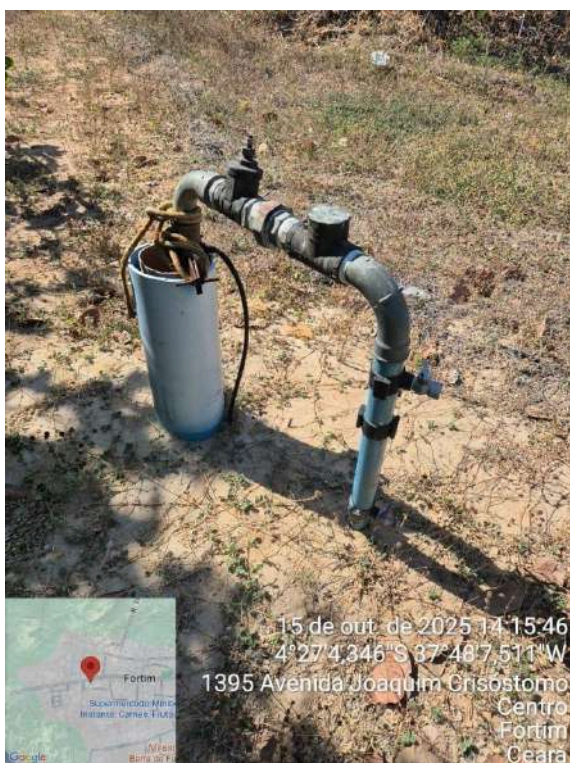
Foto 47 - Área dos poços: poços da região sem identificação no local, com alguns pontos com bomba fazendo barulho por estar operando em baixa vazão (estrangulada).
