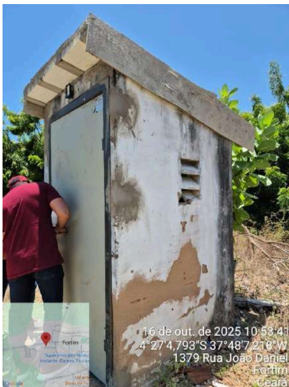
Foto 41 - Quadro de comando - Área dos poços: parede degradada interna e externamente com manchas de lodo.
