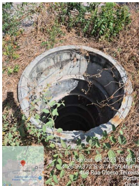
Foto 28 - Poços desativados (sem identificação): Necessário aterrar os poços, sem identificação com riscos de acidentes por não ter proteção.
