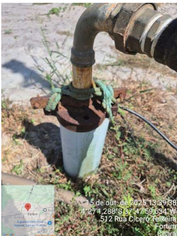
Foto 31 - PT-38: Peças da captação oxidadas, apresentando início de vazamento.
