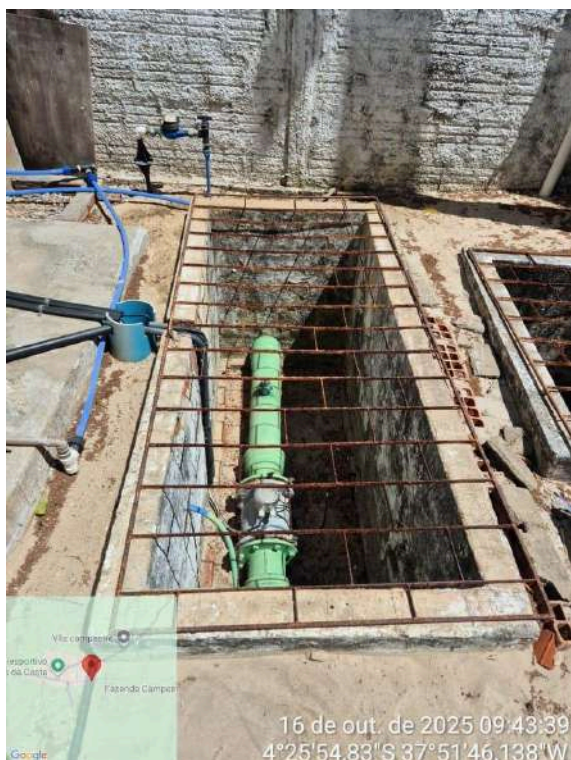
Foto 115 - Área Externa: Proteção inadequada dos registros de entrada, com risco de queda e grades oxidadas.
