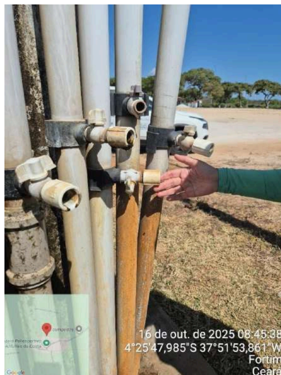
Foto 56 - Tanque de Reunião: tubulações com oxidação, coloração alaranjada indicando possível presença de ferro.
