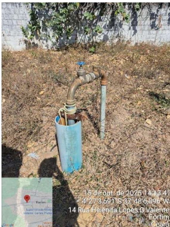
Foto 45 - Área dos poços: poços da região sem identificação no local, com alguns pontos com bomba fazendo barulho por estar operando em baixa vazão (estrangulada).
