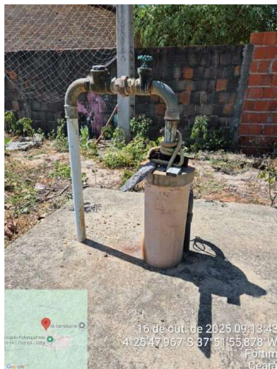
Foto 92 - Poço PT-25: estrutura da captação com tubulação oxidada e com sinais de vazamento.
