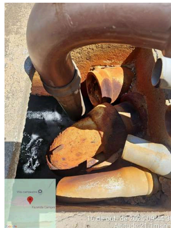
Foto 112 - RAP-01: oxidação severa na tubulação.
