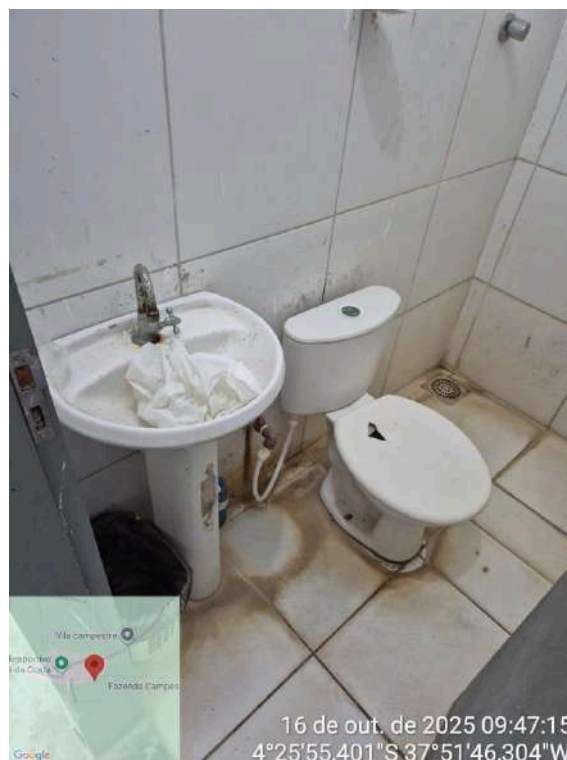
Foto 108 - Sala de Apoio e Banheiro: banheiro com sujeiras e degradação das louças.
