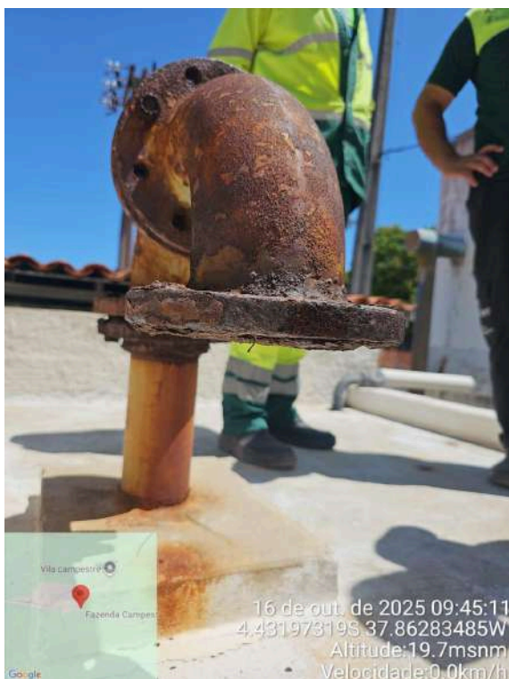
Foto 111 - RAP-01: oxidação severa na tubulação.
