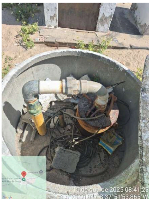
Foto 63 - Poço PT-11: estrutura da captação oxidada e com detritos na parte interna da proteção, com pedaços quebrados com armadura exposta.
