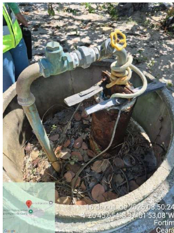
Foto 82 - Poço PT-21: estrutura da captação oxidada, sem identificação.
