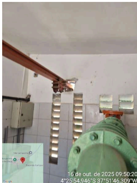
Foto 102 - Casa de Bombas: viga deixando abertura na parede.
