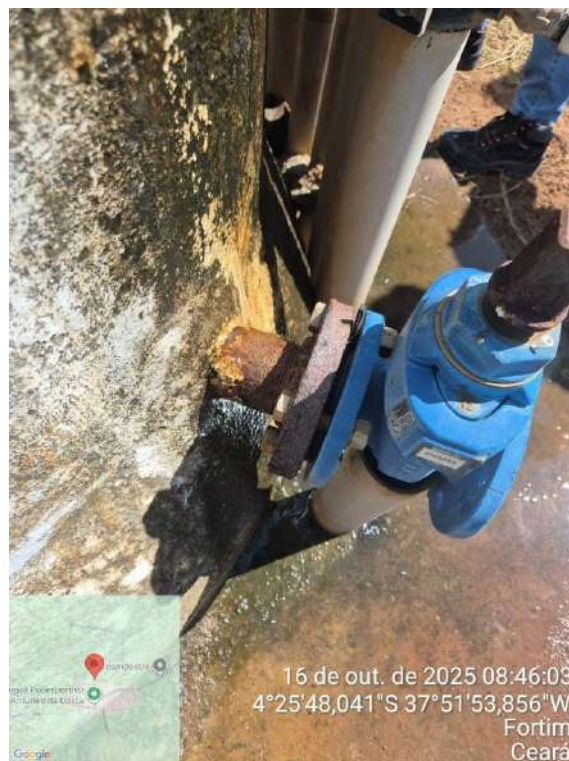
Foto 58 - Tanque de Reunião: estrutura corroída, tubulações com oxidação, presença de lodo, tanque com pintura deteriorada, coloração alaranjada indicando possível presença de ferro.
