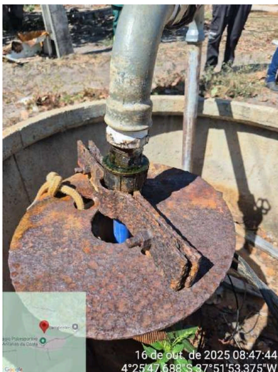
Foto 67 - Poço PT-12: estrutura da captação oxidada e com vazamento, sem identificação.
