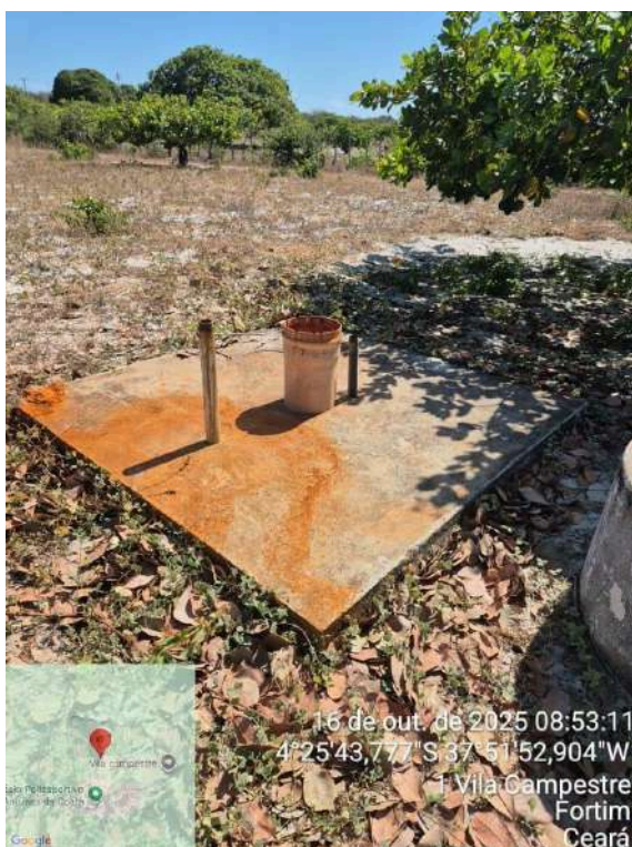
Foto 59 - Poços desativados (PT-23, PT-24, PT-26): Necessário fechamento dos poços, possível fonte de contaminação, com estruturas oxidadas, degradadas e com presença de ferro.
