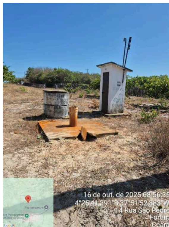
Foto 60 - Poços desativados (PT-23, PT-24, PT-26): Necessário fechamento dos poços, possível fonte de contaminação, com estruturas oxidadas, degradadas e com presença de ferro.
