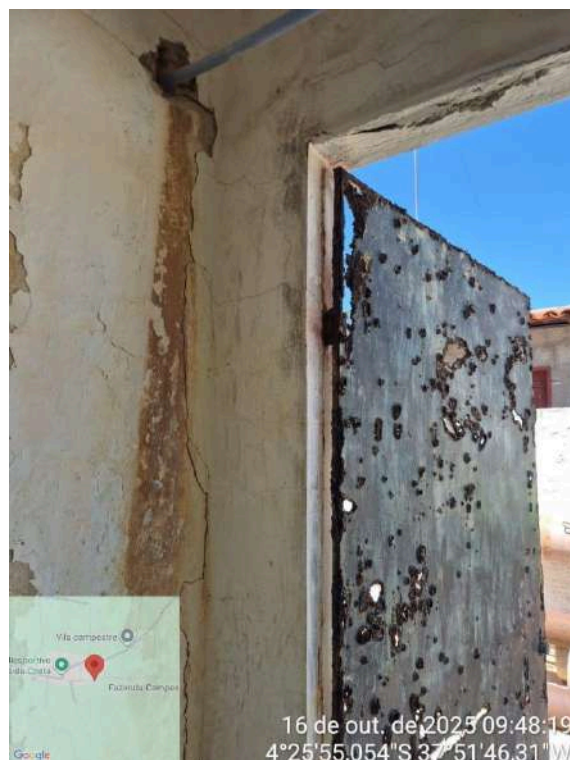
Foto 104 - Casa de Química: parede degradada, parte superior da parede com armadura exposta.
