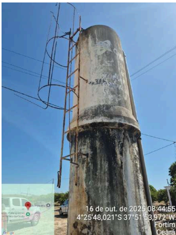
Foto 53 - Tanque de Reunião: Muitos pontos de vazamento, estrutura corroída.
