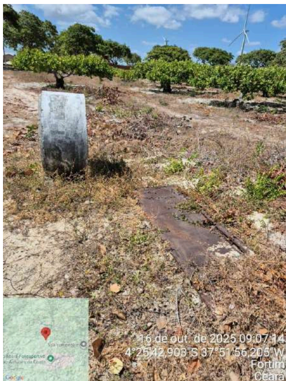
Foto 85 - Poço PT-22: tampa do poço e porta oxidada ao lado caída no chão.
