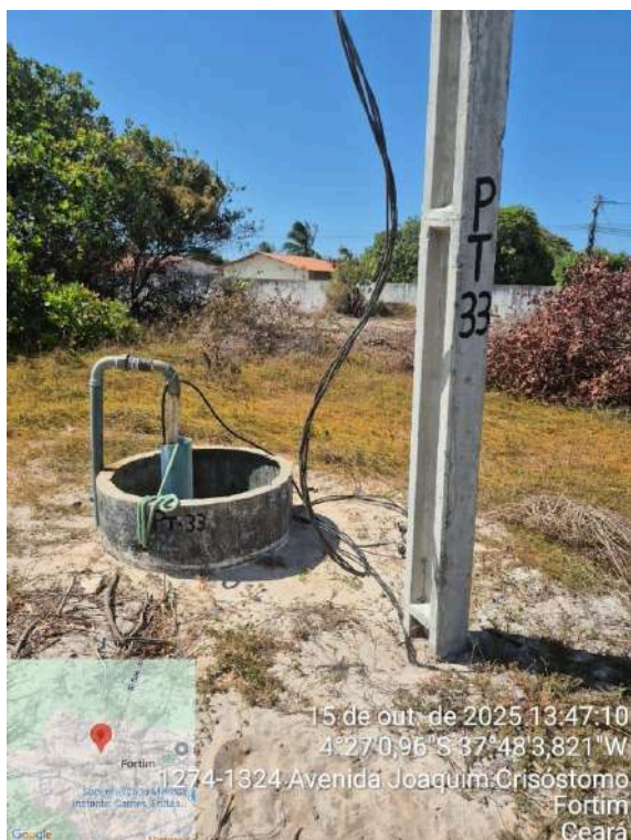
Foto 35 - PT-33: fiação pendurada com riscos de acidente e sem eletrodutos.
