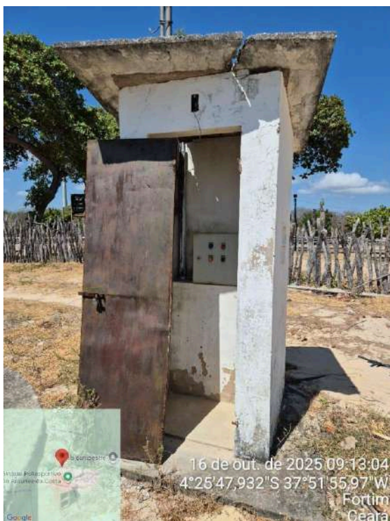
Foto 91 - Poço PT-25: Porta oxidada e só sobreposta apresentando riscos à operação.
