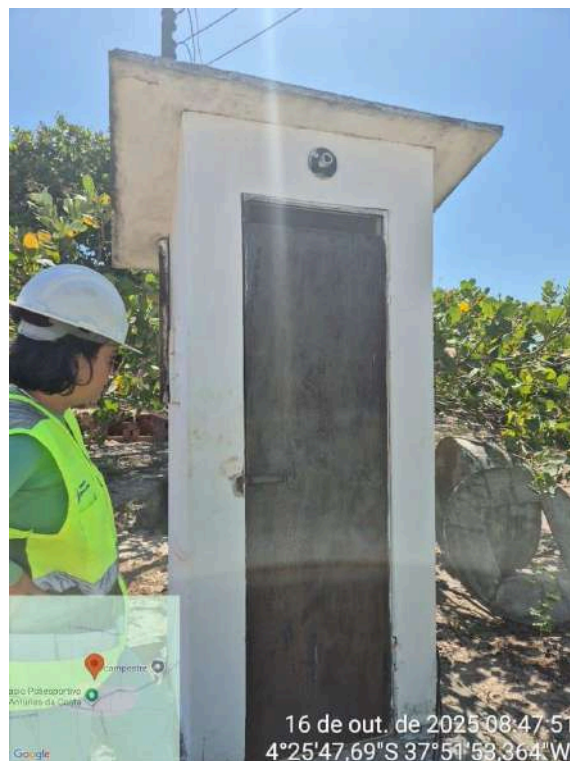
Foto 66 - Poço PT-12: Porta oxidada, sem lâmpada na parte externa do quadro de comando.
