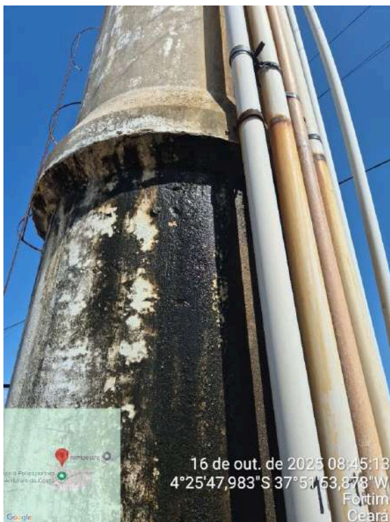
Foto 57 - Tanque de Reunião: estrutura corroída, tubulações com oxidação, presença de lodo, tanque com pintura deteriorada, coloração alaranjada indicando possível presença de ferro.
