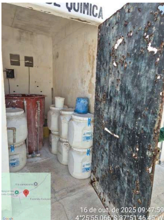
Foto 103 - Casa de Química: Porta completamente corroída, sem ventilação adequada e sem EPIs para manuseio pelo operador.
