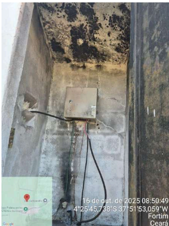
Foto 81 - Poço PT-21: quadro de comando com sujeira e fiação exposta apresentando riscos à operação.
