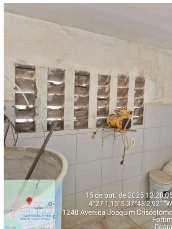
Foto 4 - Casa de Química / Laboratório: Cobogós com armadura exposta.
