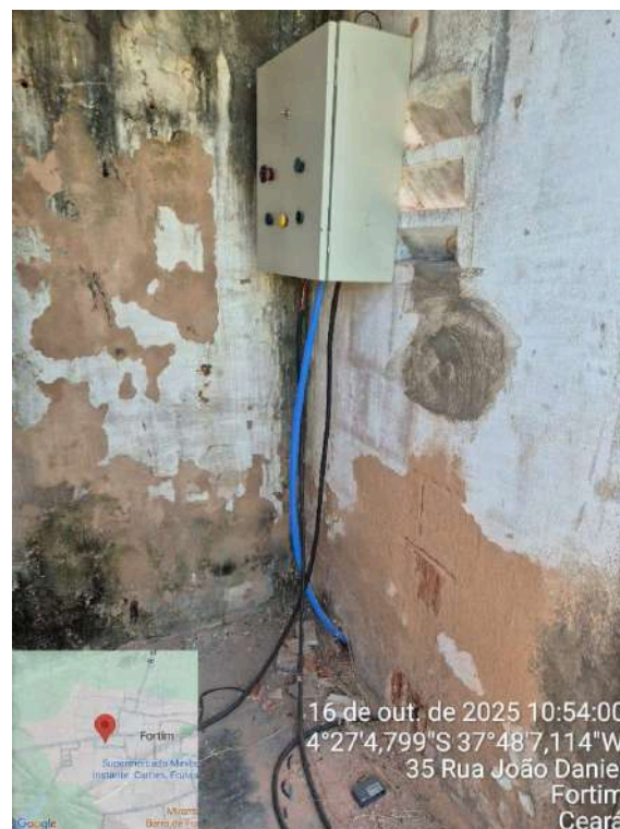
Foto 40 - Quadro de comando - Área dos poços: Sem identificação de riscos, fiação sem proteção e eletrodutos.
