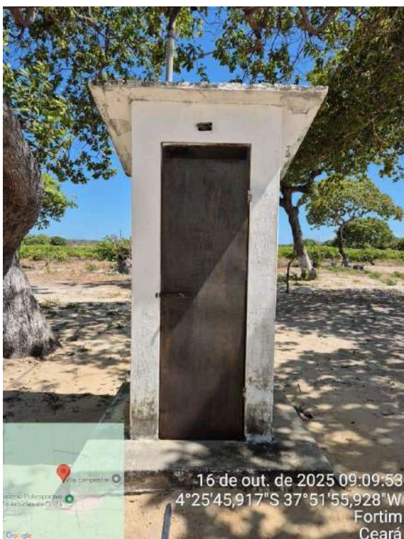
Foto 71 - Poço PT-13: porta oxidada, sem lâmpada na parte externa do quadro de comando.
