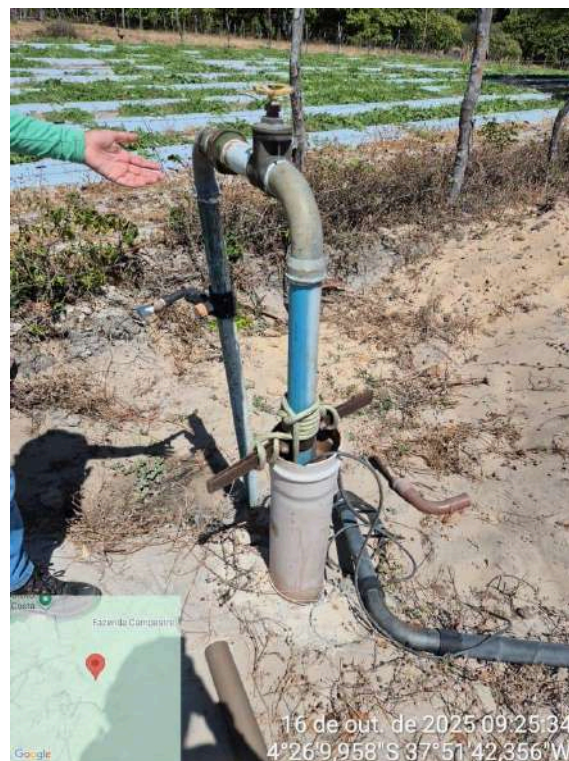
Foto 94 - Poços PT-43 e PT-45: Fiação exposta sem eletrodutos, partes oxidadas.
