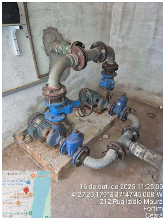
Foto 49 - EERD-01: Peças da bomba oxidadas, com restos de material e sujidades no piso.
