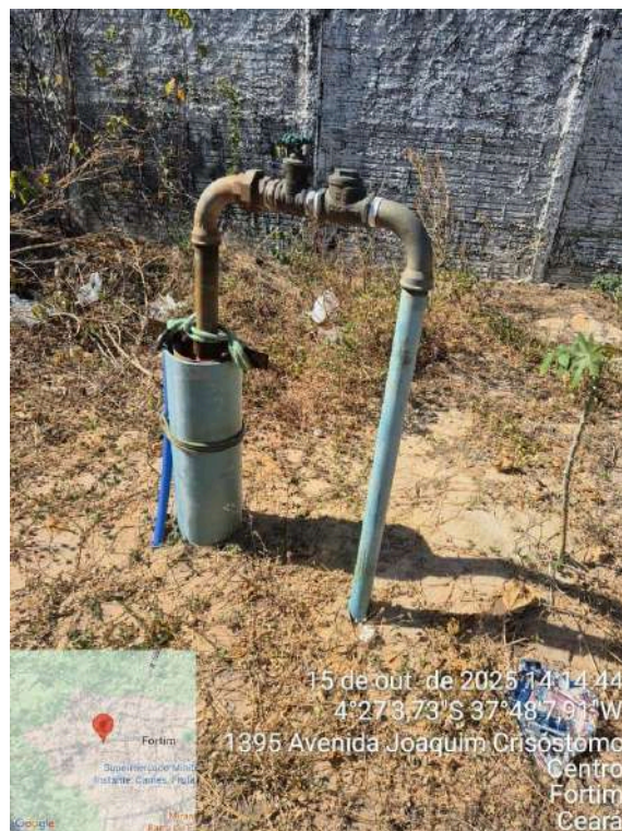
Foto 46 - Área dos poços: poços da região sem identificação no local, com alguns pontos com bomba fazendo barulho por estar operando em baixa vazão (estrangulada).
