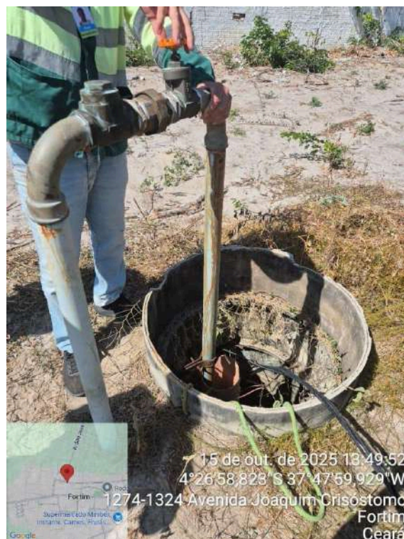
Foto 36 - PT-34: Baixa vazão, opera estrangulado.
