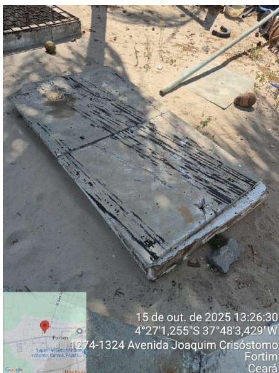
Foto 17 - Estruturas externas: Tampa quebrada de tubulação para o macromedidor.
