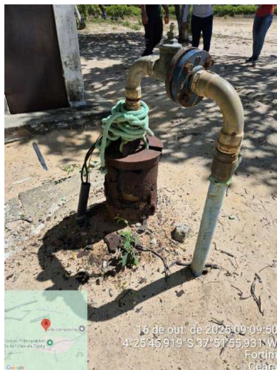
Foto 68 - Poço PT-13: Captação sem proteção, com oxidação extrema.
