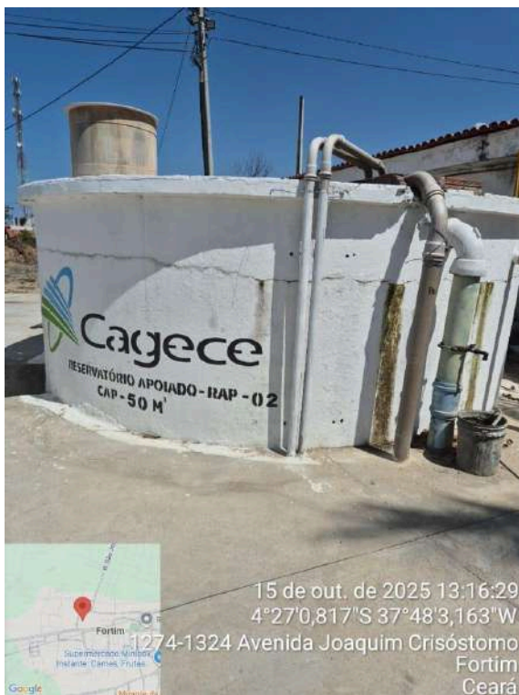
Foto 21 - RAP-02: Vazamento na parede do reservatório, com rachaduras.
