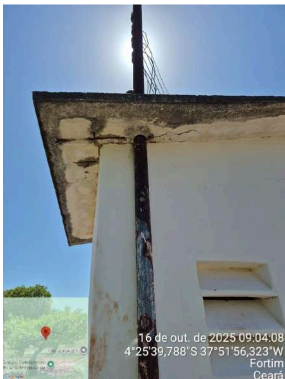
Foto 75 - Poço PT-17: estrutura do quadro de comando com armadura exposta, pintura deteriorada.
