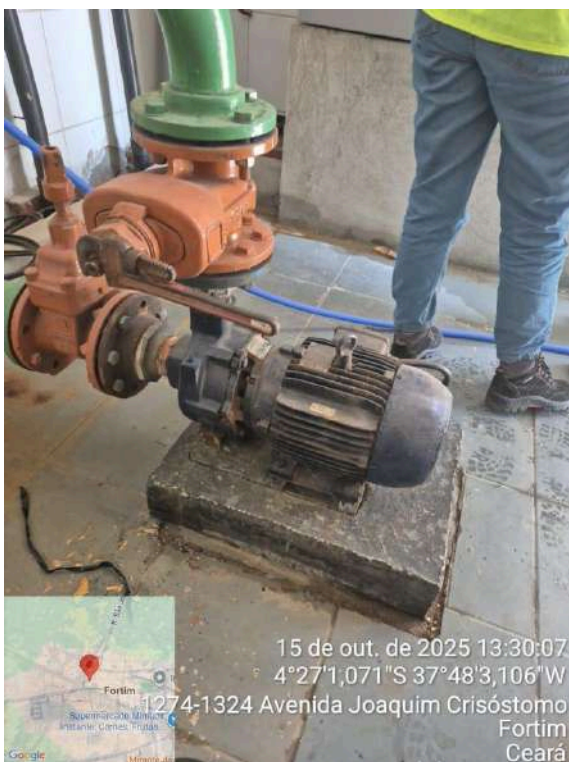
Foto 11 - Casa de Bombas: chave presa a válvula da bomba.
