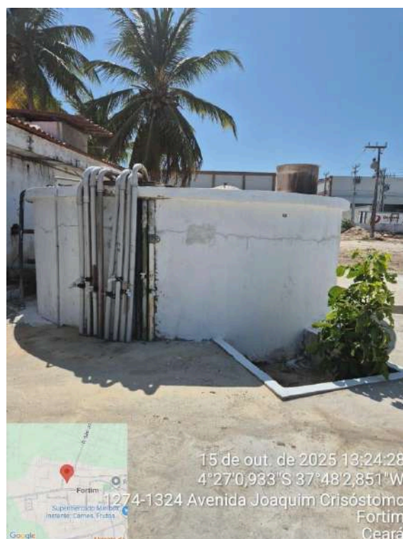
Foto 20 - RAP-02: Vazamento na parede do reservatório, com rachaduras.
