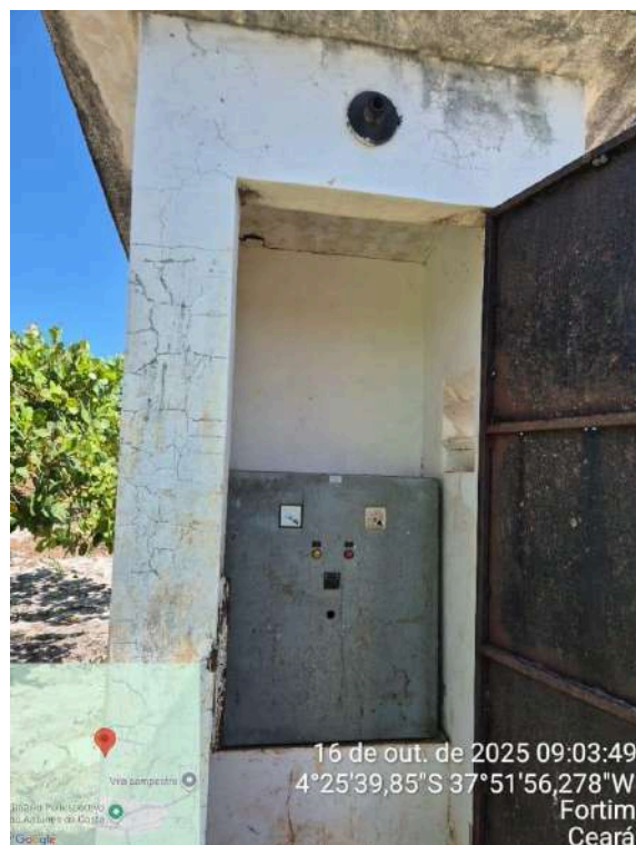
Foto 76 - Poço PT-17: pintura deteriorada, porta oxidada, sem lâmpada na parte externa.
