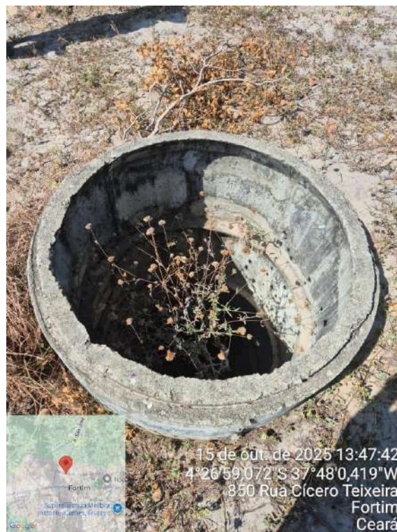
Foto 26 - Poços desativados (sem identificação): Necessário aterrar os poços, sem identificação com riscos de acidentes por não ter proteção.
