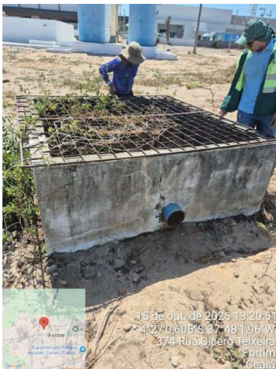
Foto 13 - Estruturas externas: Acúmulo de vegetação em estrutura desativada.
