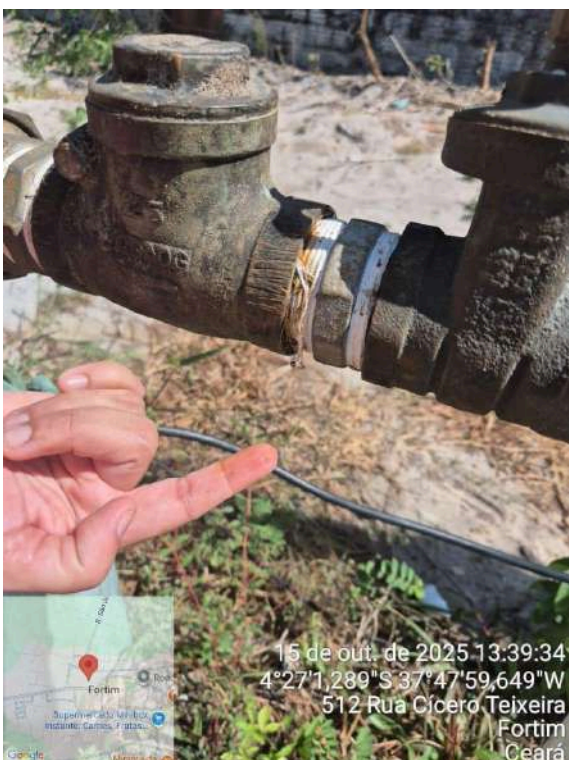
Foto 32 - PT-38: Peças da captação oxidadas, apresentando início de vazamento.
