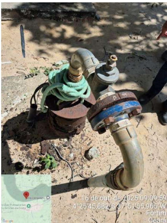
Foto 69 - Poço PT-13: Captação sem proteção, com oxidação extrema.
