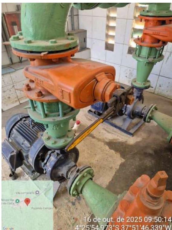
Foto 99 - Casa de Bombas: chave encaixada para manuseio da válvula.
