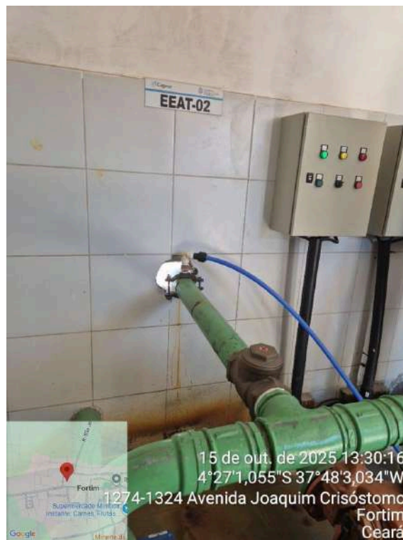
Foto 10 - Casa de Bombas: tubulação da bomba passando pela parede sem vedação adequada.
