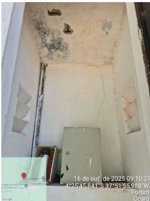
Foto 73 - Poço PT-13: armadura exposta na parte interna e externa.
