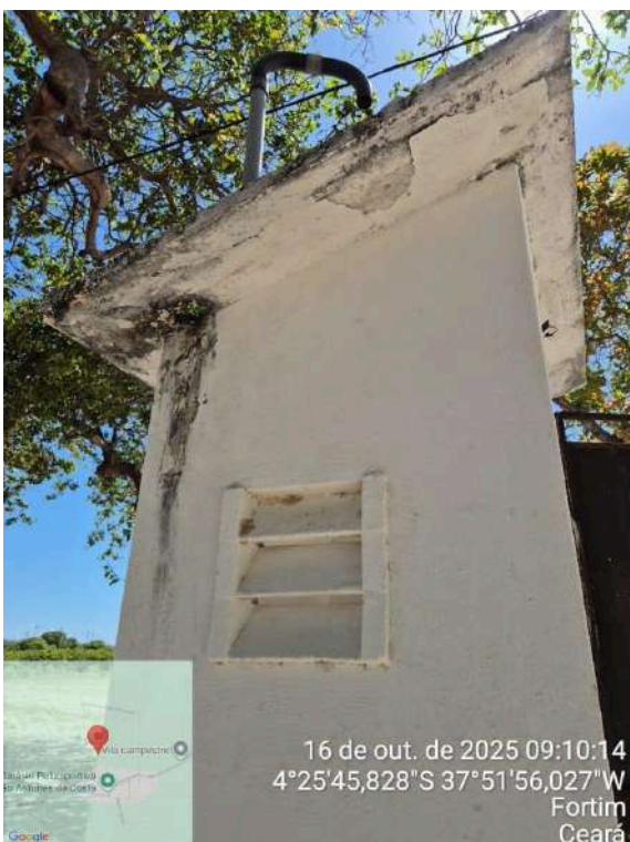
Foto 72 - Poço PT-13: armadura exposta na parte interna e externa, identificação desgastada.
