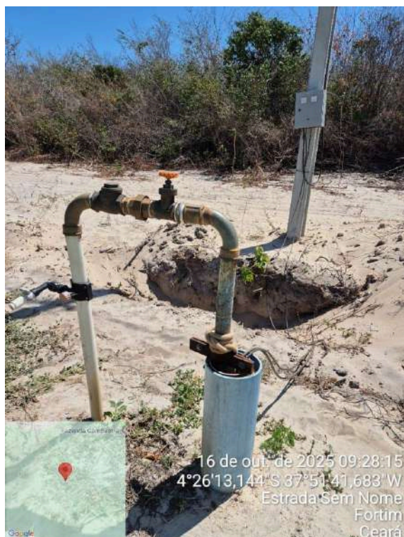
Foto 95 - Poços PT-43 e PT-45: Fiação exposta sem eletrodutos, partes oxidadas.
