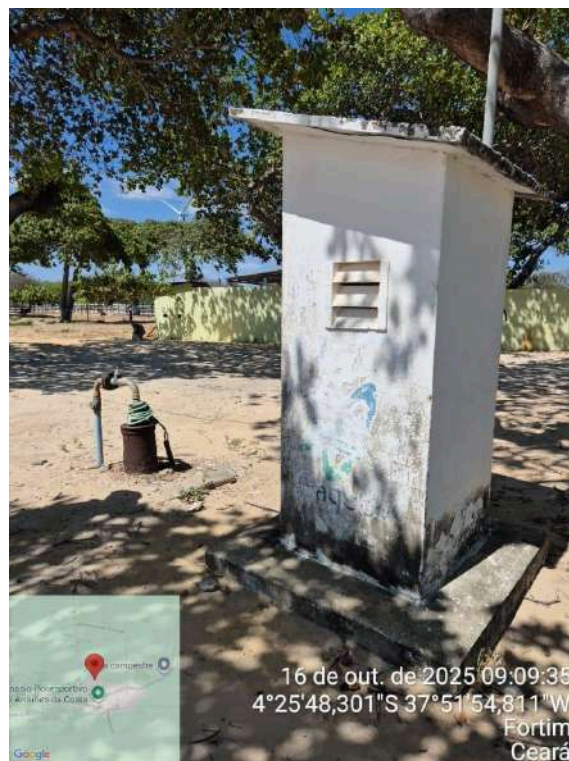
Foto 70 - Poço PT-13: armadura exposta na parte interna e externa, identificação desgastada.
