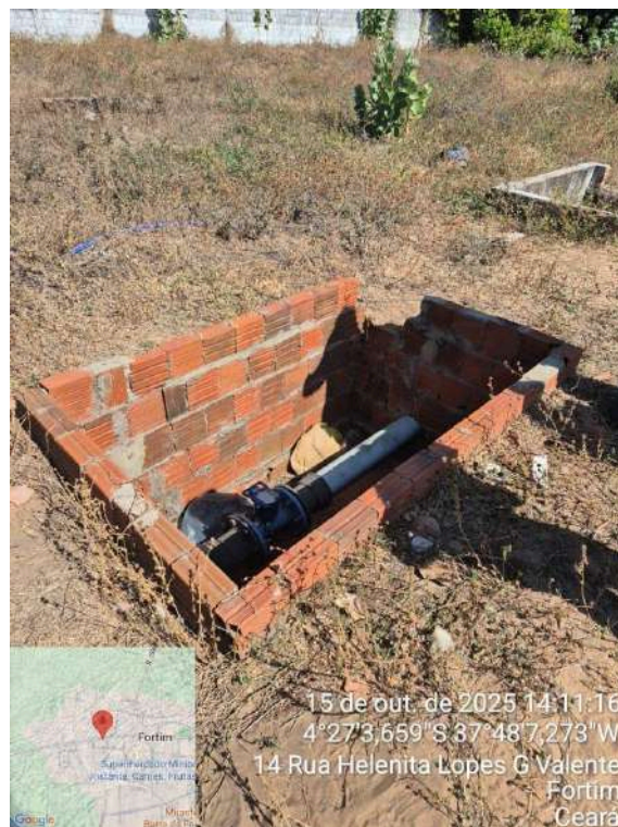
Foto 42 - Área dos poços: Chegada da ETA Campestre com proteção quebrada.
