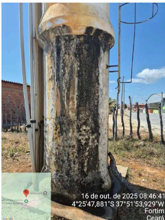
Foto 55 - Tanque de Reunião: presença de lodo, tanque com pintura deteriorada, coloração alaranjada indicando possível presença de ferro.
