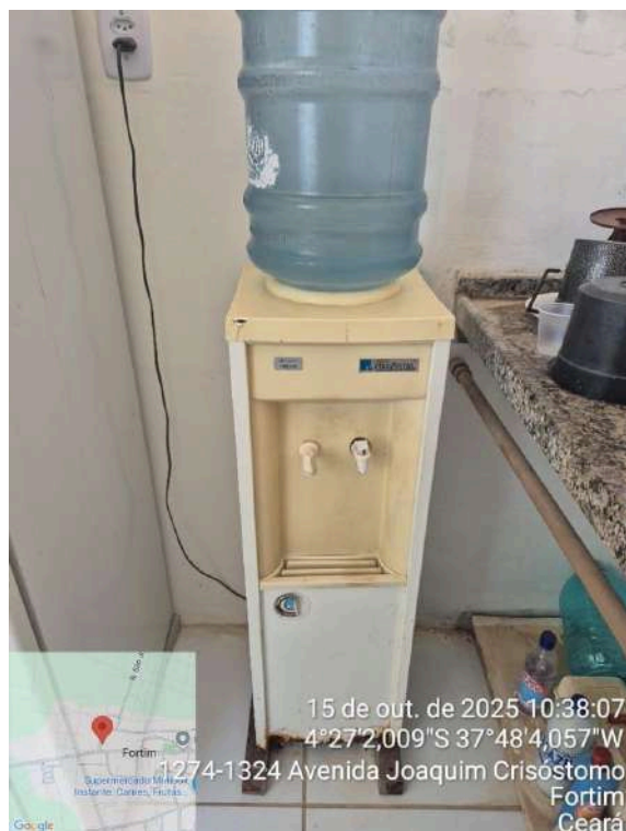
Foto 3 - Núcleo Operacional: Copa com geláguia com torneira quebrada e pés oxidados.
