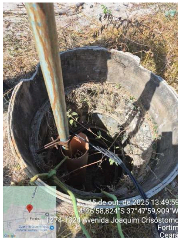
Foto 38 - PT-34: fiação pendurada com riscos de acidente e sem eletrodutos.
