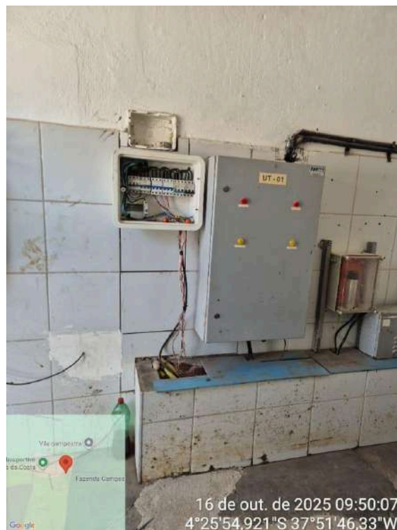
Foto 98 - Casa de Bombas: quadro de energia sem tampa e com fiação exposta.
