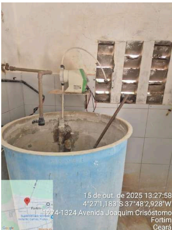
Foto 5 - Casa de Química / Laboratório: fiação da bomba sem proteção, preparo manual por operação sem máscara para manipulação.
