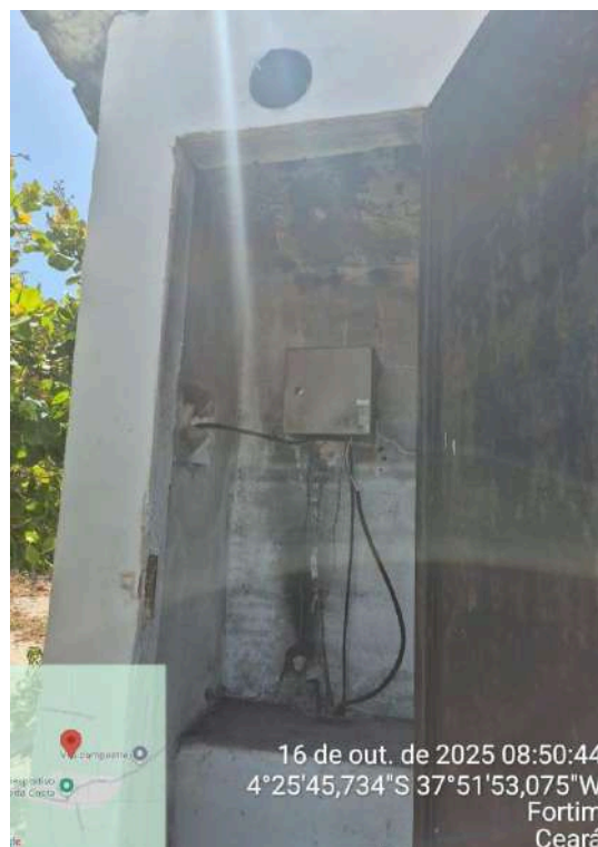
Foto 80 - Poço PT-21: Porta oxidada, sem lâmpada na parte externa do quadro de comando, quadro de comando com sujeidade.
