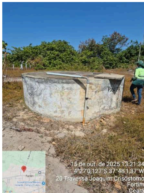
Foto 14 - Estruturas externas: Poço Amazonas, que vai ser usado para tratar rejeitos, está com pintura desgastada.
