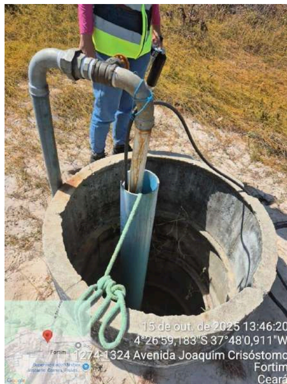
Foto 34 - PT-33: Bomba cavitando.
