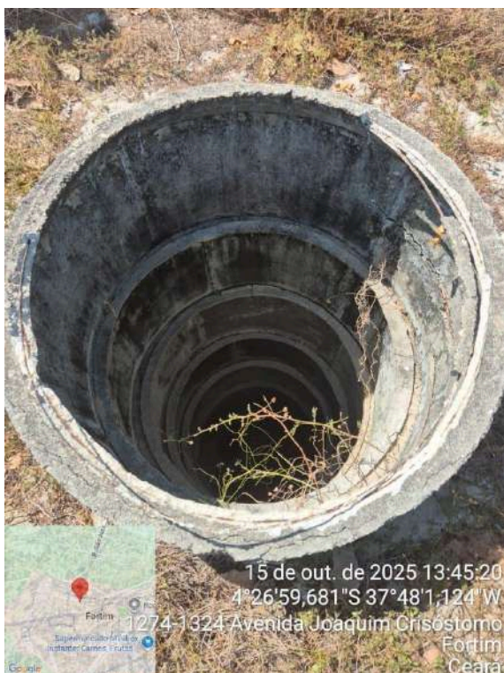
Foto 27 - Poços desativados (sem identificação): Necessário aterrar os poços, sem identificação com riscos de acidentes por não ter proteção.
