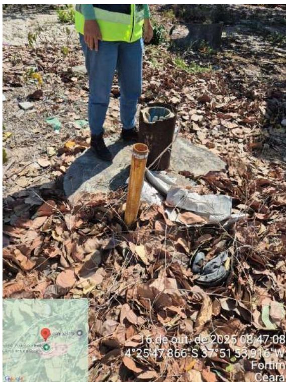
Foto 61 - Poços desativados (PT-23, PT-24, PT-26): Necessário fechamento dos poços, possível fonte de contaminação, com estruturas oxidadas, degradadas e com presença de ferro.
