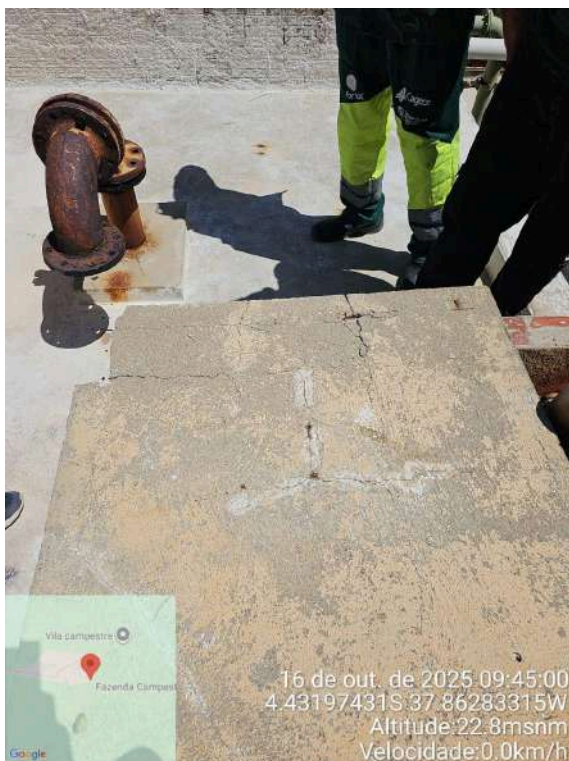
Foto 113 - RAP-01: rachadura na tampa.
