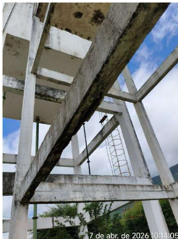
Foto 71 - REL - SEM DENOMINAÇÃO (Mumbaba): degradação avançada, com risco iminente de desmoronamento, anexo ao REL-03.
