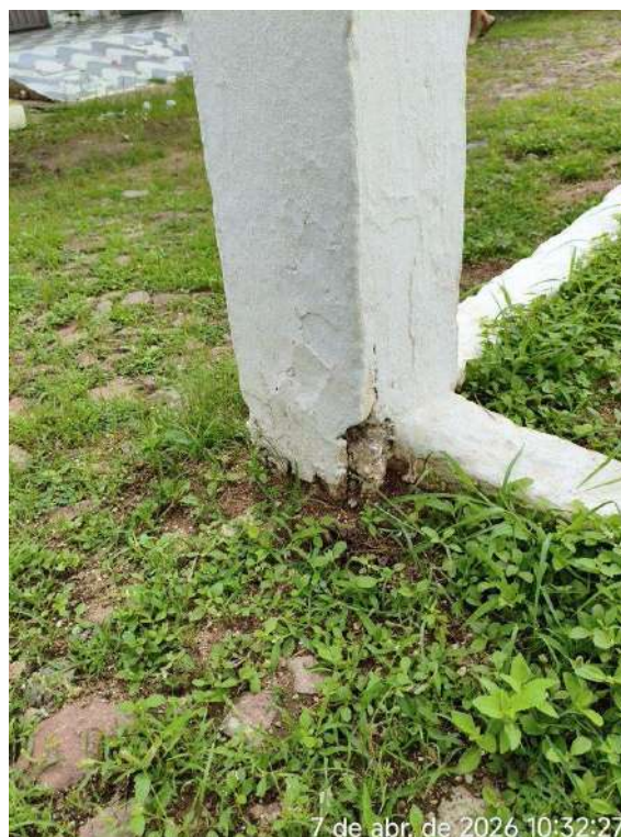
Foto 73 - REL - SEM DENOMINAÇÃO (Mumbaba): degradação avançada, com risco iminente de desmoronamento, anexo ao REL-03.
