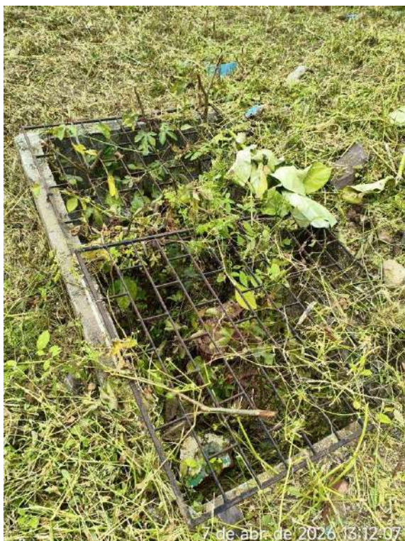
Foto 55 - Pátio (Massapê): caixa de proteção e inspeção com mato crescendo em seu interior.
