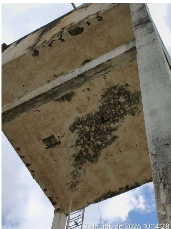
Foto 72 - REL - SEM DENOMINAÇÃO (Mumbaba): degradação avançada, com risco iminente de desmoronamento, anexo ao REL-03.
