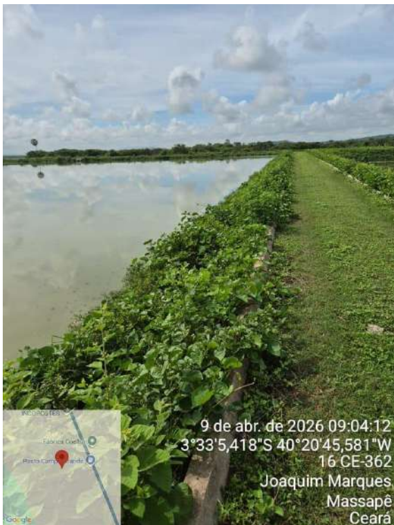
Foto 77 - ETE Massapê: Lagoa facultativa/maturação com excesso de vegetação no entorno.
