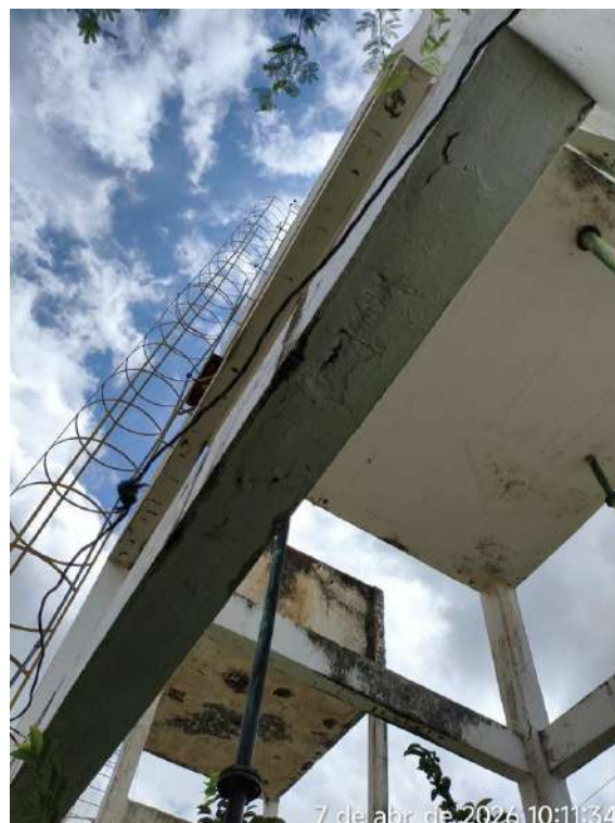
Foto 69 - REL-03 (Mumbaba): cabeamento elétrico fixo à escada de acesso metálica.
