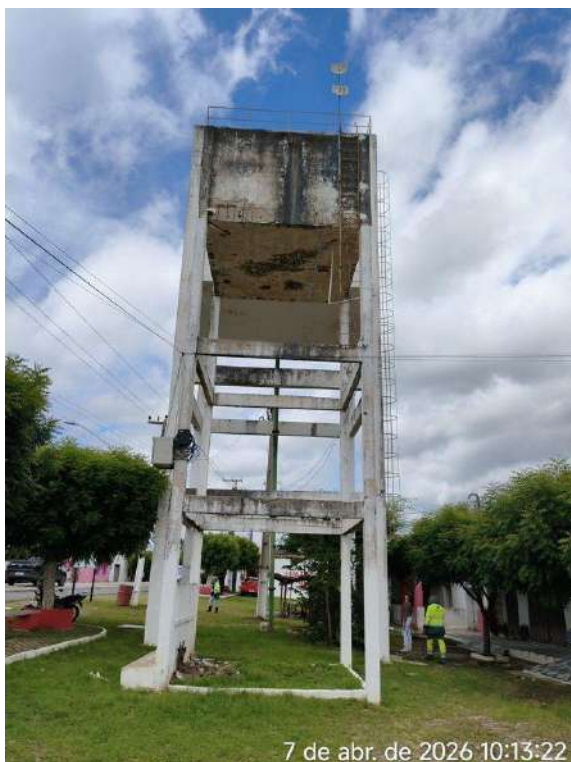
Foto 70 - REL - SEM DENOMINAÇÃO (Mumbaba): degradação avançada, com risco iminente de desmoronamento, anexo ao REL-03.
