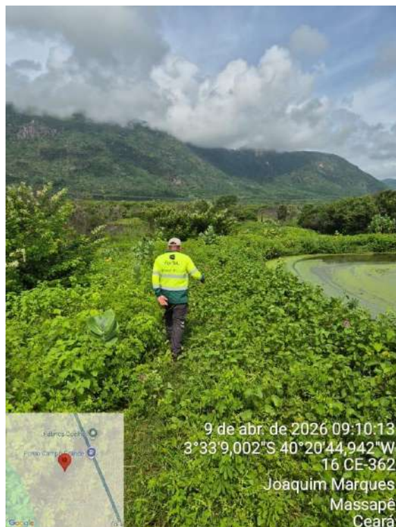
Foto 80 - ETE Massapê: Lagoa facultativa/maturação com excesso de vegetação nos taludes e entorno, dificultando o acesso.
