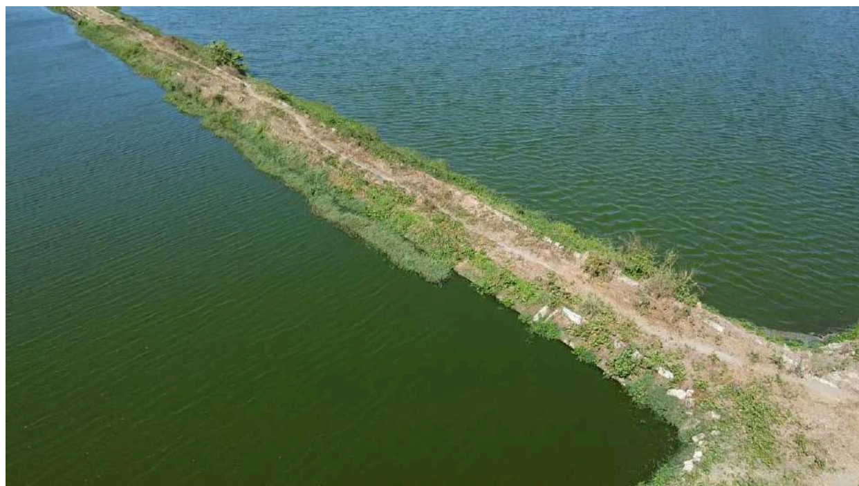
Foto 4 ausência de placas de proteção dos taludes.
