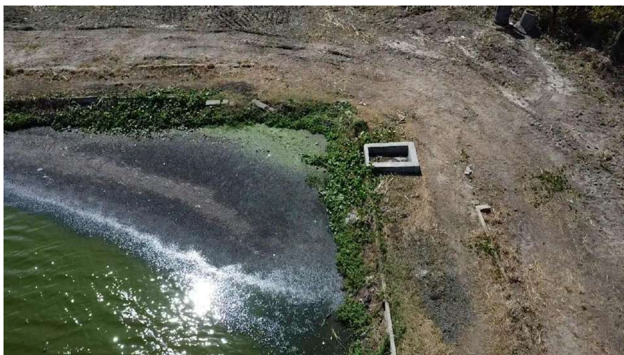
Foto 1 - Acúmulo de sobrenadante nas bordas da lagoa.
