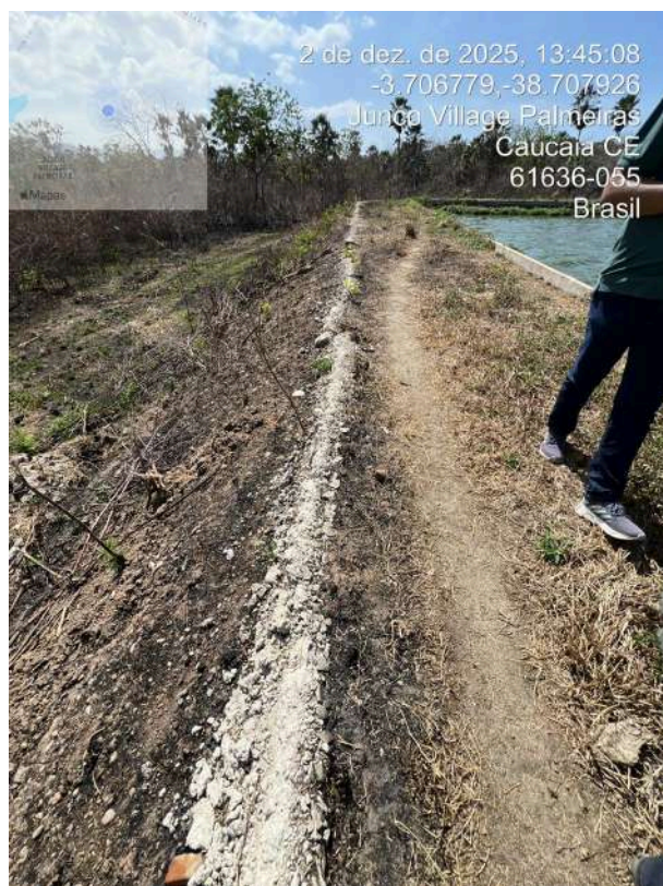
Foto 7 - Taludes sem guias.
