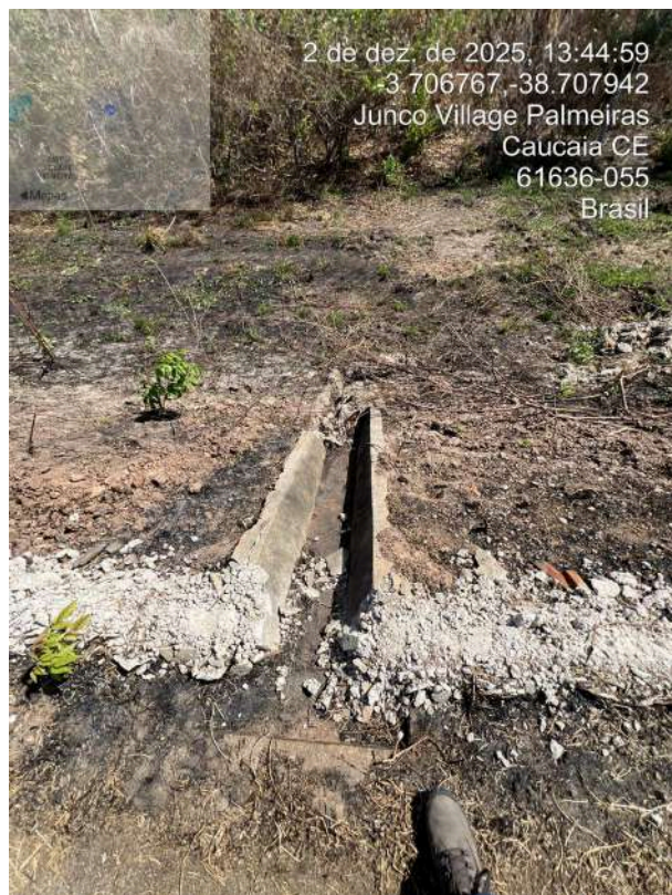
Foto 5 - calha de drenagem de água obstruída.
