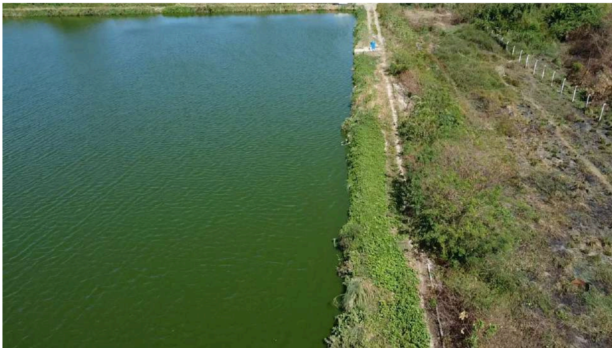
Foto 9 - Vegetação nos taludes das lagoas.
