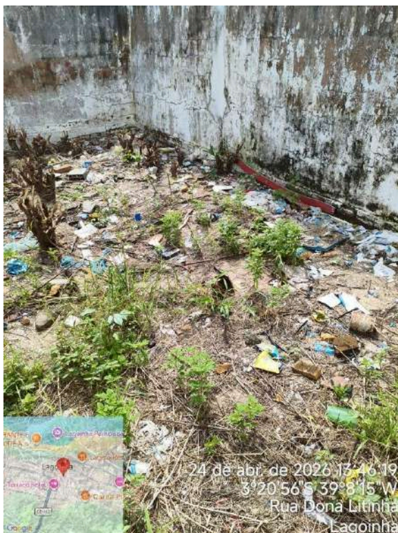
Foto 67 - PT-02 (Lagoinha): área do pátio com acúmulo de sujeira e resíduos sólidos lançados pela vizinhança.
