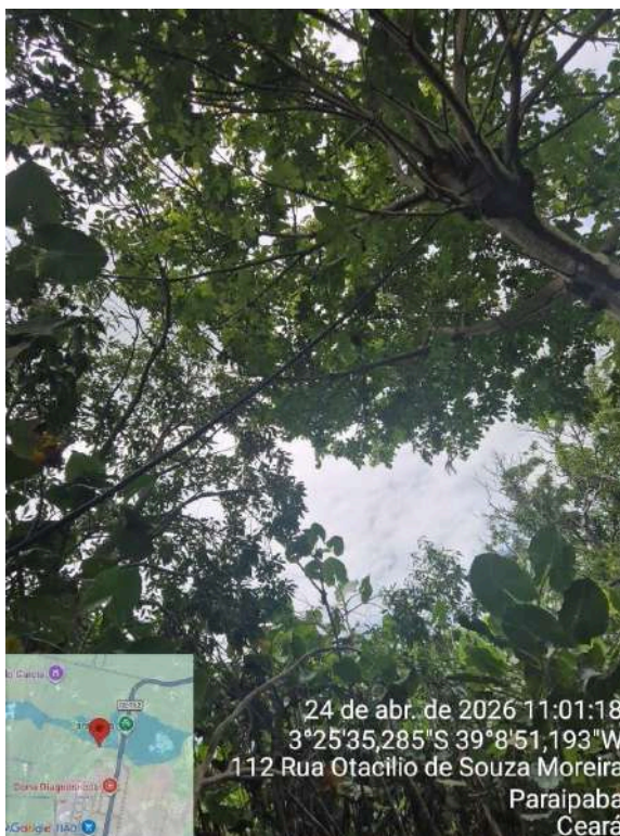
Foto 3 - Captação (sede): fiação sem proteção e solta.
