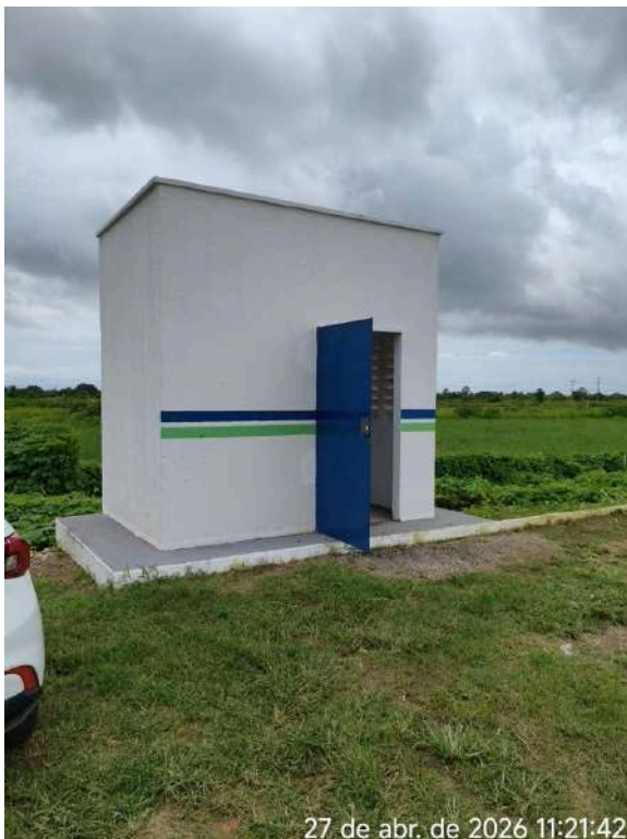
Foto 31 - ETE Paraipaba: casa de apoio sem água e sem energia elétrica.
