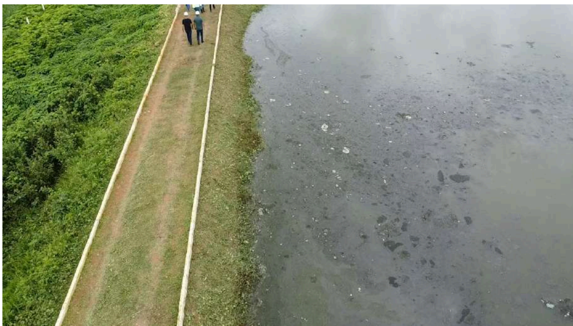
Foto 92- ETE Paraipaba : presença de sobrenadantes.
