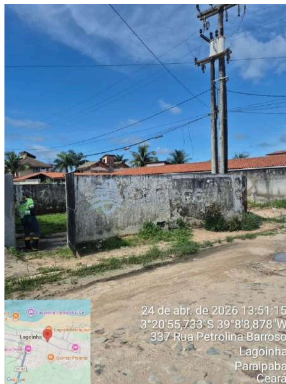
Foto 72 - PT-03 (Lagoinha): identificação e pintura desgastadas.
