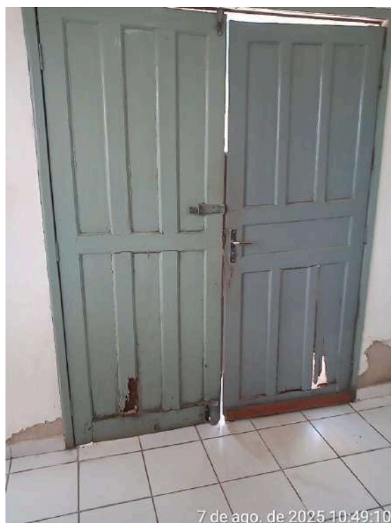
Foto 38 - Escritório: forro e paredes com pintura deteriorada, porta de entrada danificada.
