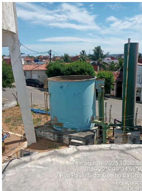
Foto 4 - Filtro: possui escada inadequada (sem gaiola de proteção) e ausência de tampa de vedação, inclusive da caixa de saída de água pós filtração.
