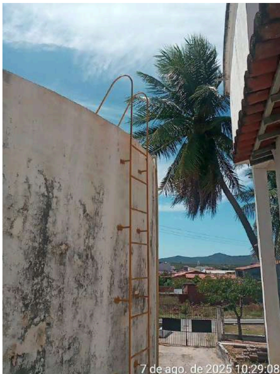
Foto 5 - RAP-01: escada tipo marinheiro (sem gaiola de proteção e guarda corpo acima do patamar superior).
