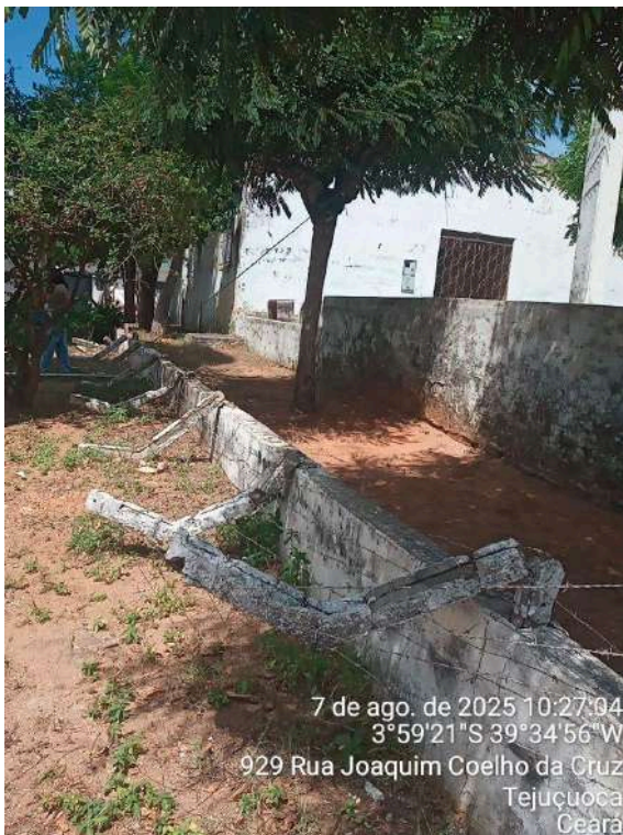
Foto 13 - ETA: apresenta pintura degradada e cercamento desmoronado.
