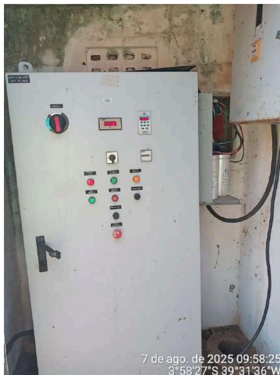
Foto 10 - Captação: as instalações elétricas estão inadequadas com fio/cabo sem eletroduto de isolamento e proteção.
