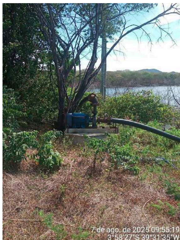
Foto 7 - Captação : a área da estação de bombeamento encontra-se envolvida com vegetação crescida e não dispõe de isolamento físico adequado.
