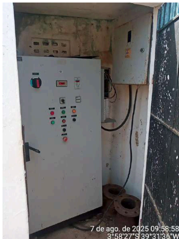
Foto 9 - Captação: a casa de comando elétrico apresenta pintura deteriorada e armazenamento inadequado de materiais, com acúmulo de sujeira no local.
