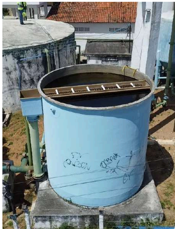
Foto 18 - Filtro Ascendente: pintura desgastada e identificação ilegível.
