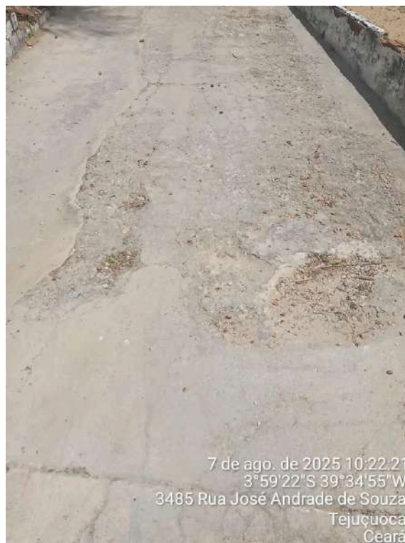
Foto 16 - ETA: pavimentação degradada.
