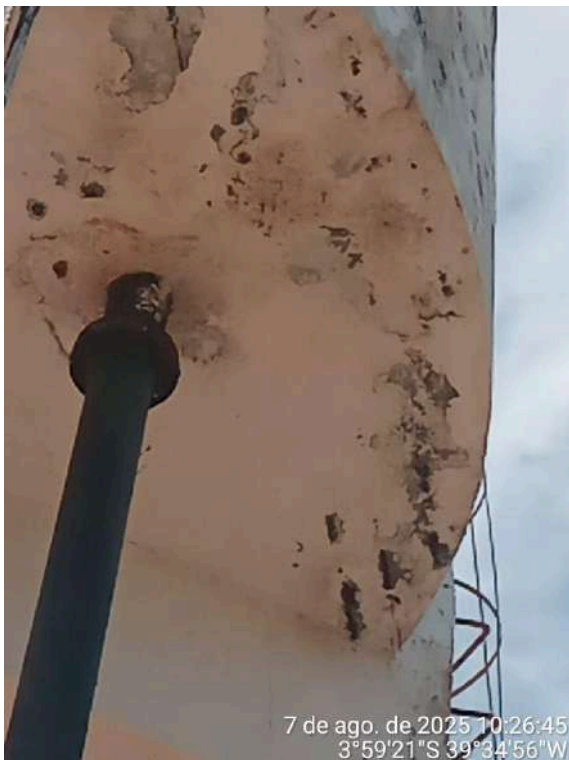
Foto 20 - REL-01: o reservatório elevado apresenta pintura desgastada, armadura exposta e vazamentos visíveis.
