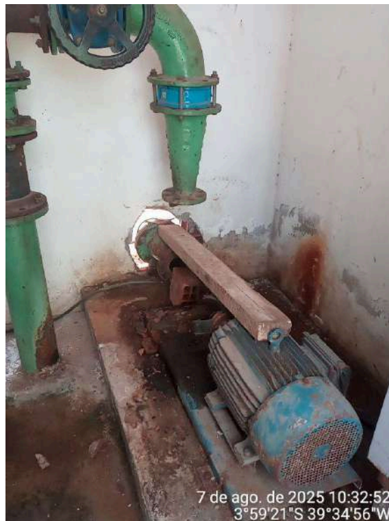
Foto 24 - EEAT-01: a estação elevatória de água tratada tem a pintura deteriorada, buracos inacabados em paredes e estruturas e acúmulo de água e sujeira.
