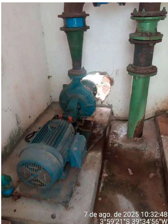
Foto 25 - EEAT-01: pintura deteriorada, buracos inacabados em paredes e estruturas e acúmulo de água e sujeira.
