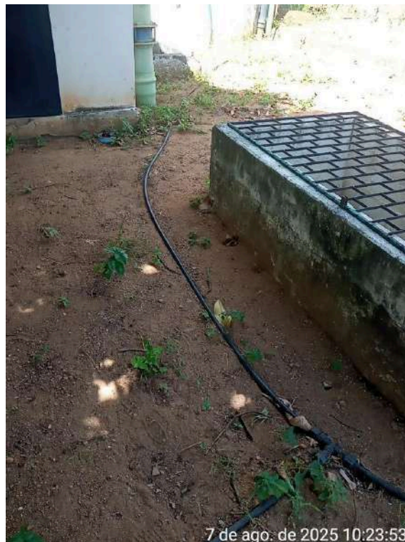
Foto 32 - Laboratório / Casa de Química / Cloração: tubulação/mangueira sobre o piso em área de circulação.
