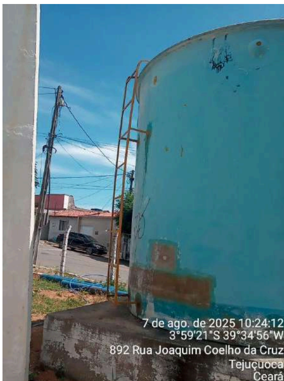
Foto 3 - Filtro possui escada inadequada (sem gaiola de proteção e guarda corpo acima do patamar superior) .
