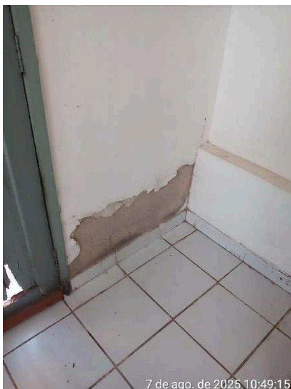
Foto 37 - Escritório: forro e paredes com pintura deteriorada, porta de entrada danificada.
