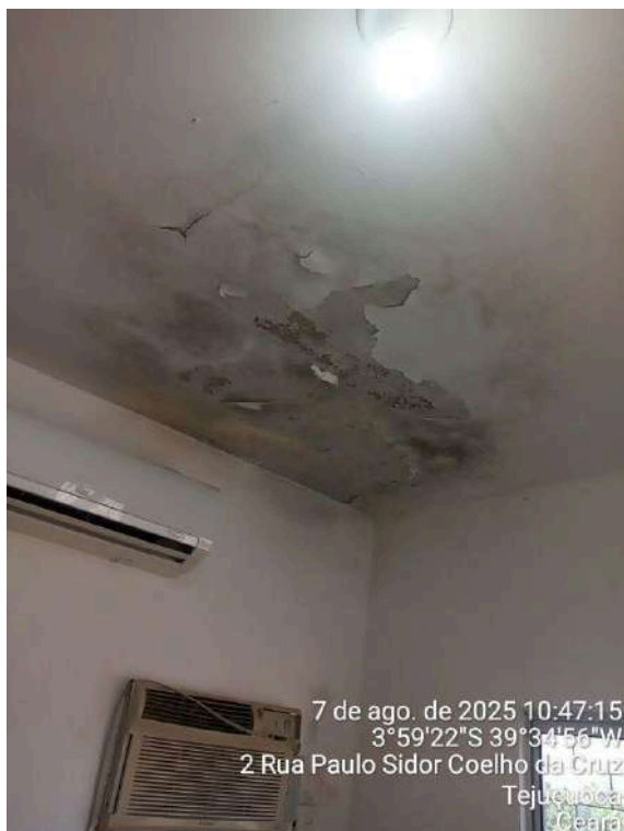
Foto 35 - Escritório: forro e paredes com pintura deteriorada.
