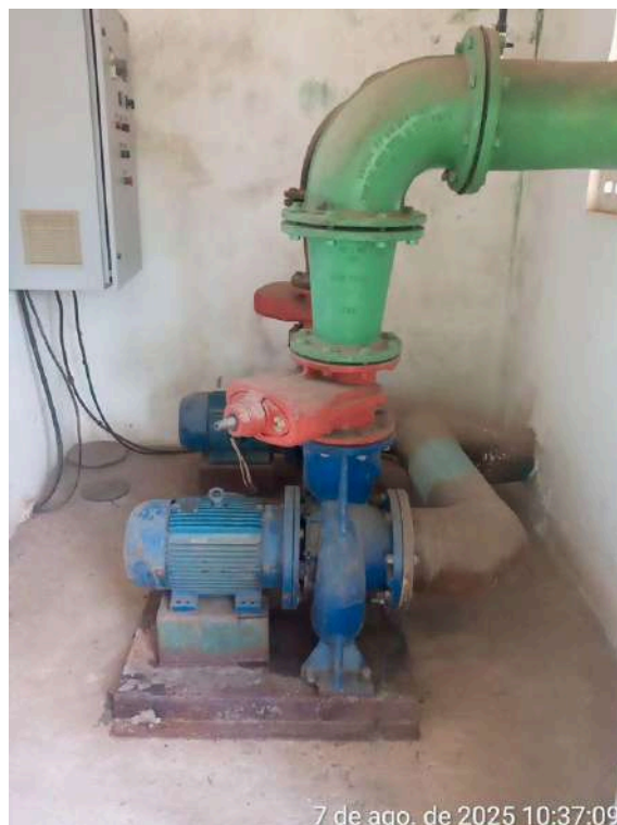
Foto 28 - EELF-01: pintura deteriorada e instalações elétricas inadequadas, com fios/cabos soltos sobre o piso e sem eletroduto de isolamento e proteção.
