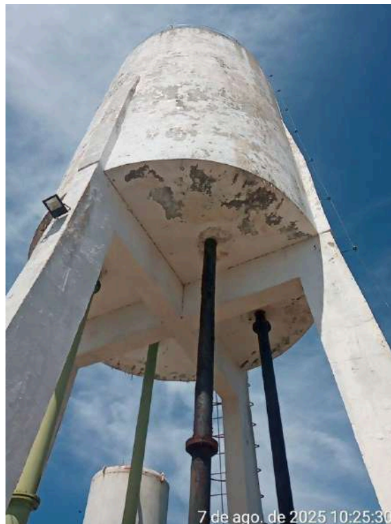
Foto 21 - REL-01: o reservatório elevado apresenta pintura desgastada, armadura exposta e vazamentos visíveis.
