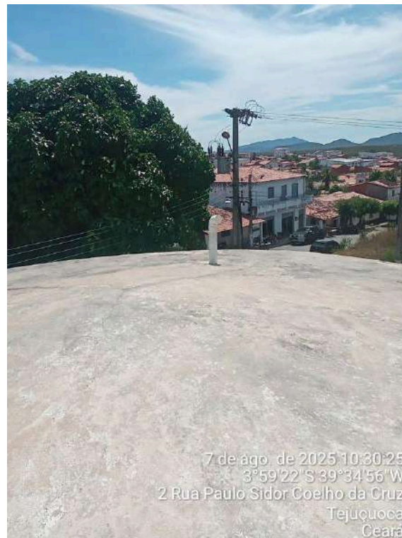
Foto 6 - RAP-01: tubulação de ventilação inadequada (sem a curvatura para baixo).
