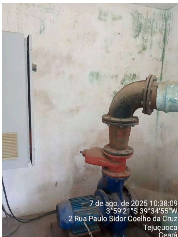
Foto 29 - EELF-01: pintura deteriorada e instalações elétricas inadequadas, com fios/cabos soltos sobre o piso e sem eletroduto de isolamento e proteção.
