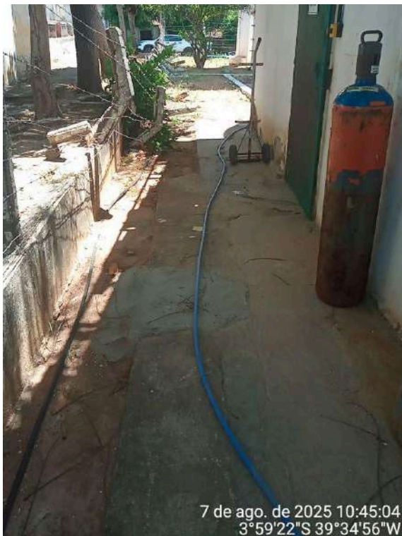
Foto 31 - Laboratório / Casa de Química / Cloração: tubulação/mangueira sobre o piso em área de circulação.
