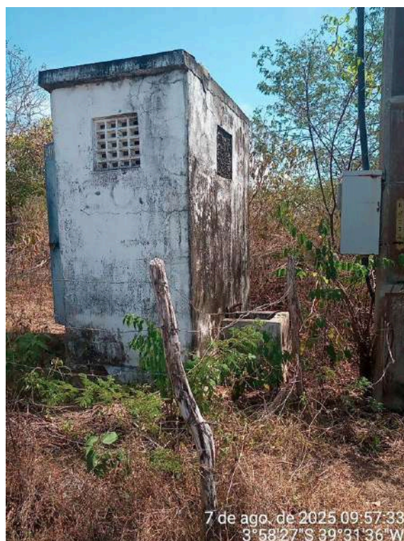
Foto 8 - Captação : a casa de comando elétrico encontra-se com a cerca de proteção e isolamento da instalação danificada e apresenta pintura deteriorada.
