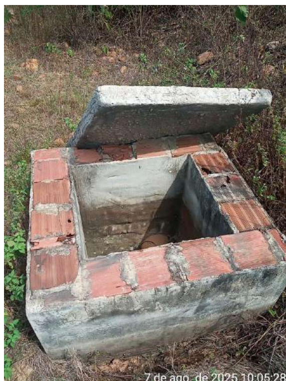
Foto 11 - Captação: caixa de inspeção com a tampa fora de posição.
