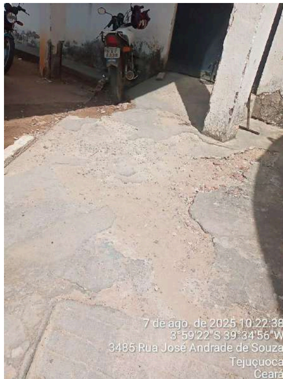
Foto 14 - ETA: pavimentação degradada.
