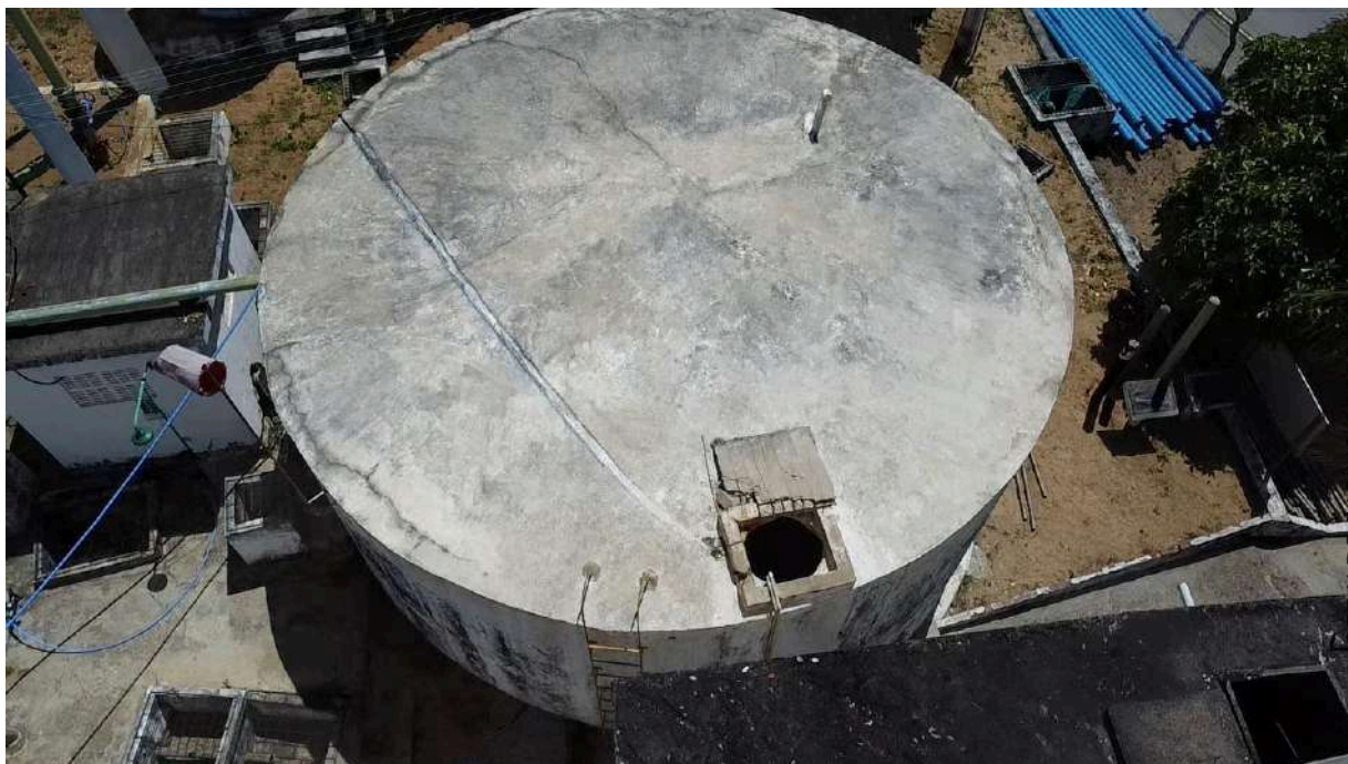
Foto 22 - RAP-01: está com pintura deteriorada e identificação ilegível, tampa da abertura de inspeção quebrada e tubulação instalada através da abertura de inspeção.
