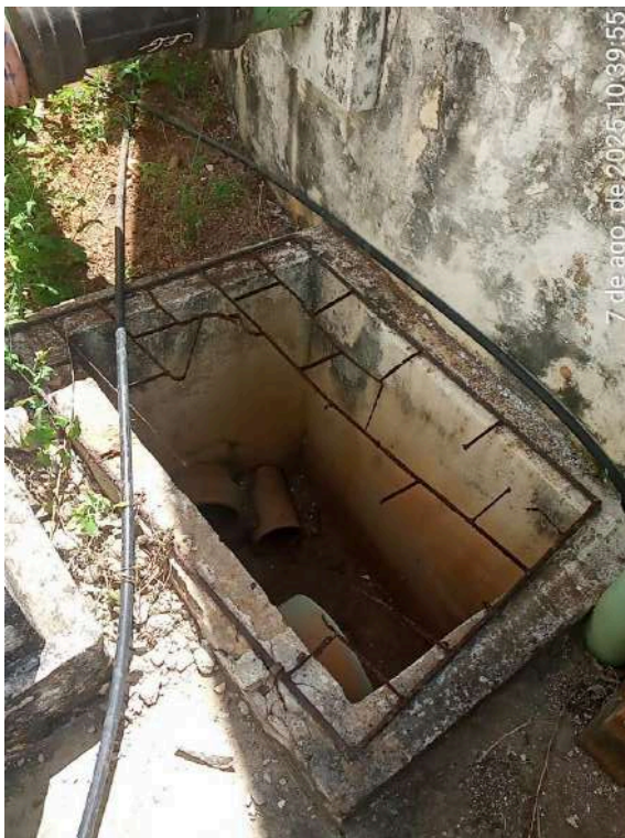
Foto 17 - ETA: caixa de proteção com tampa/grade danificada.
