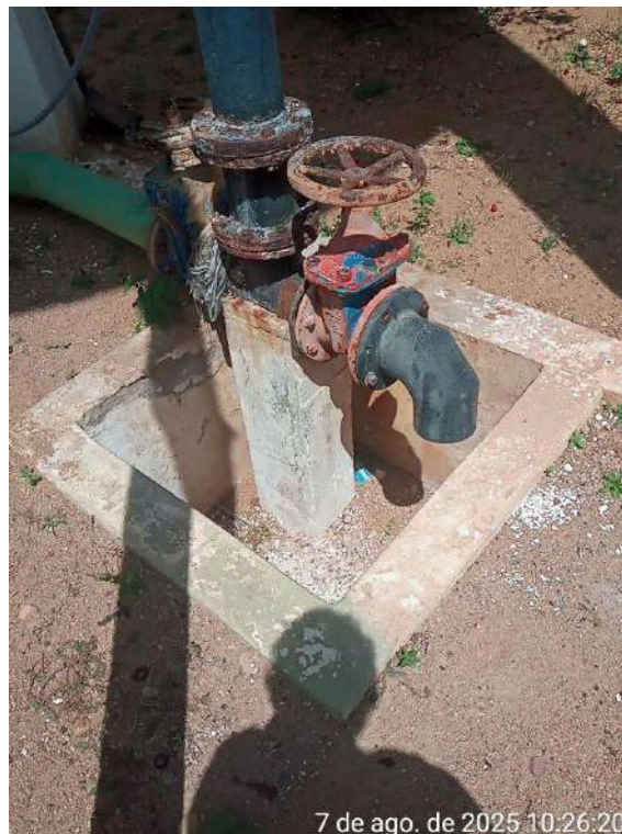
Foto 2 - ETA: caixa sem tampa/grade de proteção.
