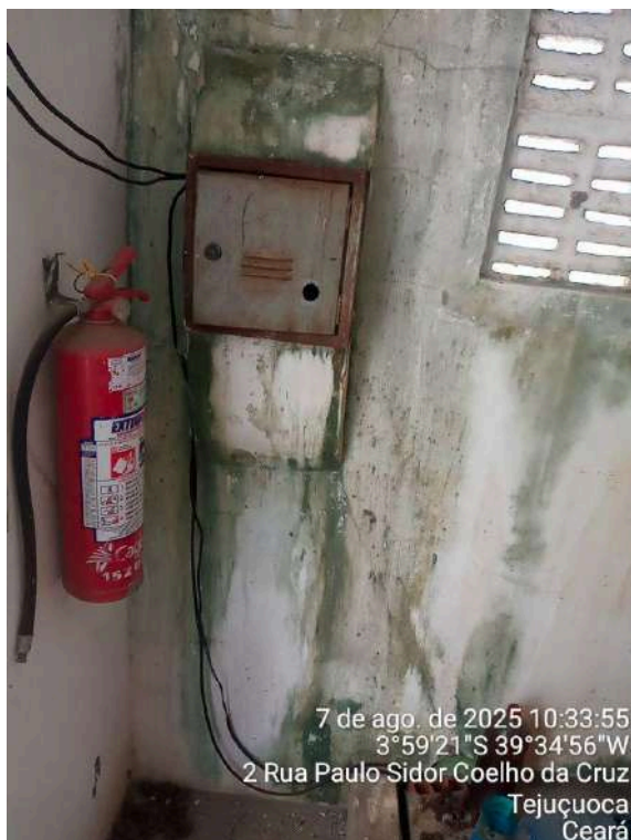
Foto 27 - EEAT-01: pintura deteriorada, instalações elétricas fora do padrão técnico, com fios / cabos sem eletroduto de isolamento e proteção.
