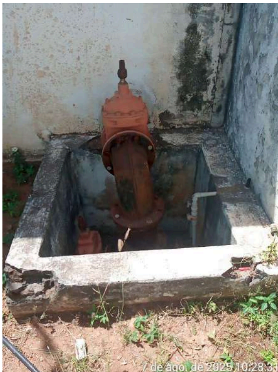
Foto 1 - ETA: caixa sem tampa/grade de proteção.
