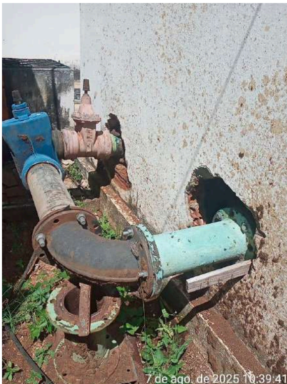
Foto 23 - EEAT-01: pintura deteriorada, buracos inacabados em paredes.
