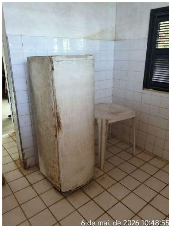
Foto 80 - ETA / refeitório / sala de apoio: com ausência de mobiliário adequado para o uso dos funcionários.
