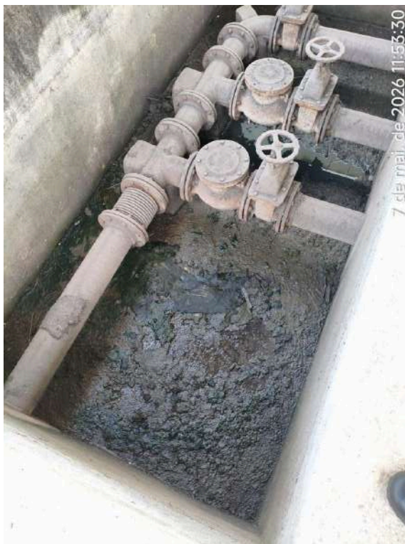
Foto 110 - EEE-04: Unidade com acúmulo e depósito de lama concentrada no fundo do fosso.
