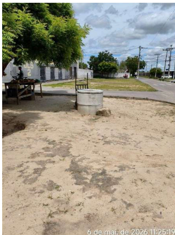
Foto 32 - PT-07: Ausência de identificação do poço.
