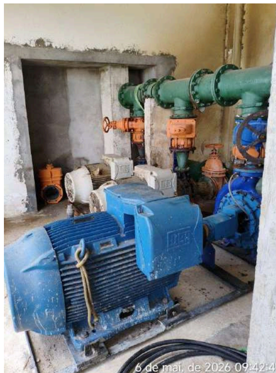
Foto 63 - Captação / EEAB-01: pintura das paredes.
