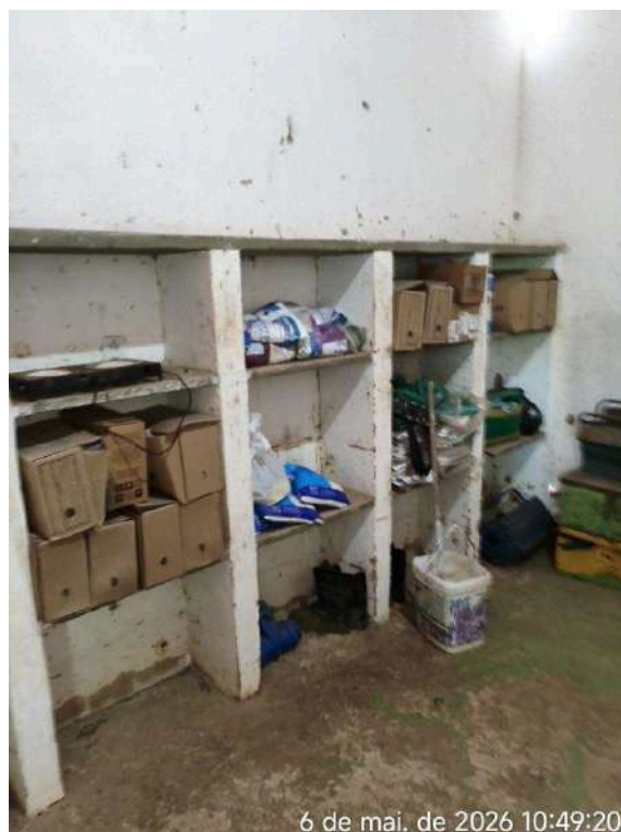
Foto 82 - ETA / refeitório / sala de apoio: com ausência de mobiliário adequado para o uso dos funcionários.
