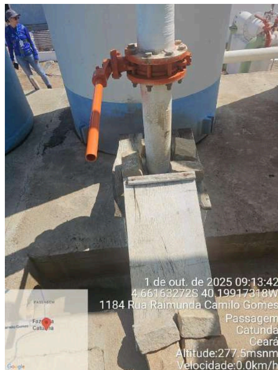
Foto 10 - ETA / estruturas: tubulação frouxa ou com algum outro problema.
