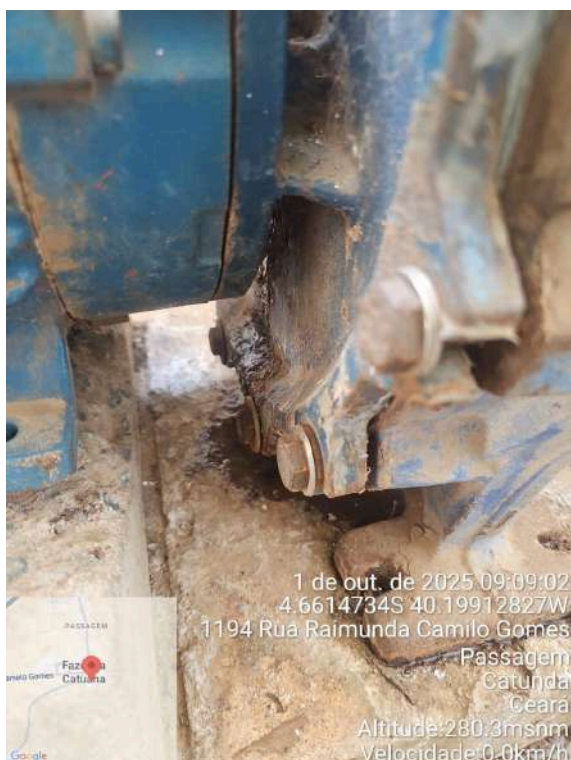
Foto 11 - ETA / Bomba: apresenta vazamento.
