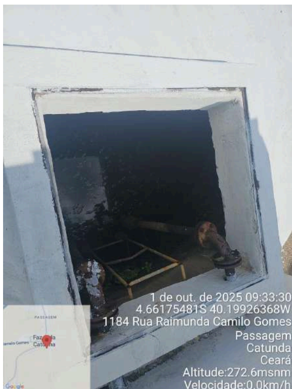
Foto 4 - ETA / RSE: escada quebrada; tubulação e tampa oxidadas.
