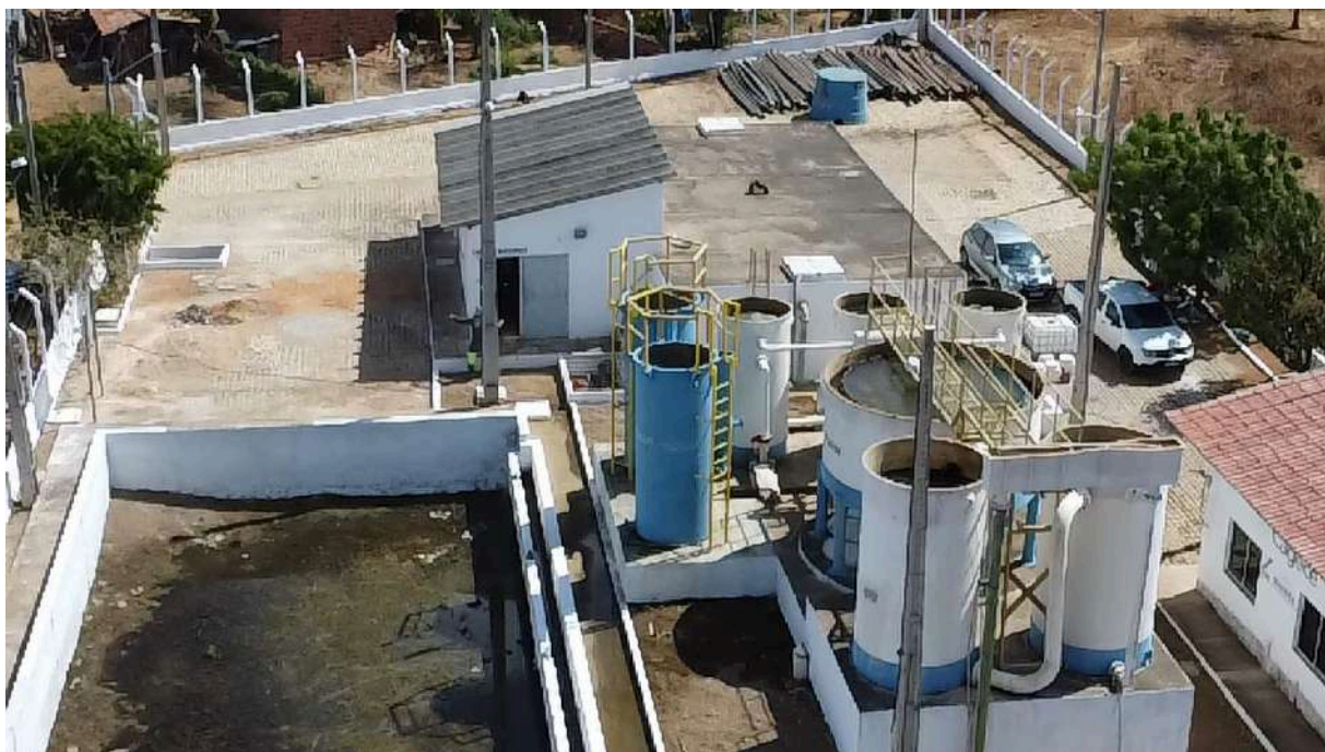
Foto 1 - RAP-01: sem guarda corpo no patamar superior.
