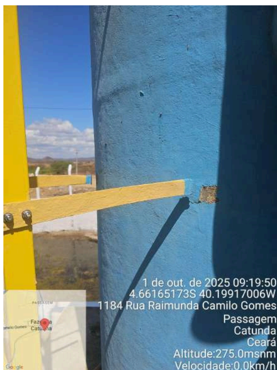
Foto 7 - ETA / filtro: a escada está solta.
