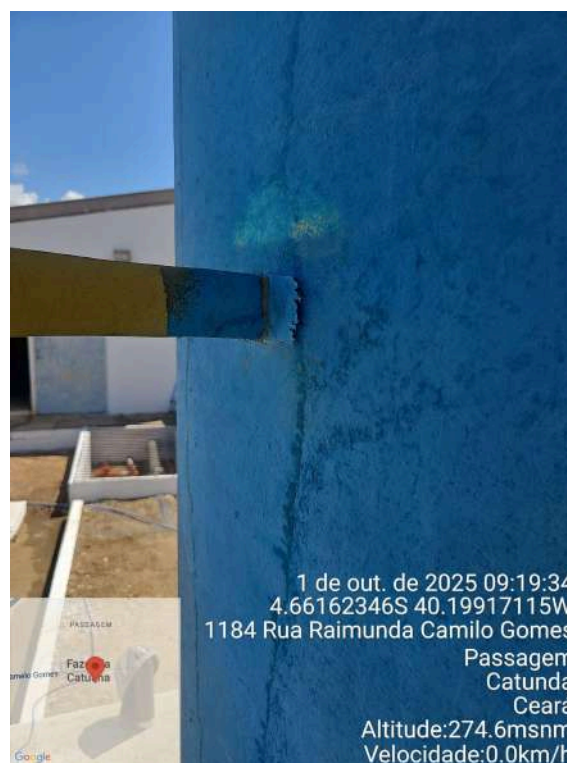
Foto 8 - ETA / filtro: a escada está solta.
