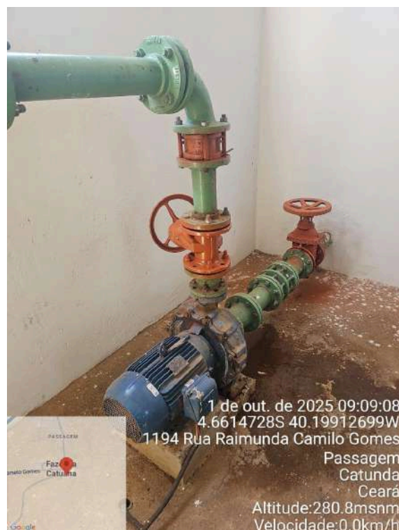
Foto 12 - ETA / Bomba: apresenta vazamento.
