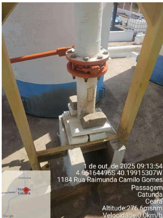
Foto 9 - ETA / estruturas: tubulação frouxa ou com algum outro problema.
