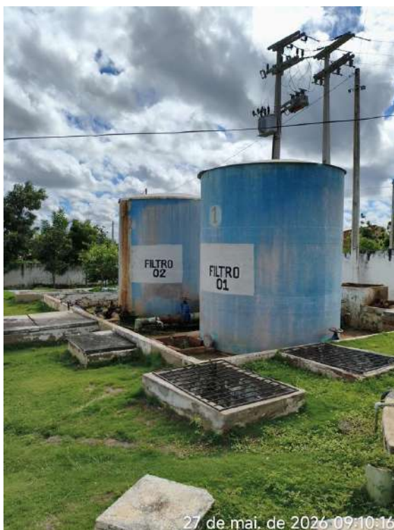
Foto 5 - ETA / Filtros: escada de acesso inadequada e pintura desgastada.
