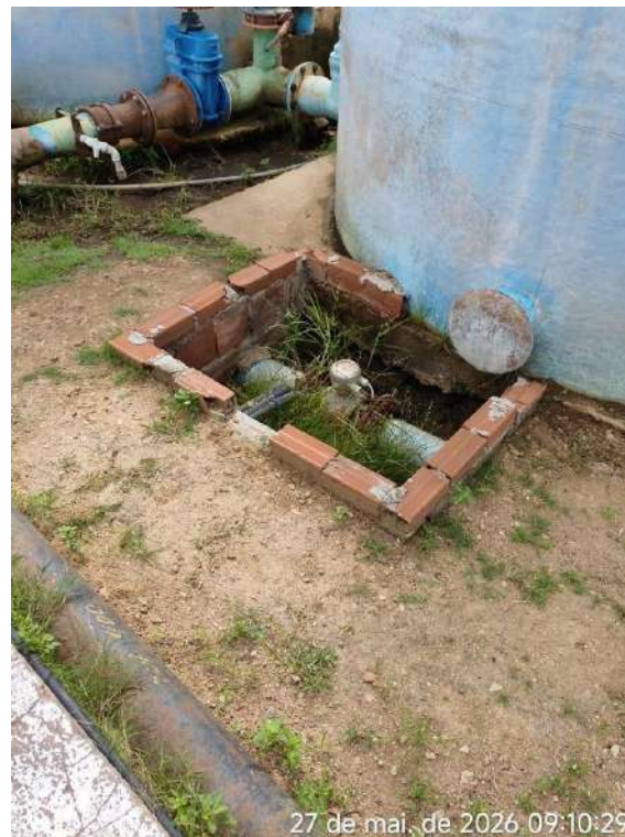
Foto 4 - ETA / Pátio: caixa inacabada, desprovida de tampa ou grade de proteção.
