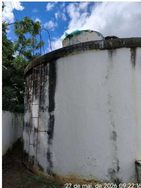
Foto 16 - ETA / RAP-02: escada inadequada.
