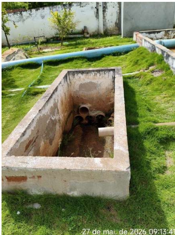
Foto 3 - ETA / Pátio: caixa desprovida de tampa ou grade de proteção.
