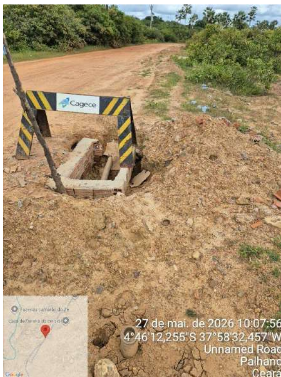
Foto 57 - RAP-03 / EERD-01: caixa inacabada, próximo ao reservatório.
