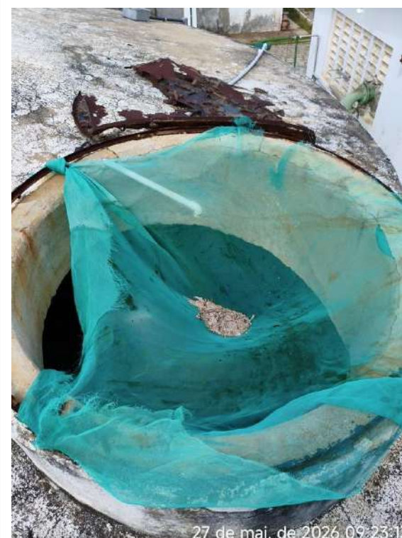
Foto 18 - ETA / RAP-02: ausência de tampa na abertura de inspeção.
