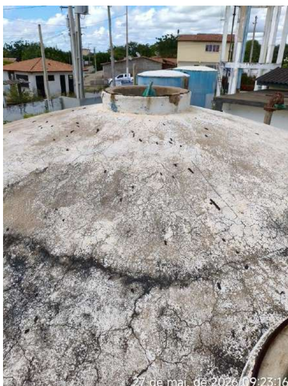
Foto 17 - ETA / RAP-02: ausência de tampa na abertura de inspeção.
