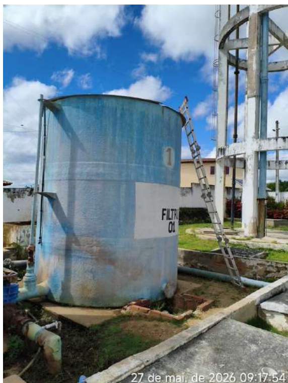
Foto 6 - ETA / Filtros: escada de acesso inadequada.
