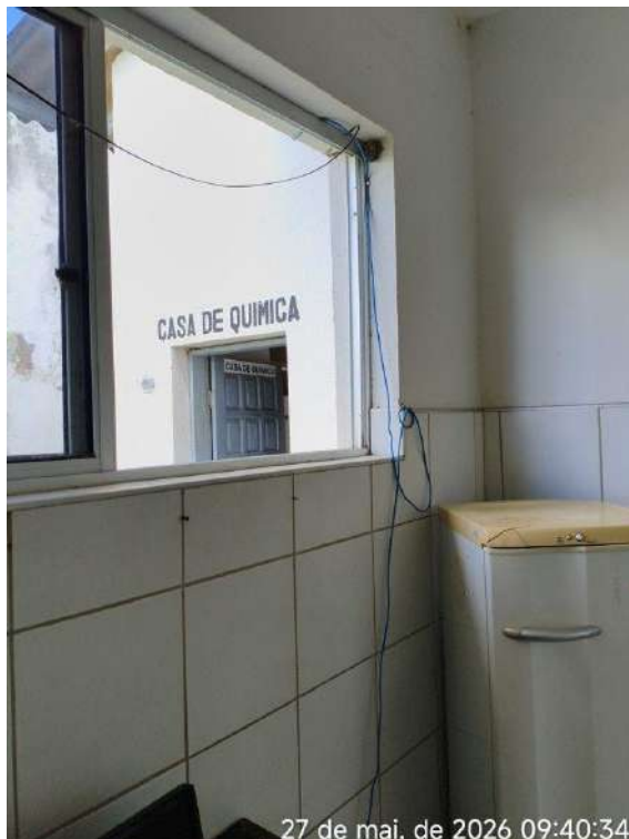
Foto 15 - ETA / Casa de Química / Laboratório: fiação instalada sem proteção e isolamento, conduzida através de vão de janela.
