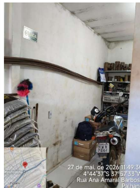
Foto 26 - Escritório / Almoxarifado: almoxarifado instalado no mesmo ambiente da copa e apoio aos funcionários.
