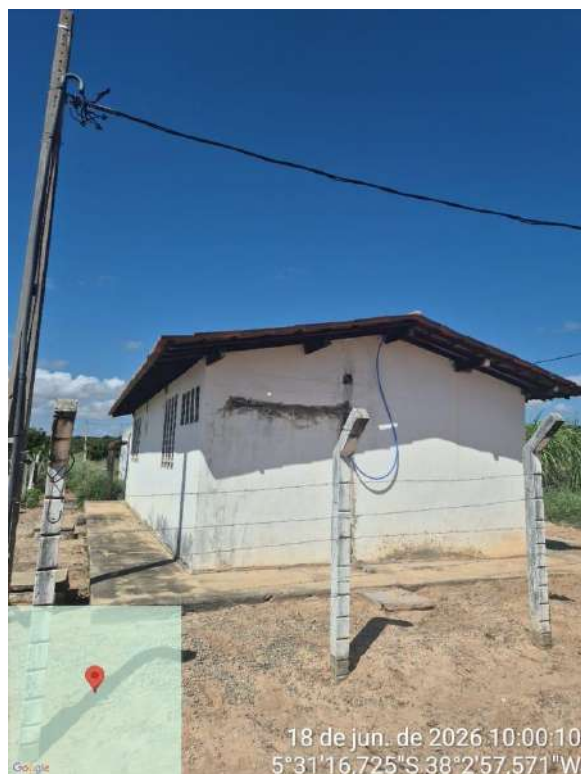
Foto 4 - EEAT-04: sem identificação.
