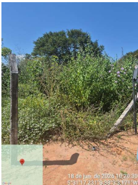
Foto 17 - PT-19: cerca danificada.
