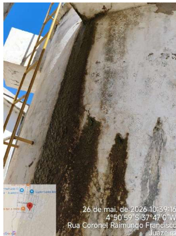
Foto 49 - Filtros: vazamento.
