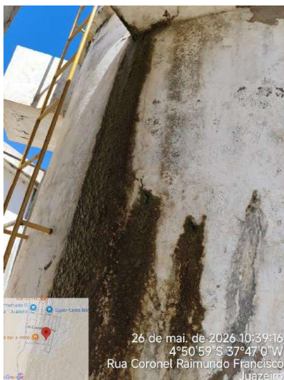
Foto 50 - Filtros: vazamento.
