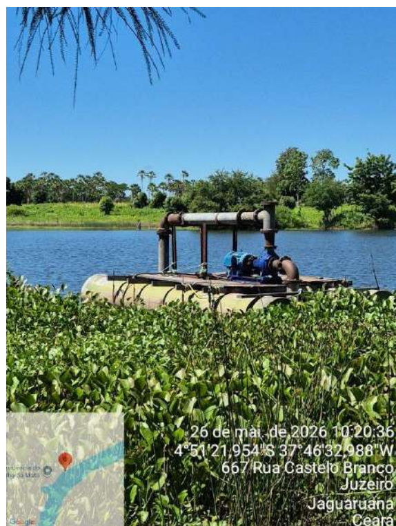
Foto 39 - Captação / Flutuante: presença de macrófitas próximo ao flutuante.
