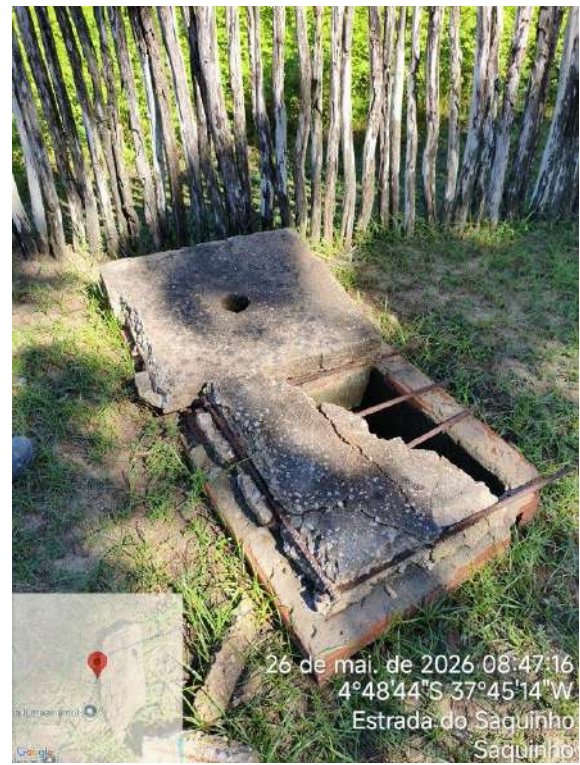
Foto 76 - Caixa de descarga (Saquinho): tampa danificada.
