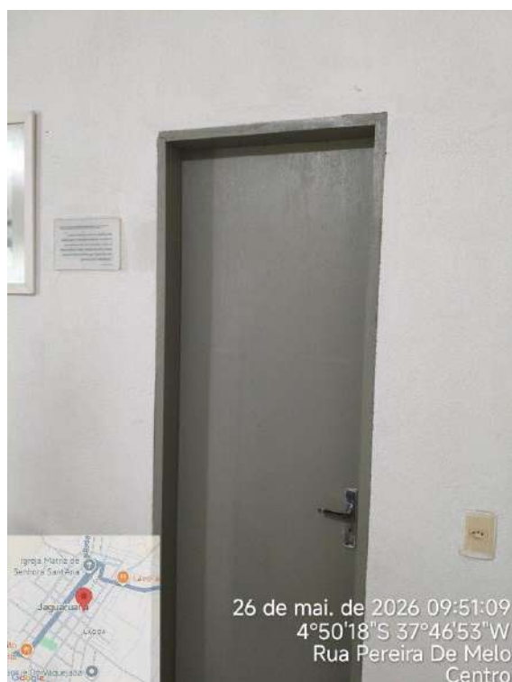
Foto 33 - Escritório de Atendimento: banheiro sem identificação.
