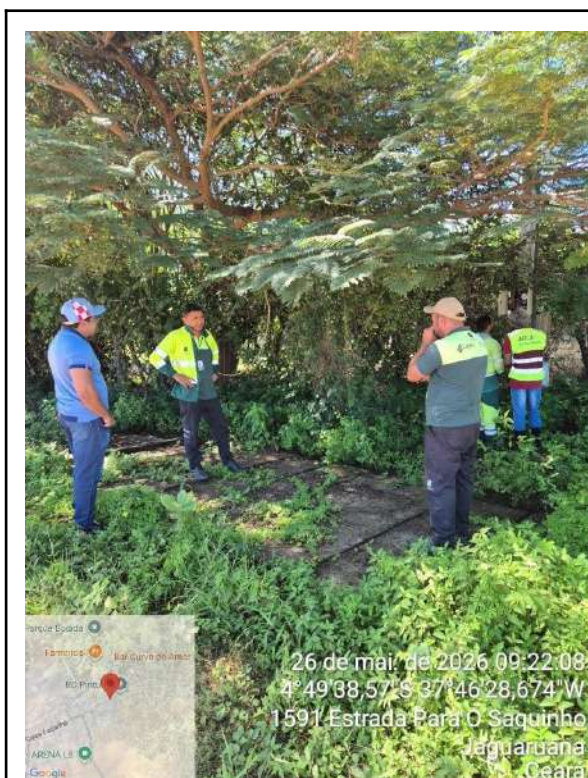
Foto 35 - Booster EERD-03 (Saquinho): Infraestrutura e instalações sem isolamento perimetral de proteção e controle de acesso.
