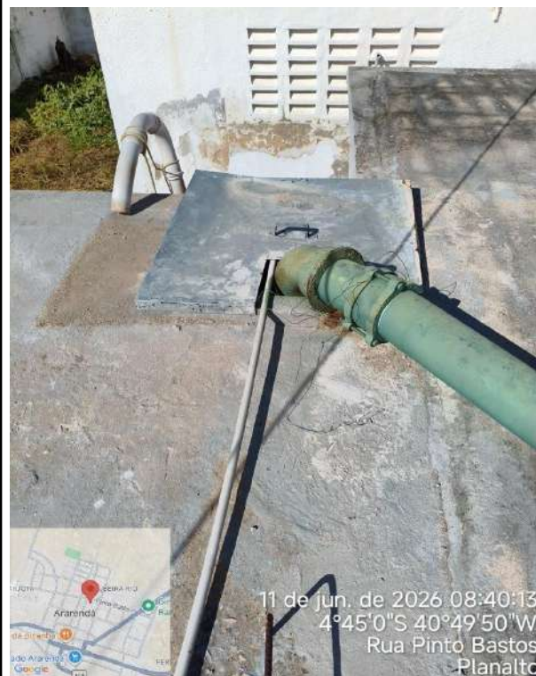
Foto 16 - RAP-01: tubulações instaladas através da abertura de inspeção.
