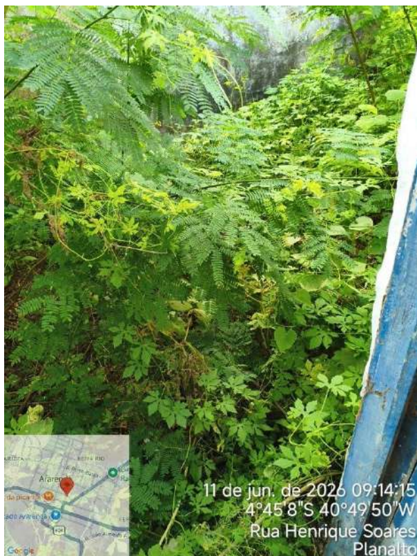
Foto 27 - Poço PT-01: proliferação de vegetação no pátio externo.
