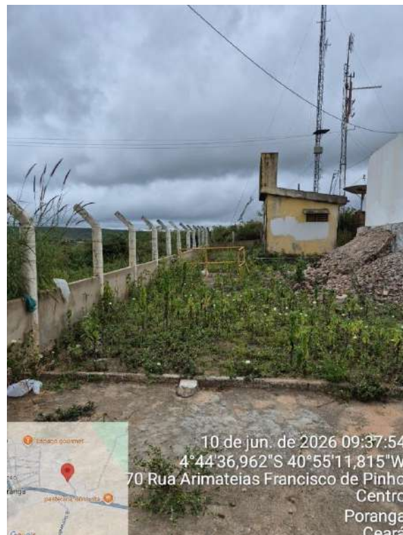
Foto 104 - RAP-01: prédio anexo (abrigo da antena da Prefeitura).
