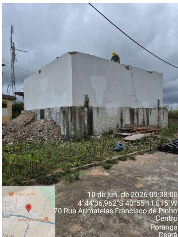
Foto 35 - RAP-01: ausência de identificação; unidade em obras de recuperação.
