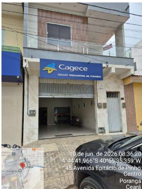
Foto 99 - Núcleo / escritório CAGECE: fachada do núcleo.
