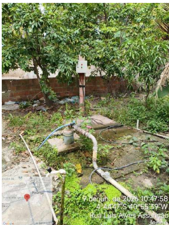
Foto 3 - PT-03: Cabeamento exposto sobre o piso, sem isolamento de proteção.
