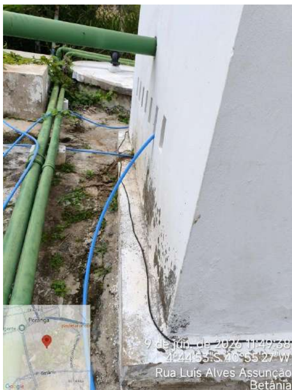
Foto 31 - EEAT-03: tubulação instalada através de cobogós.
