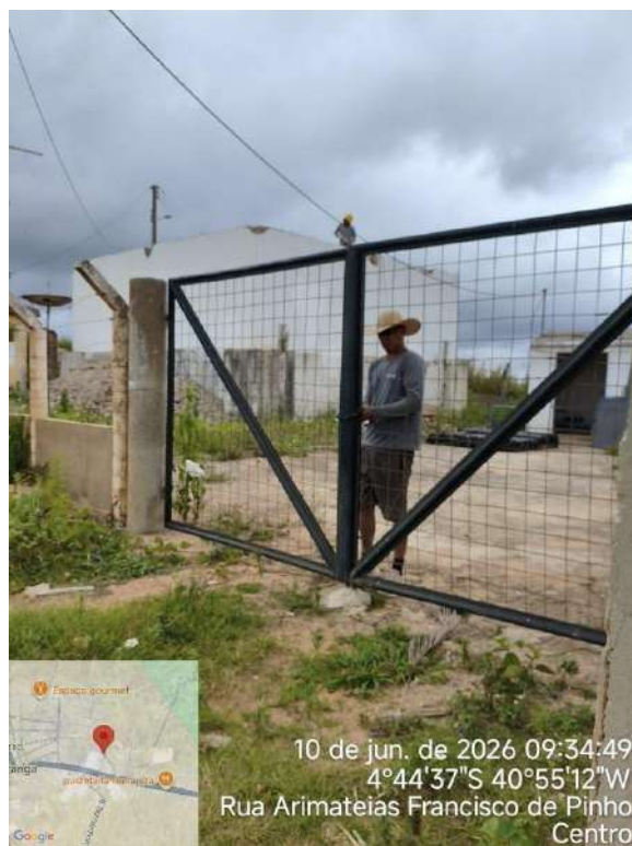
Foto 32 - RAP-01: unidade sem identificação.
