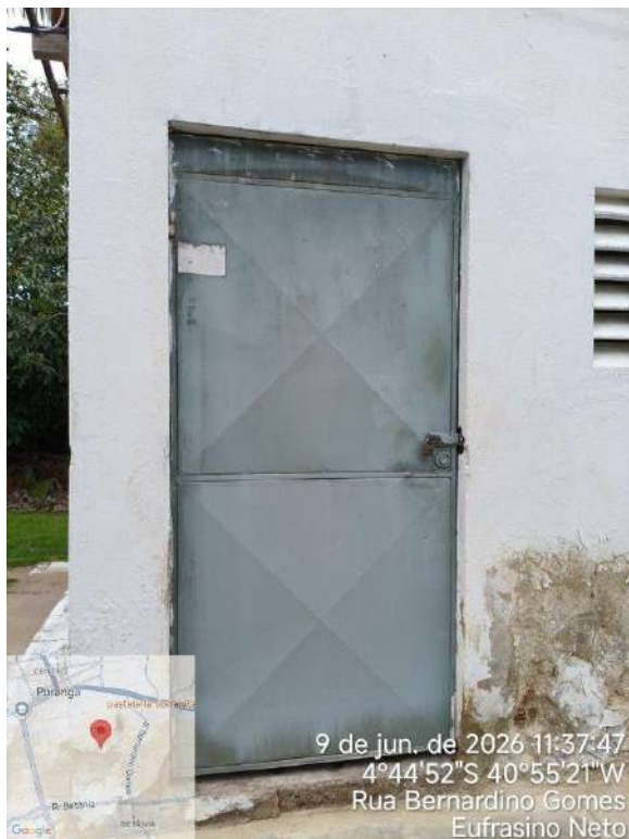
Foto 13 - Almojarifado: unidade desprovida de identificação.
