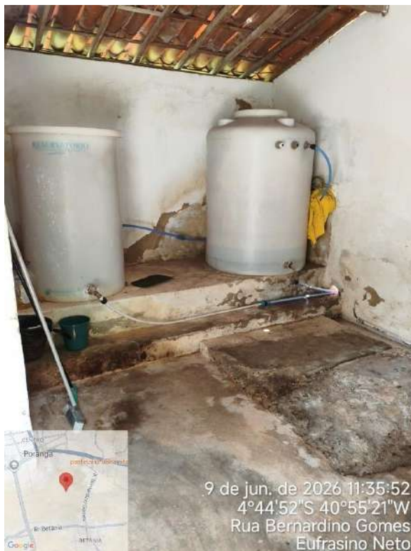
Foto 17 - EEAT-01 / CASA DE QUÍMICA: elevatória removida.
