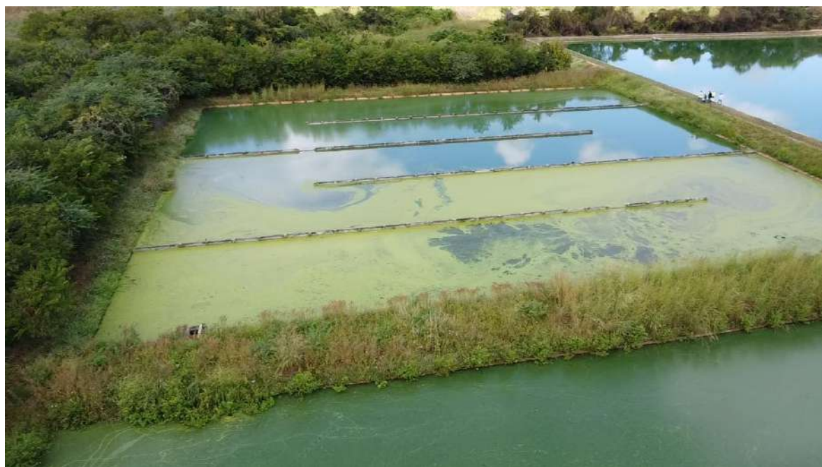
Foto 63 - ETE: taludes com vegetação densa sobre a área de circulação.
