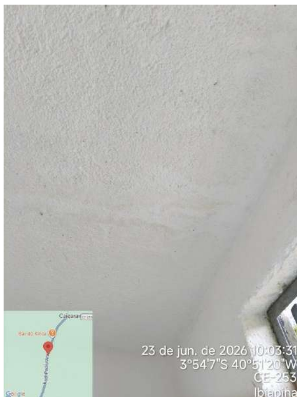
Foto 53 - REL-07: sem iluminação interna na casa de comando.
