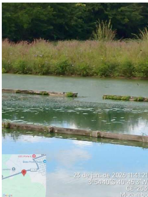
Foto 59 - ETE: chicanas danificadas e crescimento de vegetação.
