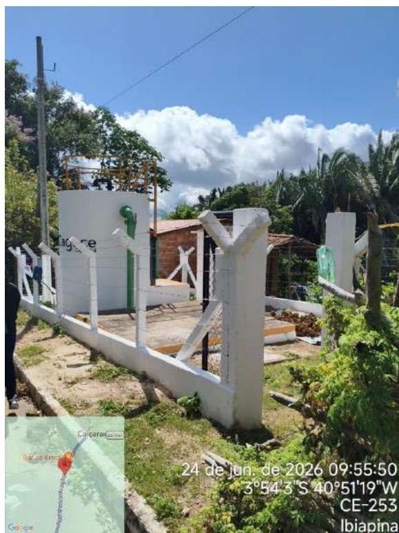
Foto 23 - DQP-03: área externa sem iluminação.
