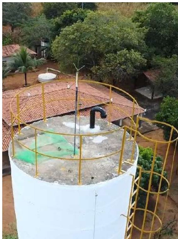
Foto 16 - REL-05: sem identificação; abertura de inspeção sem gola ou bordas verticais.
